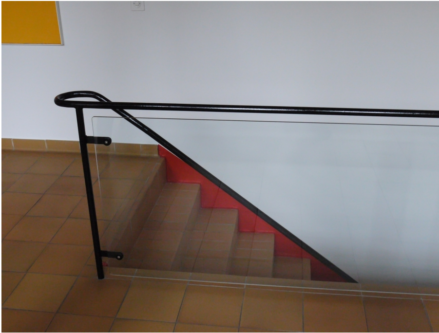
Wohn- und Atelierhaus Bill, Wohn- und Atelierhaus (Vers. Nr. 00736), Treppe vom Atelier im EG ins Malatelier im UG, 16.05.2015 (Bild Nr. D100601_43).
