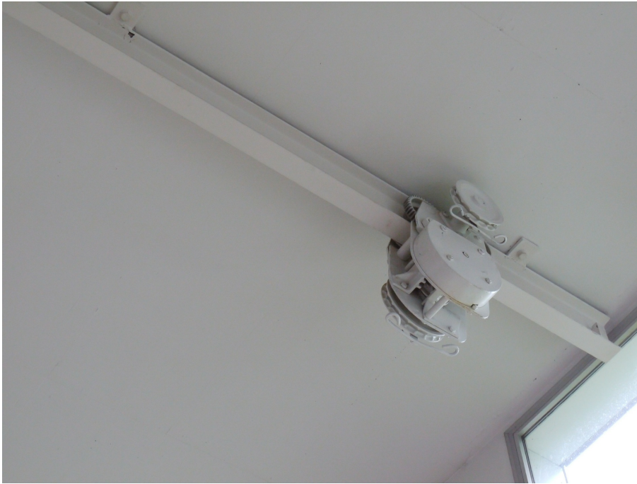
Wohn- und Atelierhaus Bill, Wohn- und Atelierhaus (Vers. Nr. 00736), Atelier im EG, Vorrichtung zur Aufhängung/Verschiebung von Kunstobjekten, 16.05.2015 (Bild Nr. D100601_50).
