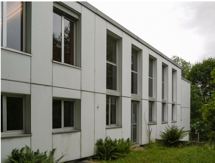
Wohn- und Atelierhaus Bill, Wohn- und Atelierhaus (Vers. Nr. 00736), Nordostfassade, Ansicht von O, 16.05.2015 (Bild Nr. D100601_25).
