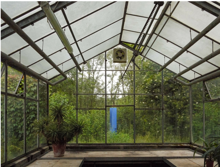
Wohn- und Atelierhaus Bill, Wohn- und Atelierhaus (Vers. Nr. 00736), Gewächshaus mit Blick hinaus in die Umgebung bzw. in den Wald auf Kat. Nr. 1456 (160UMGEBU00736) mit bauzeitlichem Baumbestand, Ansicht von SO, 16.05.2015 (Bild Nr. D100601_51).
