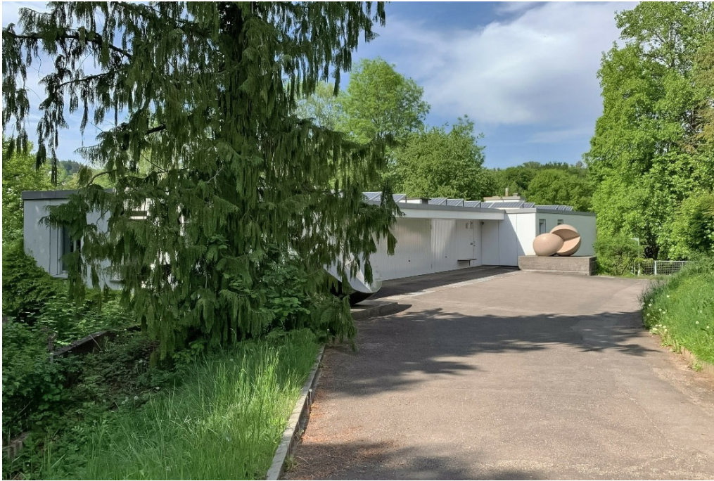
Wohn- und Atelierhaus Bill, Umgebung (160UMGEBU00736) mit bauzeitlichem Baumbestand, Vorplatz und Südostfassade des Wohn- und Atelierhauses (Vers. Nr. 00736) mit Haupteingang, Ansicht von S, 08.05.2020 (Bild Nr. D100601_22).
