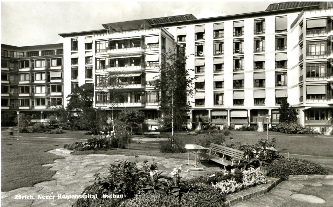
Spitalpark, Spitalpark (261FLPARK01380), im Hintergrund das Bettenhaus Ost (261FL01388), Ansicht von W, Bild: Baugeschichtliches Archiv, Sign. PK_0080, https://baz.e-pics.ethz.ch/latelogin.jsp?recordsWithCatalogName=BAZ:399297 , ca. 1951 (Bild Nr. D101393_22).
