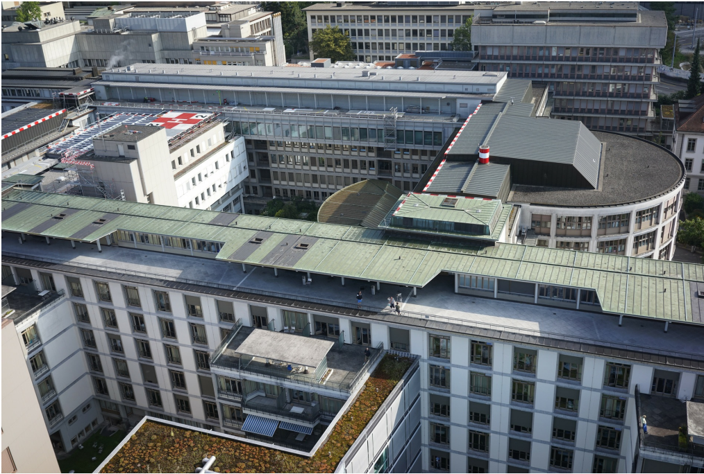
Universitätsspital, im Vordergrund das Bettenhaus Ost (261FL01388) mit an die Fassade angebautem Provisorium, hinten parallel der Operationstrakt (261FL01386), dazwischen quer verbindend der Hörsaaltrakt (261FL1387), Ansicht von SW, 26.08.2021 (Bild Nr. D101393_06).
