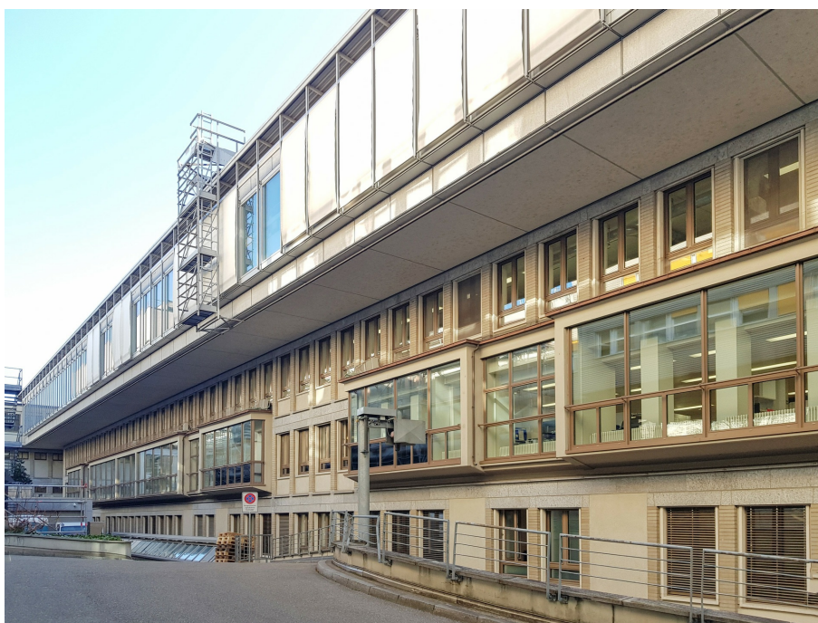
Universitätsspital, Operationstrakt (Vers. Nr. 261FL01386), Ansicht von NW, 04.04.2021 (Bild D101393_05).
