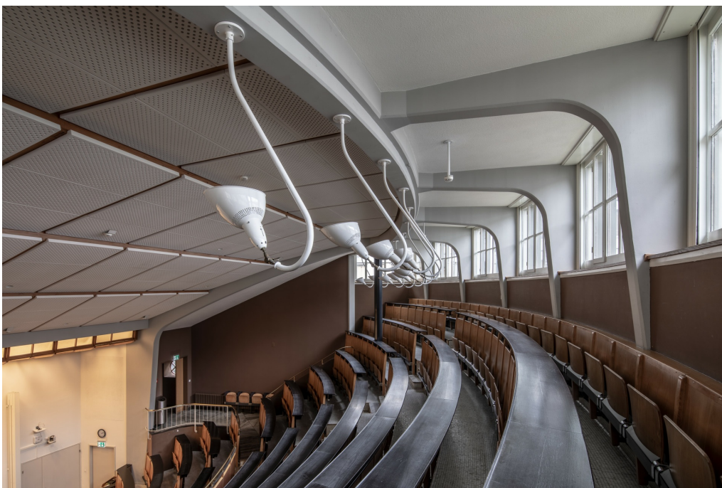
Universitätsspital, Hörsaaltrakt (Vers. Nr. FL01387), Hörsaal im NW, Innenraum, 10.12.2018 (Bild Nr. D101718_03).
