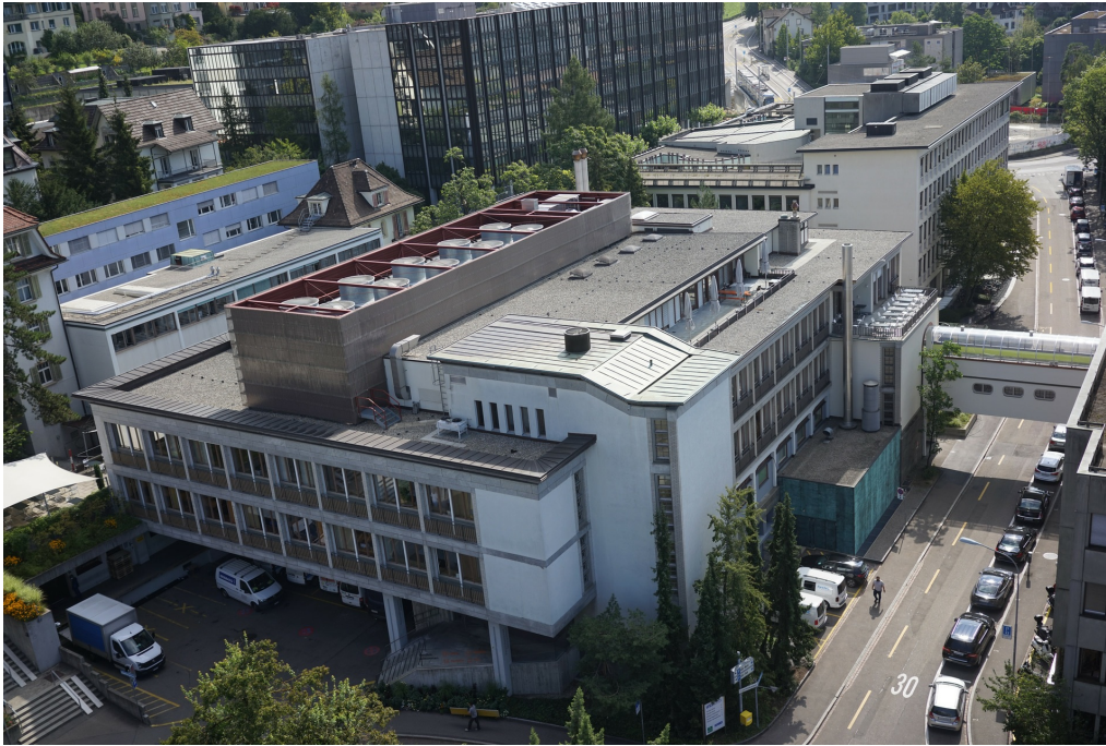
Universitätsspital, Küchentrakt mit Personalrestaurant und Cafeterien (261FL01385; Sternwartstrasse 3), rechts die Passerelle (261FLVERBIND00385; Sternwartstrasse 3 bei), Ansicht von W, 26.08.2021 (Bild Nr. D101393_10).
