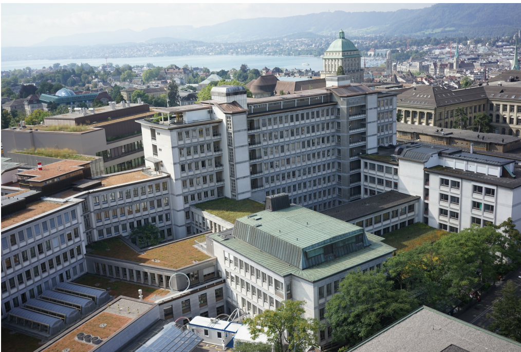
Universitätsspital, mittig das Bettenhaus West (261FL01381), links anschliessend der Gelenktrakt (261FL01355), vorne rechts der Nukleartrakt 1(261FL01398), Nukleartrakt 2 (261FLNUK01382) und Nukleartrakt 3 (261FL01383), Ansicht von N, 26.08.2021 (Bild Nr. D101393_03).
