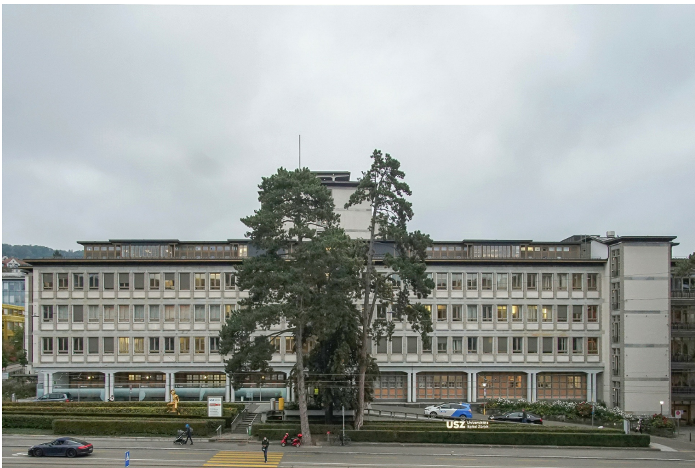
Universitätsspital, Polikliniktrakt (261FL01380), nördlicher Gebäudeteil, Ansicht von W, 08.10.2021 (Bild Nr. D101393_60).
