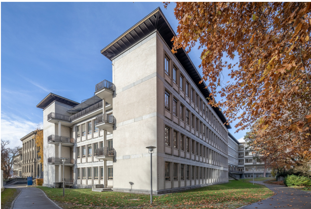
Universitätsspital, Polikliniktrakt (261FL01380), südlicher Gebäudeteil, Ansicht von SO, 10.12.2018 (Bild Nr. D101718_33).
