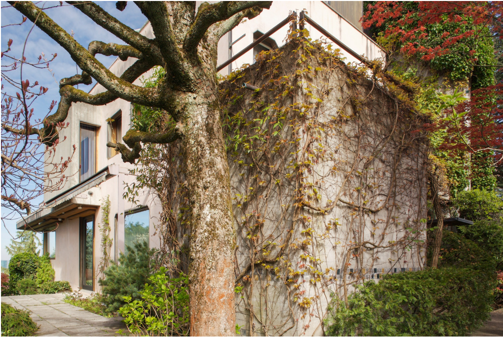
«Casa Zentner», Wohnhaus (261HO01440), Ansicht von SO, 15.05.2014 (Bild Nr. D100690_63).
