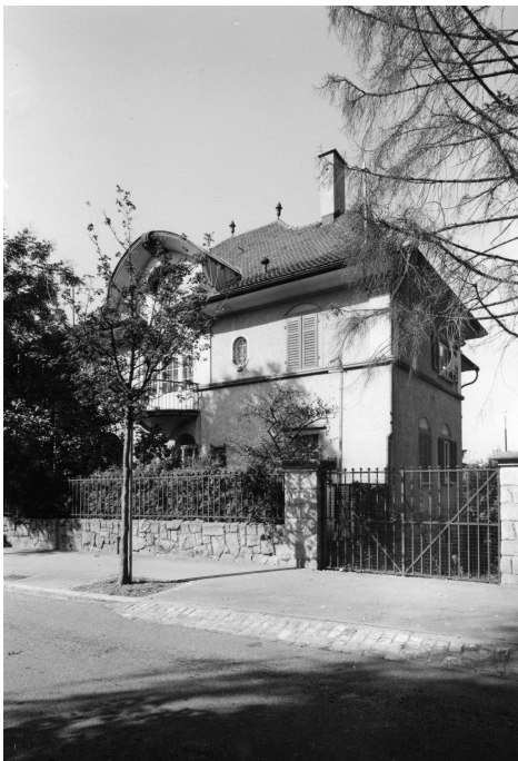
Umgebung; Wohnhaus, «Villa Seligmann», Vorgängerbau der «Casa Zentner» (261HO01440), Ansicht von NO, Bild: Baugeschichtliches Archiv Zürich, Sign. BAZ_114529, 01.01.1964 (Bild Nr. D100682_31).
