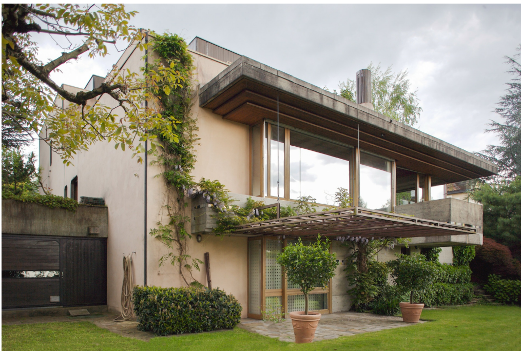
«Casa Zentner», Wohnhaus (261HO01440), Ansicht von NW, 17.05.2014 (Bild Nr. D100690_70).
