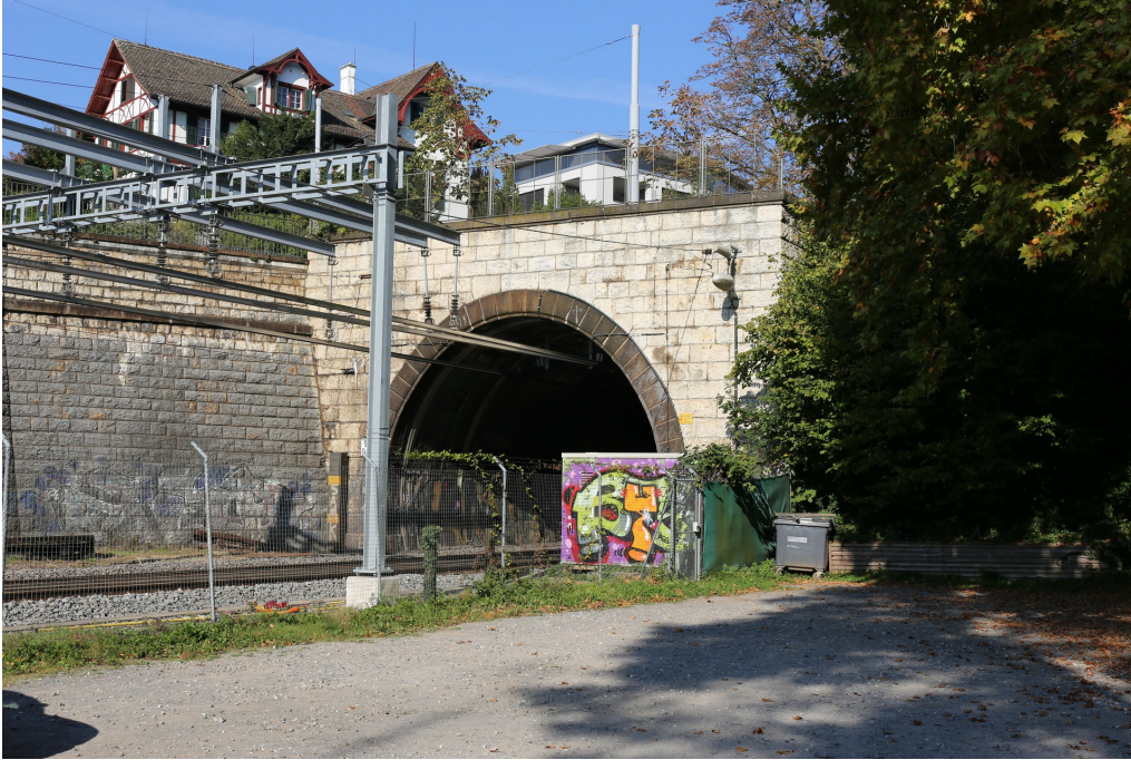
«Seebahneinschnitt», Engetunnel, Südportal mit Grünanlage (261ENTUNNEL00004), Ansicht von SO, 17.10.2018 (Bild Nr. D101369_94).
