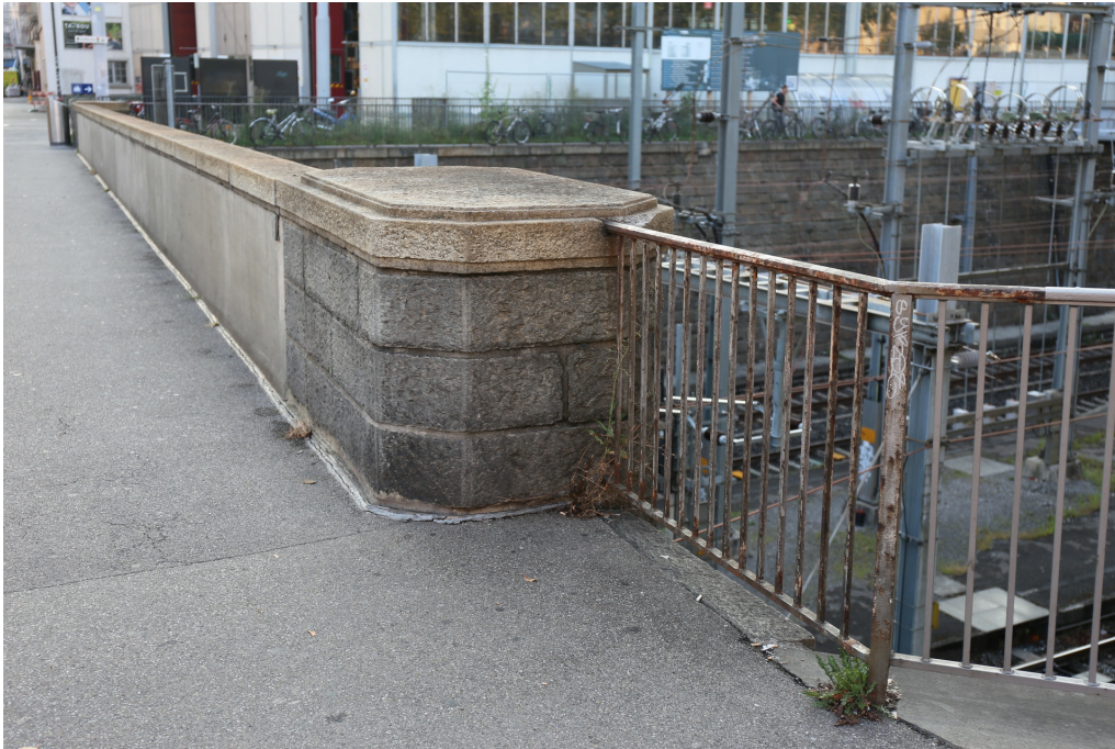
«Seebahneinschnitt», Trasse, Böschungen, Stützmauern und Staketengeländer (261AUSEEBAHN00001) und Strassenüberführung Kalkbreitestrasse (261WDSEEBAHN00001) mit Brüstungsmauer, Brückenkopf (Widerlager) und Staketengeländer (heute eckig abgekürzt), 17.10.2018 (Bild Nr. D101369_62).
