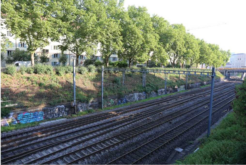
«Seebahneinschnitt», Trasse, Böschungen, Stützmauern, Staketengeländer und Platanenreihen (261AUSEEBAHN00001), Trasse kurz nach der Abzweigung beim Kohlendreieck, im Hintergrund die Strassenüberführung Hohlstrasse (261AUSEEBAHN00002), Ansicht von S, 17.10.2018 (Bild Nr. D101369_57).
