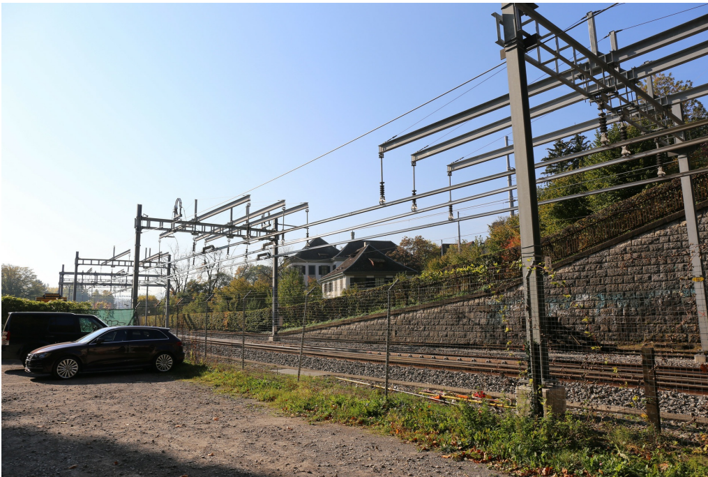
«Seebahneinschnitt», Trasse, Böschungen, Stützmauern und Staketengeländer (261AUSEEBAHN00001), südlicher Abschluss, bzw. letzte Stützmauer des «Seebahneinschnitts» nach dem Engetunnel, deutlich zu erkennen die neuem Stromschienenjoche, Ansicht von NO, 17.10.2018 (Bild Nr. D101369_96).
