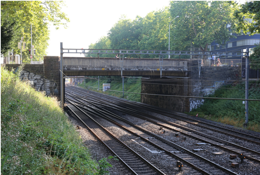
«Seebahneinschnitt», Trasse, Böschungen, Stützmauern, Staketengeländer und Platanenreihen (261AUSEEBAHN00001) und Strassenüberführung Stauffacherstrasse (261AUSEEBAHN00003), Ansicht von SW, 17.10.2018 (Bild Nr. D101369_58).
