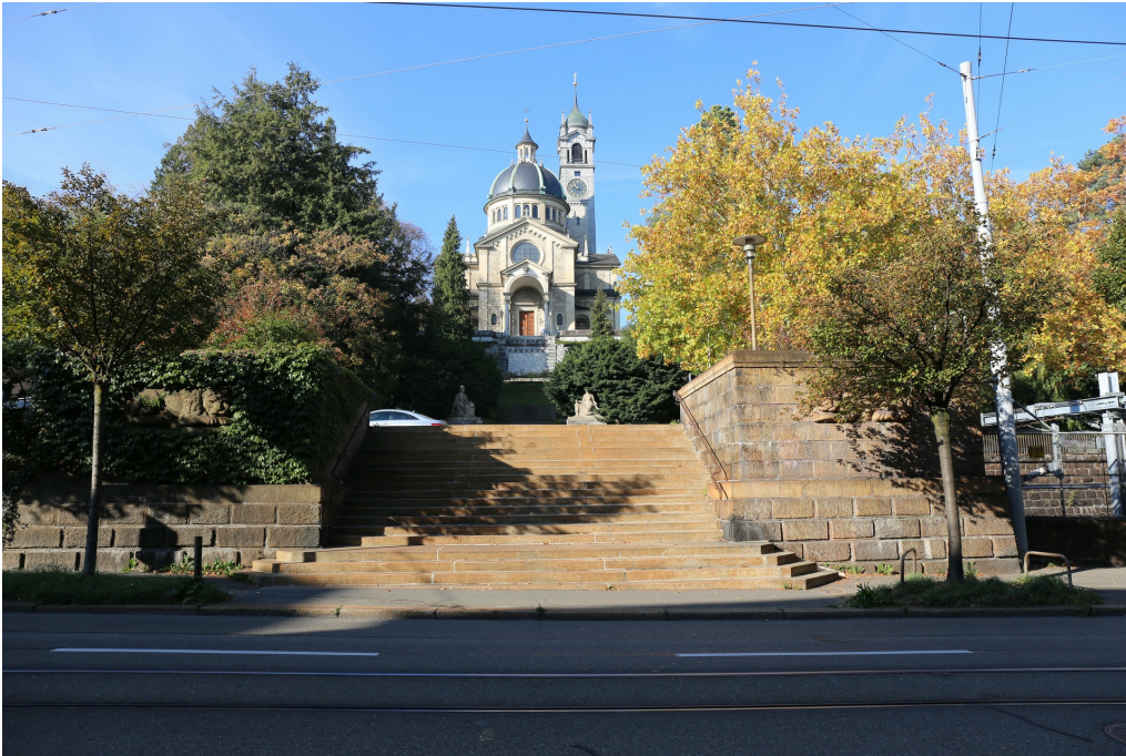
«Seebahneinschnitt», Engetunnel, Überdeckung mit Grünanlage (261ENTUNNEL00003) Freitreppe und Platz über dem Nordportal, Ansicht von O, 18.10.2018 (Bild Nr. D101369_99).
