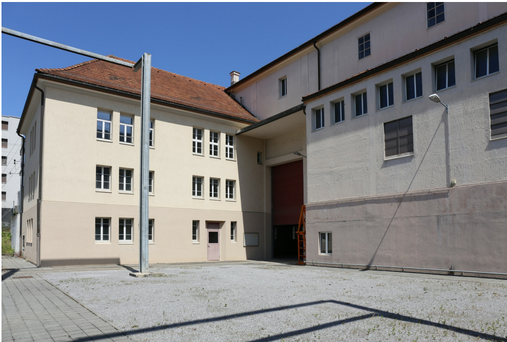
Unterwerk Seebach, Ansicht von SO, 01.07.2019 (Bild Nr. D101382_04).
