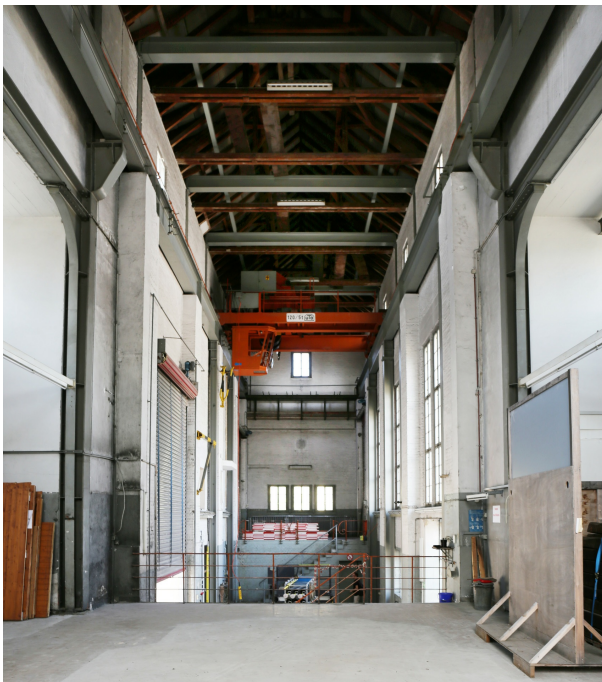
Unterwerk Seebach, Dienstgebäude, Halle von der Bühne der ehem. Umformermaschine gegen den älteren Teil im W, 01.07.2019 (Bild Nr. D101382_07).
