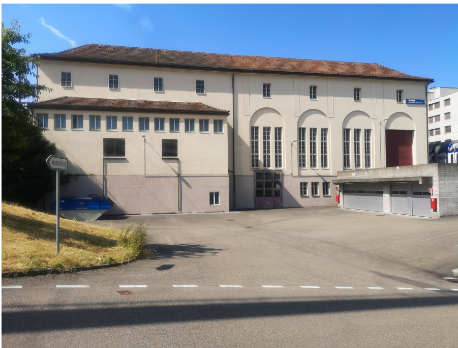
Unterwerk Seebach, Dienstgebäude, Ansicht von NO, 01.07.2019 (Bild Nr. D101382_02).
