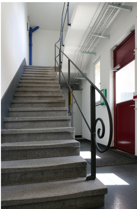
Unterwerk Seebach, Dienstgebäude, Treppenhaus, 01.07.2019 (Bild Nr. D101382_05).
