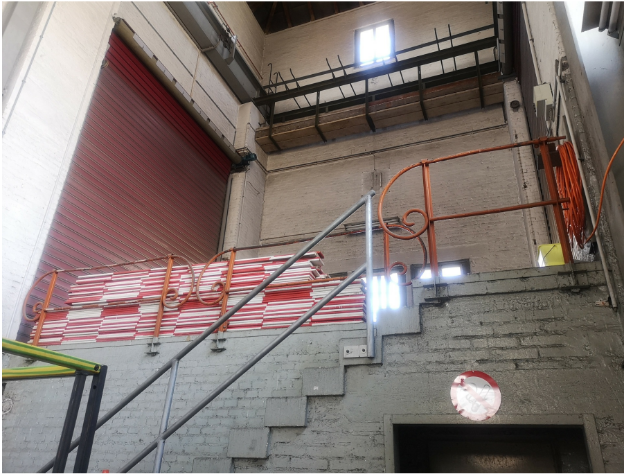
Unterwerk Seebach, Dienstgebäude, Halle gegen W, 01.07.2019 (Bild Nr. D101382_08).
