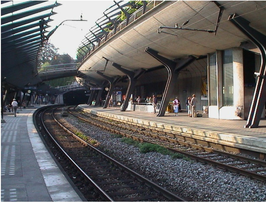
Bahnhof Zürich Stadelhofen, Perronanlage (261AA01033), Ansicht von SO, Bild: Wikimedia Commons, Paebi, 15.04.2007 (Bild Nr. D101354_88).
