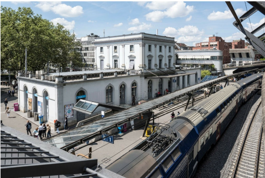
Bahnhof Zürich Stadelhofen, Aufnahmegebäude (261AA01031), Ansicht von O vom Fussgängersteg Falkenweg, Bild: Schweizerische Bundesbahnen SBB, www.sbb.ch/de/bahnhof-services/bahnhoefe/bahnhof-zuerich-stadelhofen.html , Stand: 24.04.2019, 24.04.2019 (Bild Nr. D101354_83).
