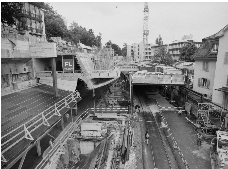
Bahnhof Zürich Stadelhofen, Perronanlage (261AA01033) im Bau, Bild: Jules Vogt, ETH-Bildarchiv, Sign. Com_M36-0099-0003-0004, 03.07.1987 (Bild Nr. D101354_89).
