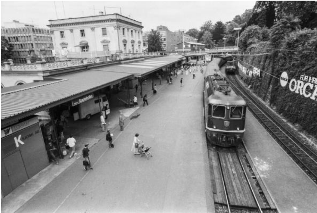
Bahnhof Zürich Stadelhofen, Aufnahmegebäude (261AA01031), Ansicht von SO (ungefähr vom heutigen Fussgängersteg Falkenweg), aus: Zürich – damals und heute, www.zhdamalsheute.ch , Stand 24.04.2019, 20.06.1983 (Bild Nr. D101354_85).
