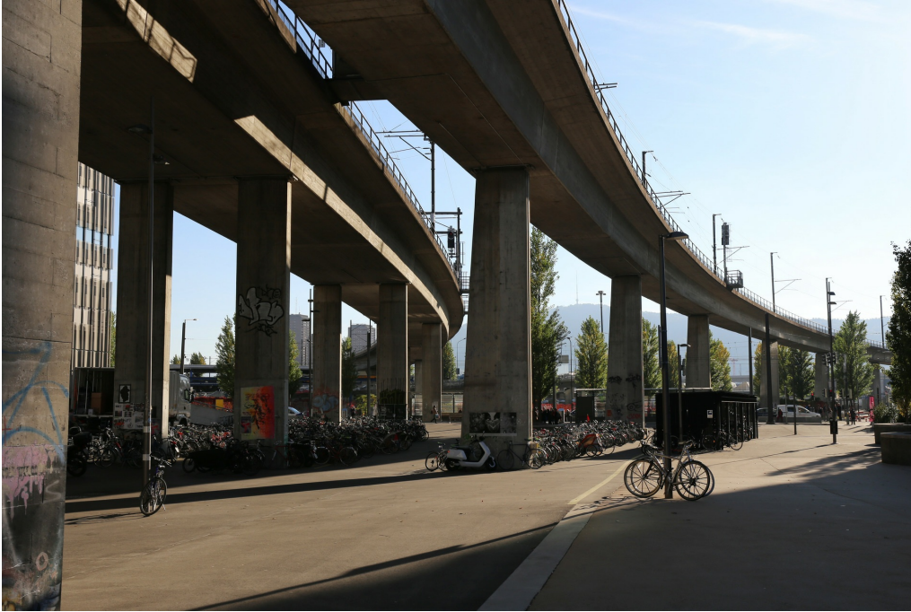
Hardturmviadukt, die beiden Schenkel über der Fussgängerzone bei der Tramhaltestelle Toni-Areal, beim zweisepurigen östlichen Schenkel lagert der dreifache durchlaufende Hohlkastenträger auf Doppelstützen, beim einspurigen westlichen Schenkel sind die Stützen mit einseitigem Anzug ausgebildet, Ansicht von N, 25.10.2018 (Bild Nr. D101138_76).
