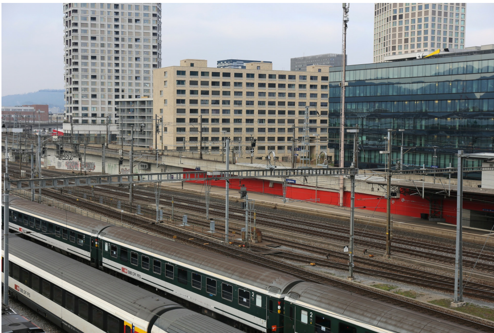
Hardturmviadukt, Rampe (261IQRAMPE00001), Abschnitt des Rahmenbauwerks im Bereich des Bahnhofs Zürich Hardbrücke (Hardstrasse 181 u. a.; 261AU00332 u. a.), Ansicht von SO, 15.12.2018 (Bild Nr. D101138_73).
