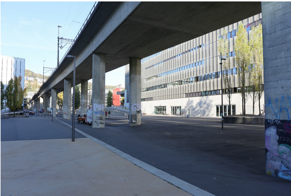
Hardturmviadukt, gerader Teil (261IQHARDTU00003), Ansicht von SW, 25.10.2018 (Bild Nr. D101138_79).
