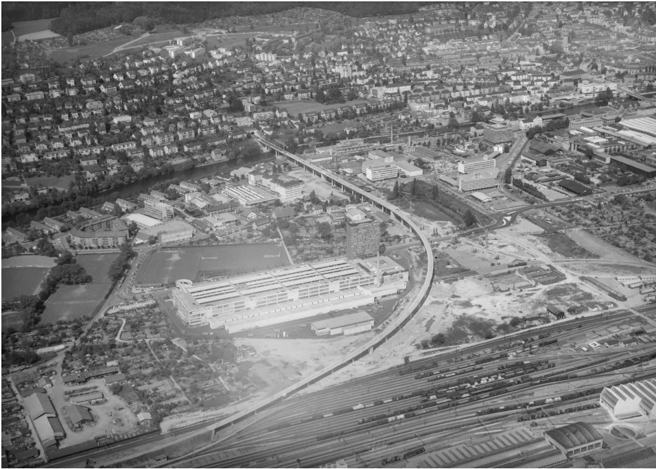
Hardturmviadukt, westlicher Schenkel (261IQHARDTU00001), Flugaufnahme von SW mit fertiggestelltem westlichem und noch fehlendem östlichem Schenkel, Bild: ETH-Bildarchiv, Sign. LBS_H1-027520, 15.05.1968 (Bild Nr. D101138_78).
