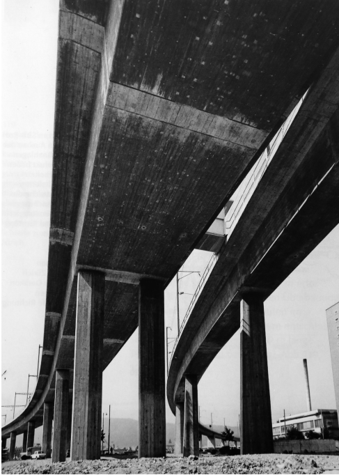
Hardturmviadukt, kurz nach Fertigstellung des ersten Teils des östlichen Schenkels, aus: Dialma Jakob Bänziger – Brückenbau 1960–2005, hg. von Gesellschaft für Ingenieurbaukunst, Zürich 2009, S. 110, 01.01.1970 (Bild Nr. D101138_83).
