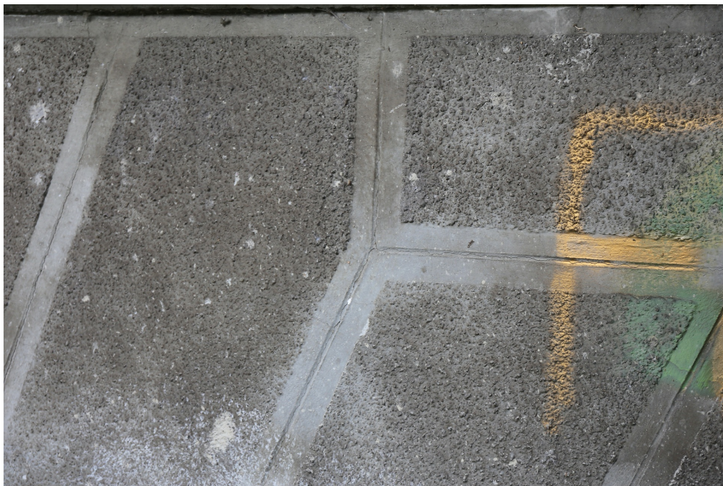
Glattbrücke, Oberflächenbearbeitung des Zementverputzes (Detail), 26.10.2018 (Bild Nr. D101354_93).
