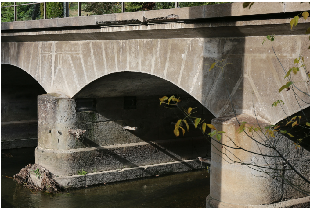
Glattbrücke, Ansicht von SO, 26.10.2018 (Bild Nr. D101354_92).
