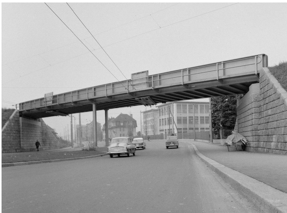
Strassenunterführung Badenerstrasse, Ansicht von SO, Bild: SBB Historic, 01.11.1958 (Bild Nr. D101354_48).
