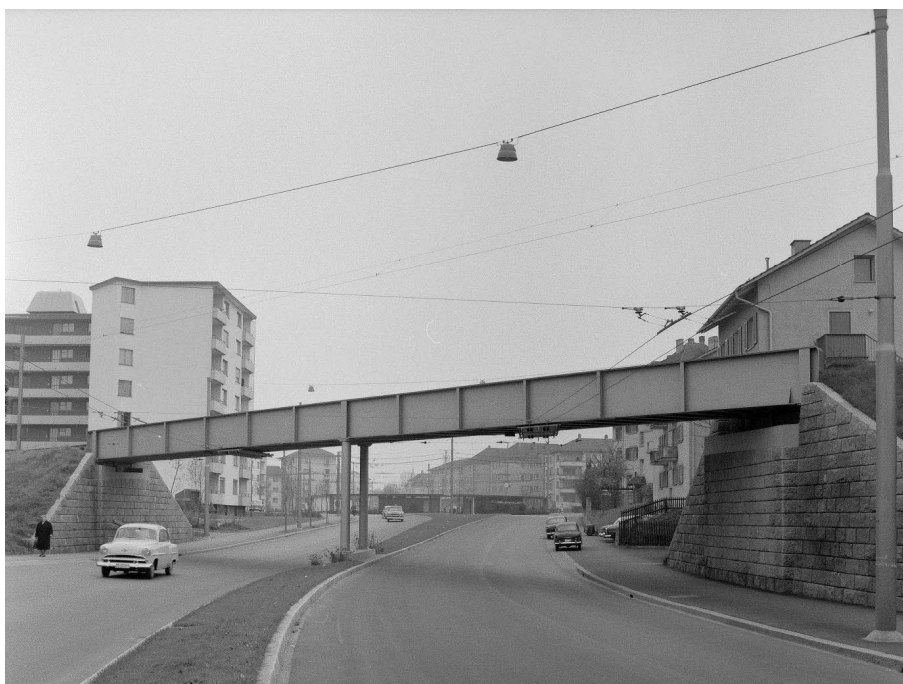
Strassenunterführung Badenerstrasse, Ansicht von W, Bild: SBB Historic, 01.11.1958 (Bild Nr. D101354_49).
