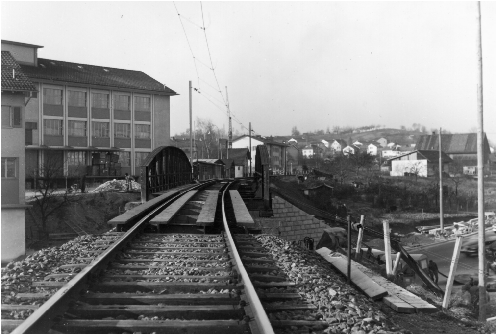
Strassenunterführung Badenerstrasse, Ansicht von O, kurz vor dem Bau; Widerlager bereits neu gemauert, Bild: Baugeschichtliches Archiv Zürich, Sign. 87901-C, 01.01.1958 (Bild Nr. D101354_45).
