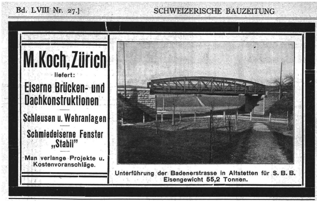
Strassenunterführung Badenerstrasse, Vorgängerbau, Ansicht von S, Situation von 1904 bis 1958 mit einem Halbparabelträger der M. Koch AG, in: Schweizerische Bauzeitung, 1911, o. S., 01.01.1911 (Bild Nr. D101354_46).
