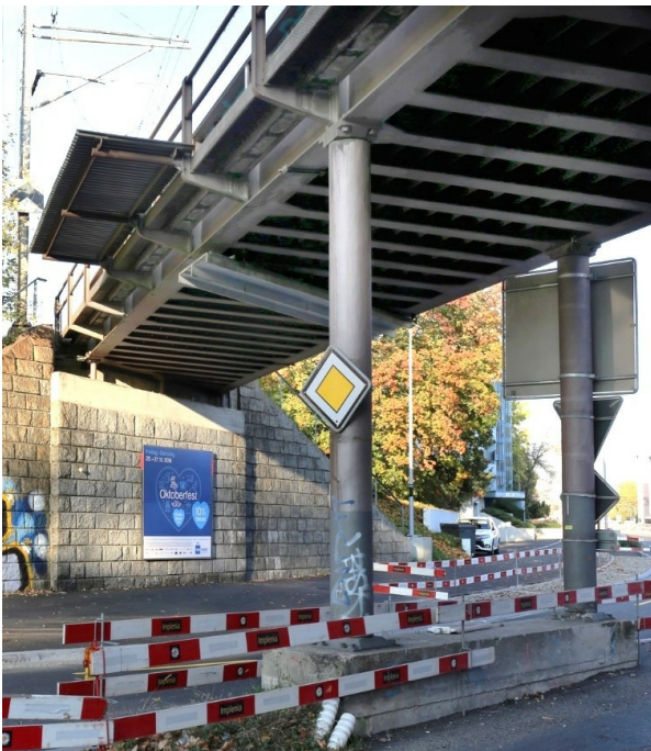
Strassenunterführung Badenerstrasse, die beiden Pendelstützen in Strassenmitte und das westliche Widerlager im Hintergrund, 25.10.2018 (Bild Nr. D101354_44).
