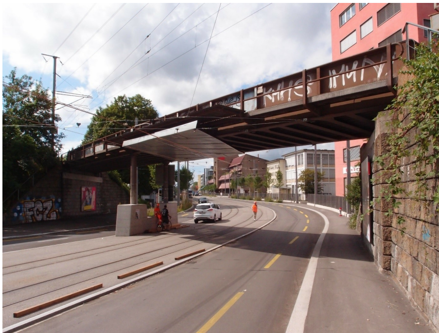
Strassenunterführung Badenerstrasse, Ansicht von SO, 10.08.2019 (Bild Nr. D101354_42).
