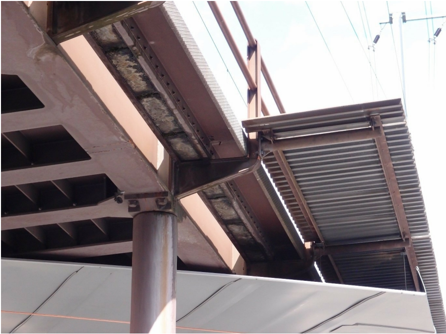
Strassenunterführung Badenerstrasse, Pendelstützen, dahinter die neuen Schutzvorrichtungen für die Fahrleitung der Limmattalbahn, 10.08.2019 (Bild Nr. D101354_47).
