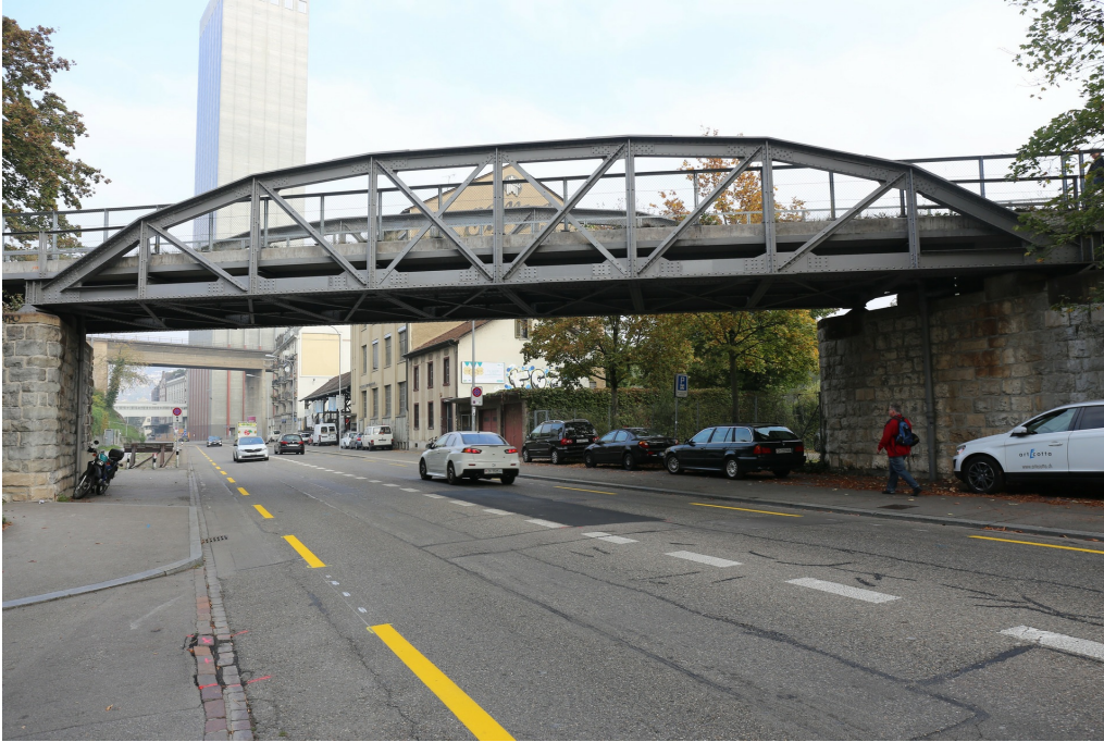
Lettenviadukt, Strassenunterführung Sihlquai (261IQBRUECKE00006), Ansicht von SO, 20.10.2018 (Bild Nr. D101138_58).
