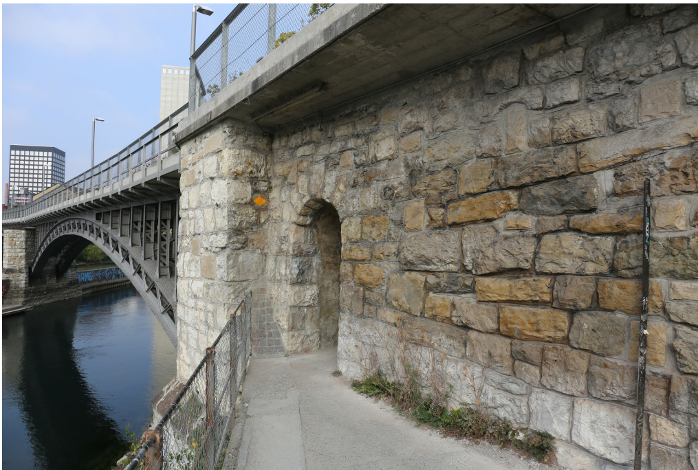
Lettenviadukt, Lettendamm mit Personendurchlass Kloster-Fahr-Weg (261WPDAMM00003), Ansicht von SO, 20.10.2018 (Bild Nr. D101138_68).
