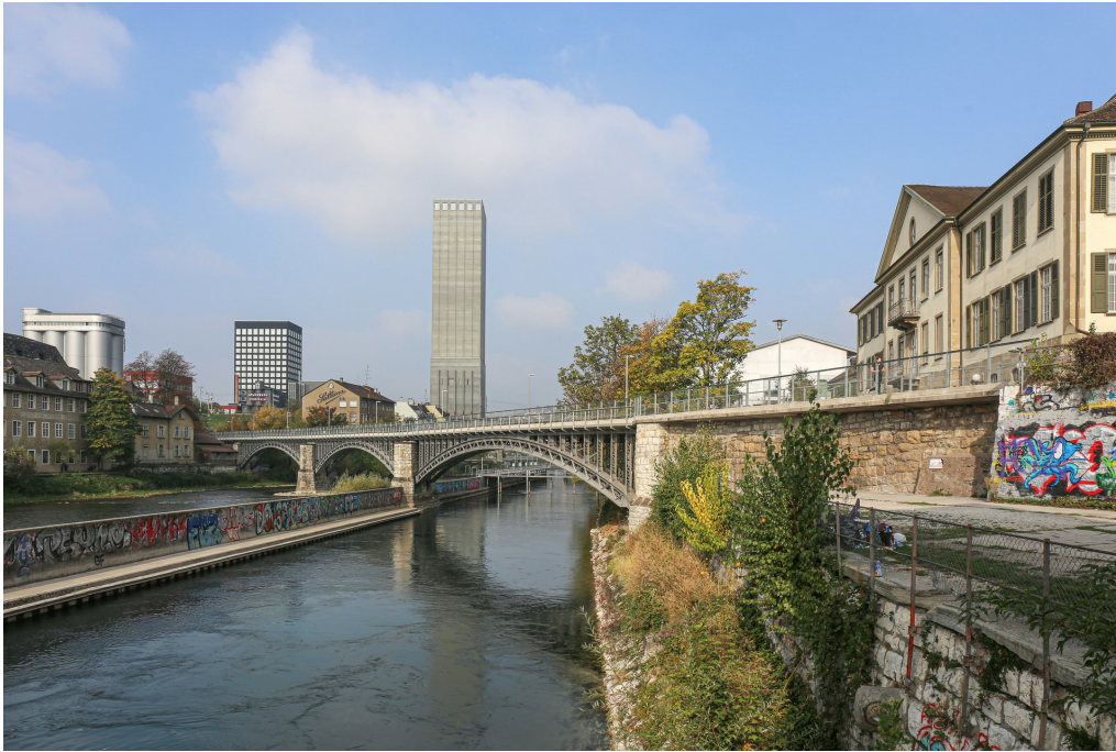
Lettenviadukt, links die Limmatbrücke (261IQBRUECKE00008), rechts der Lettendamm mit Personendurchlass Kloster-Fahr-Weg (261WPDAMM00003), Ansicht von SO, 20.10.2018 (Bild Nr. D101138_67).
