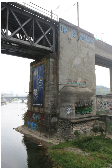
Wipkinger Viadukt, Brückenpfeiler von 1855 zwischen der Strassenunterführung Sihlquai (261IQBRUECKE00004), rechts, und der Limmatbrücke (261IQBRUECKE00005), links, Ansicht von NW, 20.10.2018 (Bild Nr. D101353_79).
