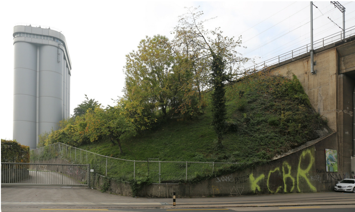
Wipkinger Viadukt, Erddamm Limmatstrasse (261IQDAMM00001), Ansicht von NO, 20.10.2018 (Bild Nr. D101353_74).
