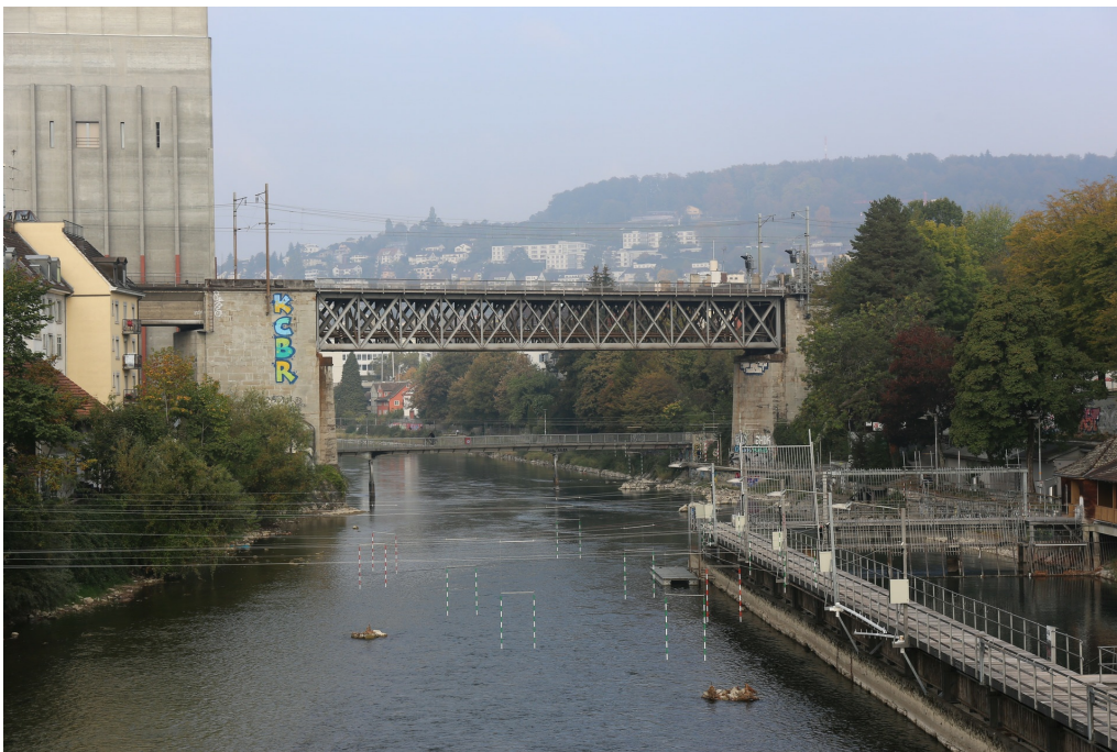
Wipkinger Viadukt, Limmatbrücke (2611QBRUECKE00005), Ansicht von SO, 20.10.2018 (Bild Nr. D101353_78).
