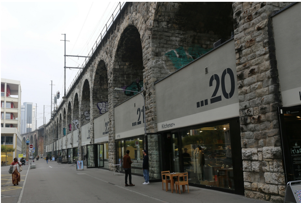
Wipkinger Viadukt, Hausteinbögen mit Strassenunterführungen (261AUVIADUKT00001), Ladeneinbauten in den Hausteinbögen, Ansicht von SW, 20.10.2018 (Bild Nr. D101353_67).
