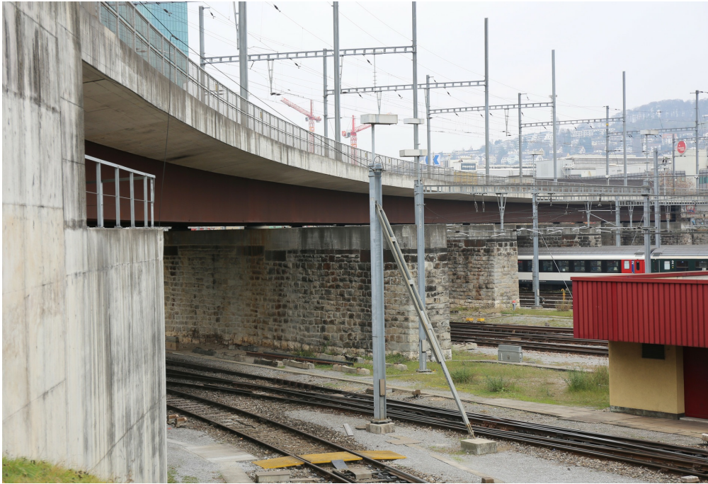
Wipkinger Viadukt, Vorbahnhofbrücke (261AUBRUECKE00003), Ansicht von O, 20.10.2018 (Bild Nr. D101353_66).
