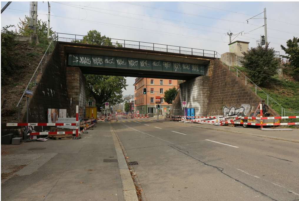
Wipkinger Viadukt, Strassenunterführung Wasserwerkstrasse zwischen dem Erddamm Wasserwerkstrasse mit Pissoir (261WPDAMM00001), links, und dem Erddamm Wipkingen mit Entwässerungsanlage (261WPDAMM00002), rechts, Ansicht von O, 20.10.2018 (Bild Nr. D101353_81).
