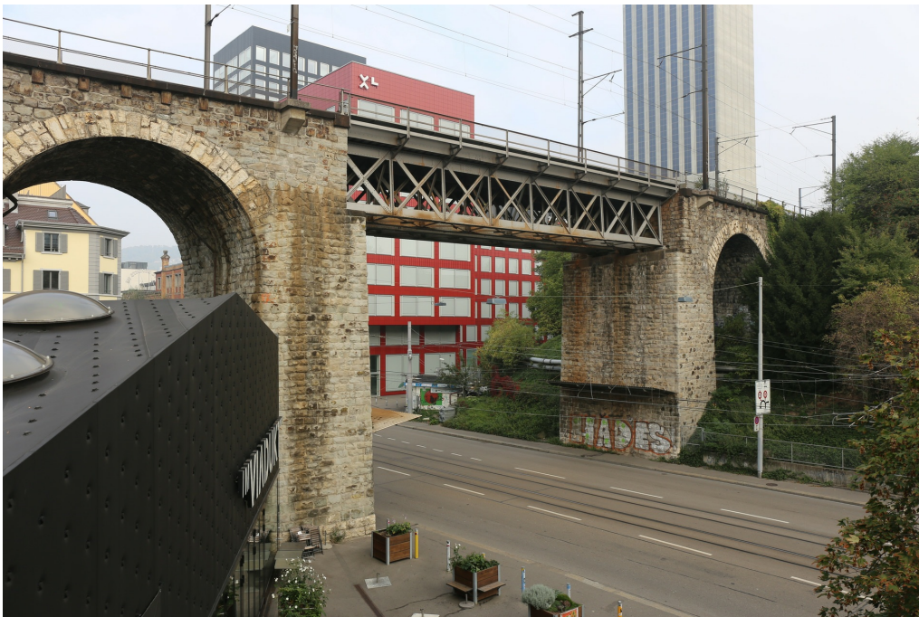
Wipkinger Viadukt, Hausteimbögen mit Strassenunterführungen (261AUVIADUKT00001), Strassenunterführung Limmatstrasse, Ansicht von S, 20.10.2018 (Bild Nr. D101353_73).
