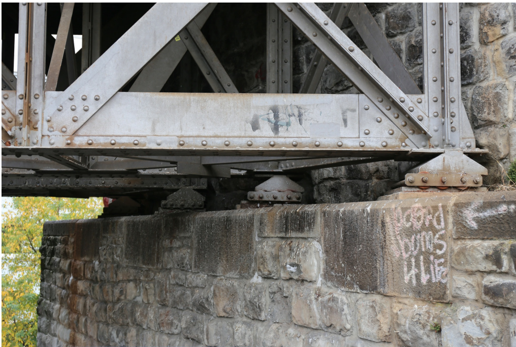
Wipkinger Viadukt, Hausteinbögen mit Strassenunterführungen (261AUVIADUKT00001), Strassenunterführung Josefstrasse, nördliches Auflager (Detail), Ansicht von O, 20.10.2018 (Bild Nr. D101353_71).
