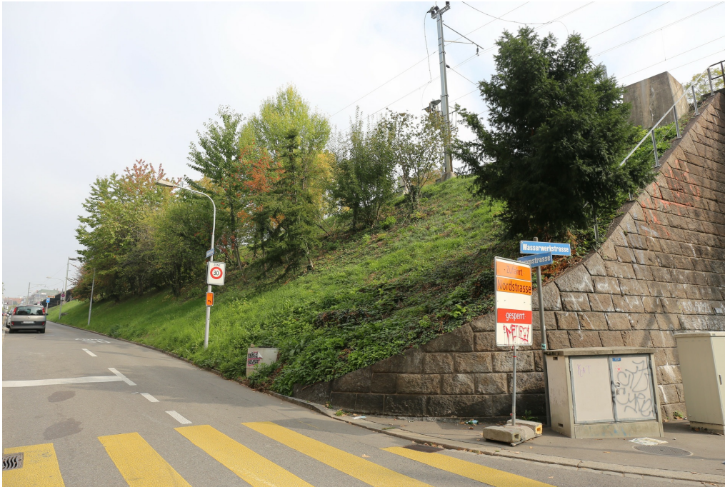
Wipkinger Viadukt, Erddamm Wipkingen mit Entwässerungsanlage (261WPDAMM00002), Ansicht von SW, 20.10.2018 (Bild Nr. D101353_85).
