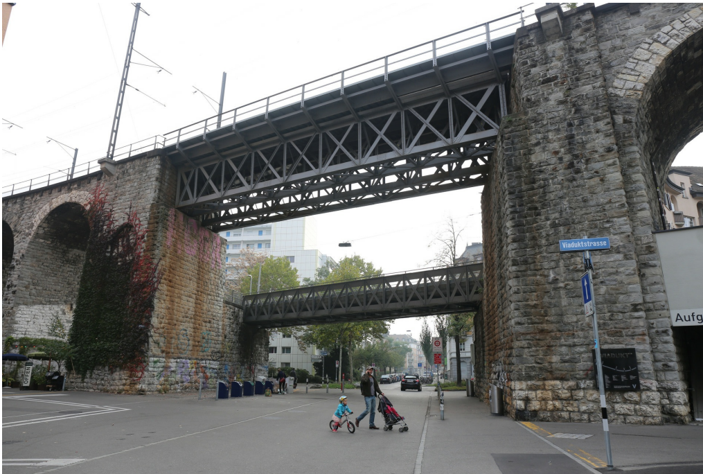
Wipkinger Viadukt, Hausteimbögen mit Strassenunterführungen (261AUVIADUKT00001), Strassenunterführung Heinrichstrasse, Ansicht von W, 20.10.2018 (Bild Nr. D101353_72).
