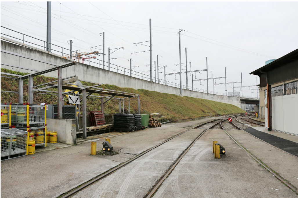
Wipkinger Viadukt, Erddamm Vorbahnhof (261AUDAMM00001), Ansicht von O, 20.10.2018 (Bild Nr. D101353_65).
