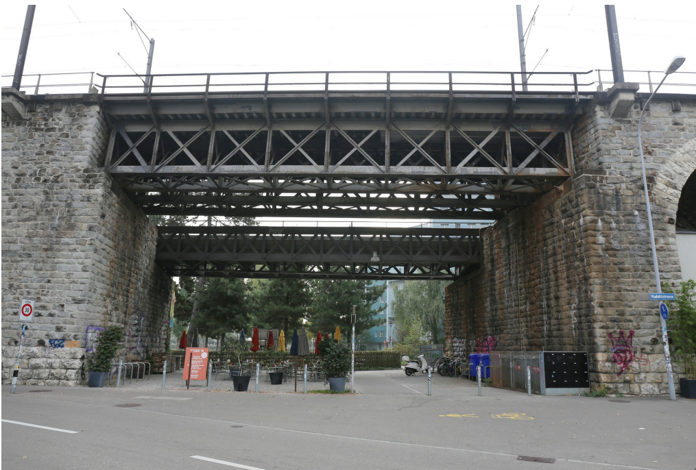
Wipkinger Viadukt, Hausteinbögen mit Strassenunterführungen (261AUVIADUKT00001), Strassenunterführung Neugasse, Ansicht von W, 20.10.2018 (Bild Nr. D101353_69).
