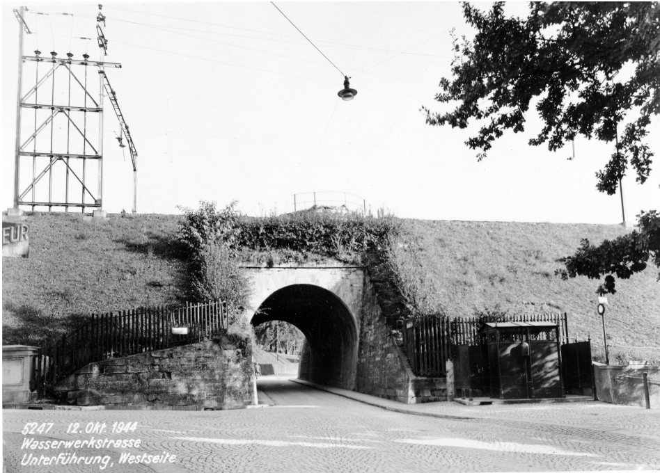
Wipkinger Viadukt, Strassenunterführung Wasserwerkstrasse vor dem Ausbau 1948, Ansicht von W, rechts der Vorgängerbau des Pissoirs (261WPPISOIR00001), Ansicht von W, Bild: Baugeschichtliches Archiv Zürich, Bild Nr. DMP_054643, 12.10.1944 (Bild Nr. D101353_84).
