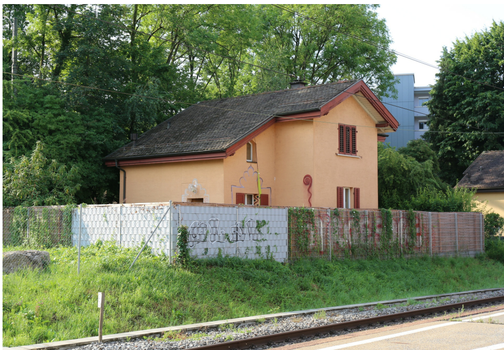
Bahnwärterhäuser, nördliches Bahnwärterhaus (261WP00547), Ansicht von NW, 20.10.2018 (Bild Nr. D101353_39).
