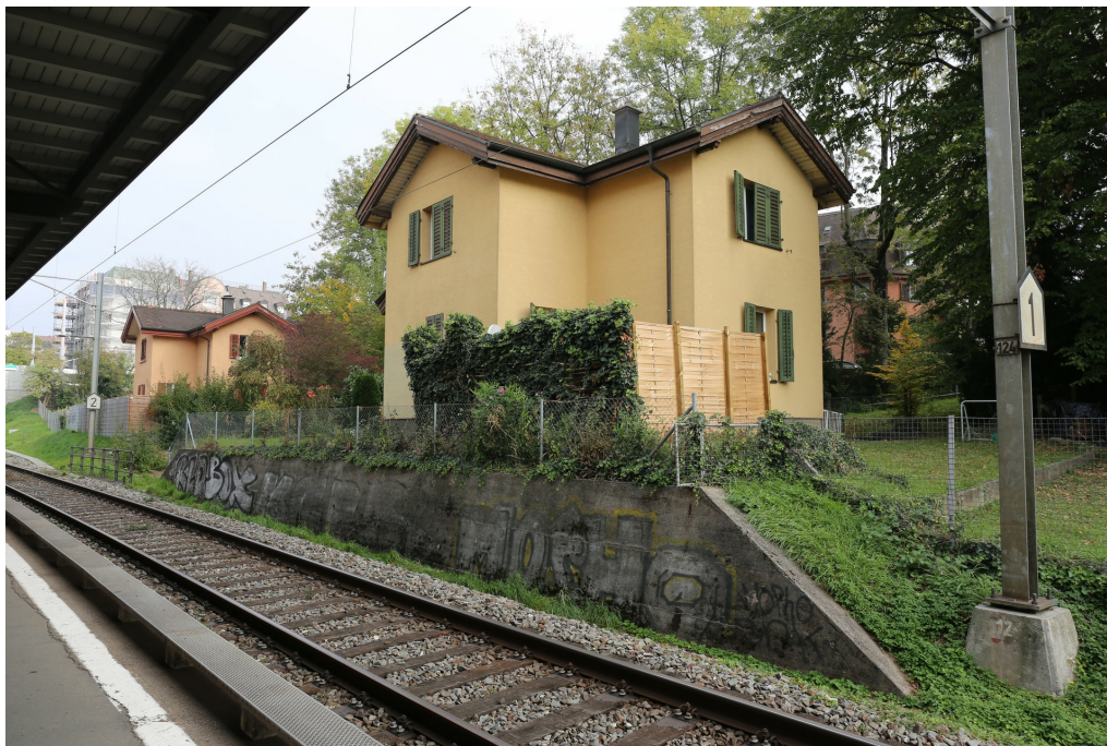
Bahnwärterhäuser, südliches Bahnwärterhaus (261WP00562), Ansicht von SW, mit Stützmauer von 1932, 20.10.2018 (Bild Nr. D101353_34).
