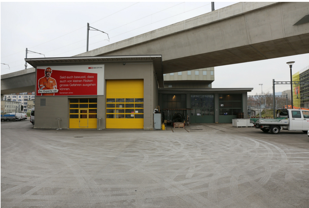
Dienstgebäude Fahrleitungsunterhalt, links das Hauptgebäude, rechts die Werkstatt/Remise, Ansicht von N, 15.12.2018 (Bild Nr. D101139_79).
