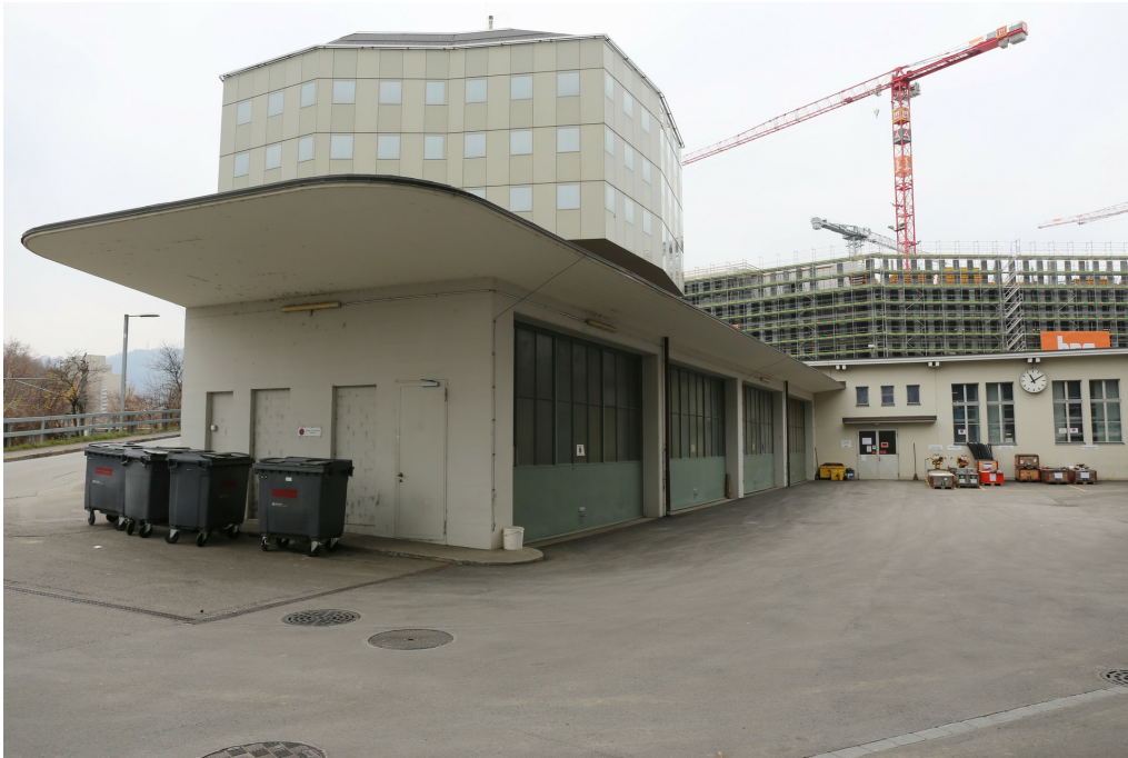
Dienstgebäude Fahrleitungsunterhalt, Garagenflügel, Ansicht von NO, 15.12.2018 (Bild Nr. D101139_73).
