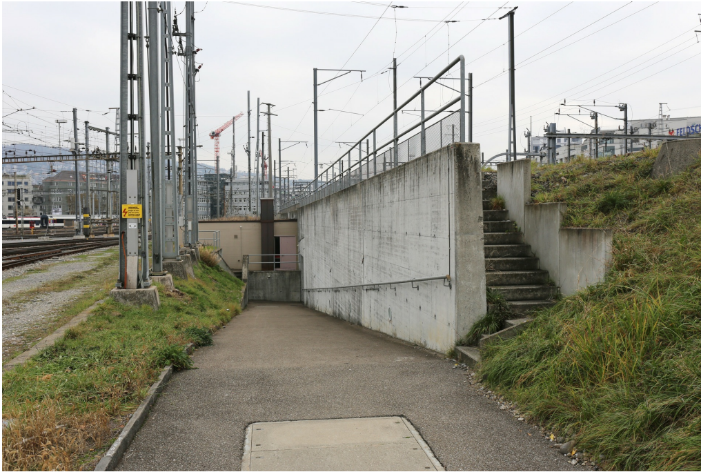
«Depot F», Personenunterführung Neufrankengasse (261AUUNTERF00934), nördlicher Abgang, im Hintergrund das beige gestrichene Gebäude des «Hauptschaltpostens» Zürich (Remisenstrasse 20; 261AU00934), Ansicht von W, 15.12.2018 (Bild Nr. D101139_60).
