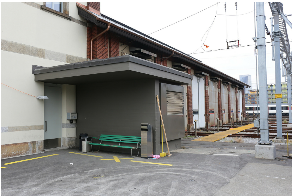
«Depot F», Hauptgebäude «Depot F» (261AU02834), an Ostfassade angebautes Rangierstellwerk, Ansicht von SO, 15.12.2018 (Bild Nr. D101139_55).
