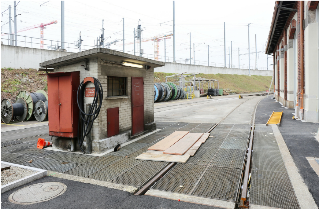
«Depot F», Waschanlage (261AUWASCH02834), Ansicht von O, 15.12.2018 (Bild Nr. D101139_65).
