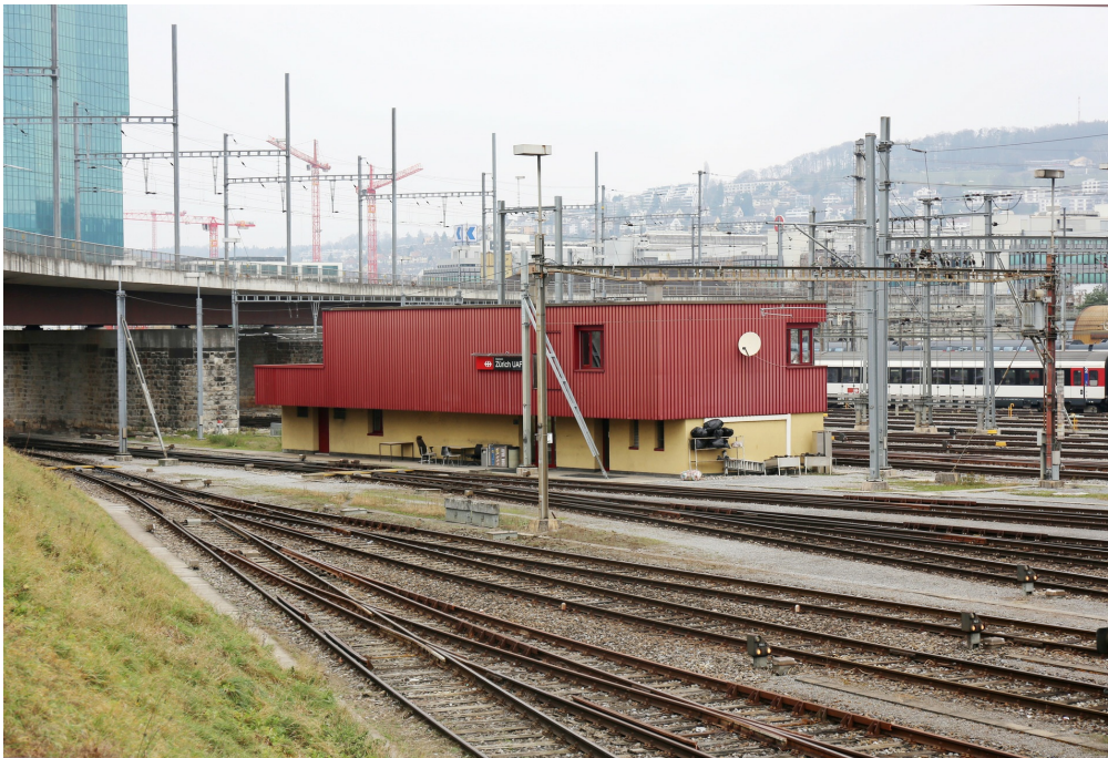
«Depot F», Stellwerk (261AU00630), Ansicht von SO, 15.12.2018 (Bild Nr. D101139_67).
