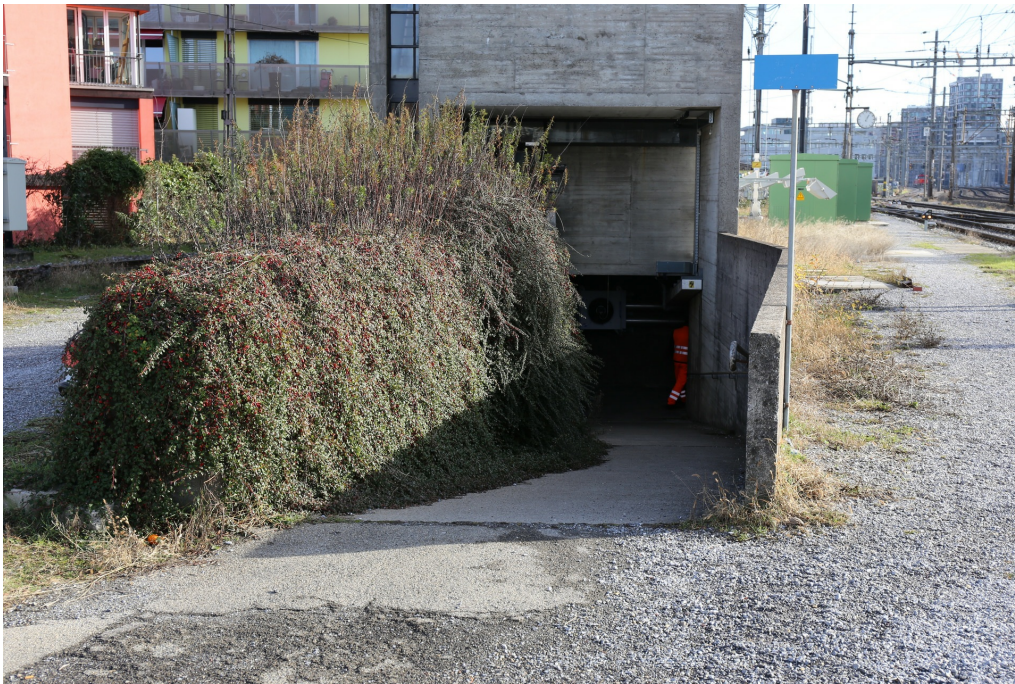
Stellwerke, Stellwerk Nord (261AU00933), Abgang zur Personenunterführung (261AUUNTERF00933), 15.12.2018 (Bild Nr. D101139_38).
