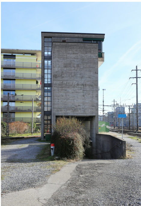
Stellwerke, Stellwerk Nord (261AU00933), Ansicht von NW, 15.12.2018 (Bild Nr. D101139_35).
