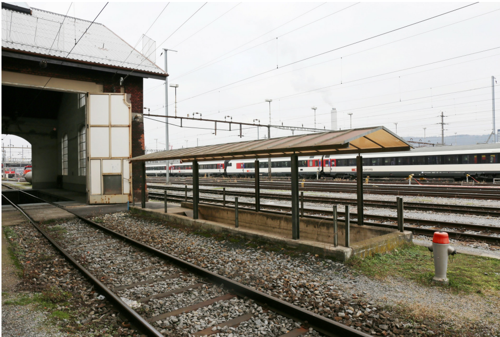
Stellwerke, Personenunterführung (261AUUNTERF00933) Ausgang Süd beim «Depot F» (links das Hauptgebäude, Remisenstrasse 17 und 17; 261AU02834), 16.01.2019 (Bild Nr. D101139_40).
