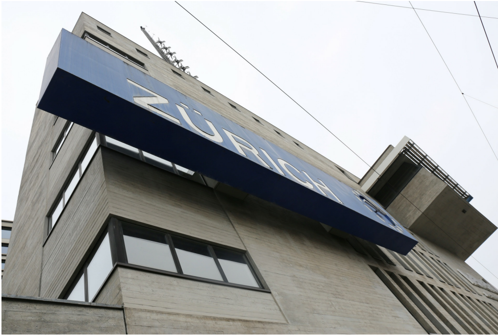
Stellwerke, Zentralstellwerk (261AU00932), Nordostecke, 15.12.2018 (Bild Nr. D101139_30).
