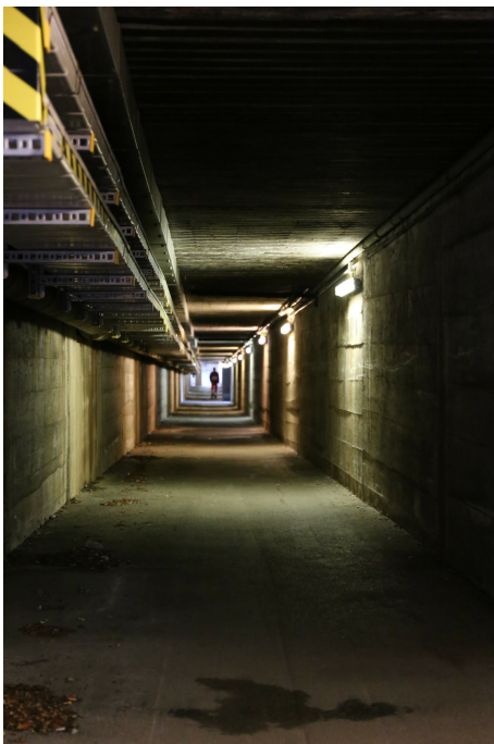
Stellwerke, Personenunterführung (261AUUNTERF00933) Ansicht des Kanals von NW, 15.12.2018 (Bild Nr. D101139_39).
