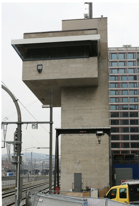
Stellwerke, Zentralstellwerk (261AU00932), Ansicht von NW, im Vordergrund der Portalkran (261AUKRAN00932), 15.12.2018 (Bild Nr. D101139_29).
