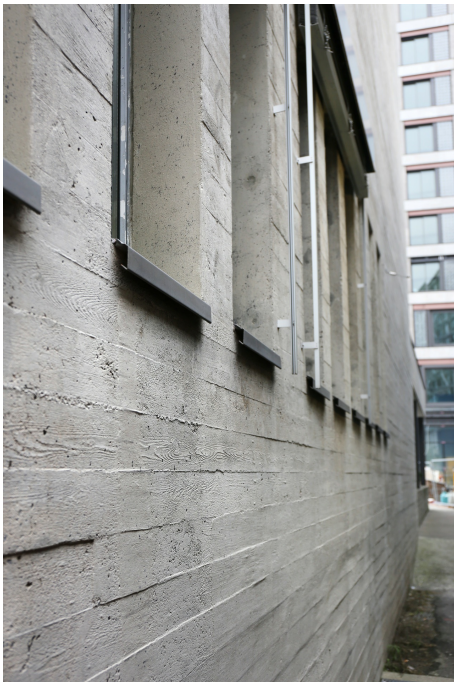
Stellwerke, Zentralstellwerk (261AU00932), Schalungsdetails und Fensterbrüstungen, 15.12.2018 (Bild Nr. D101139_31).
