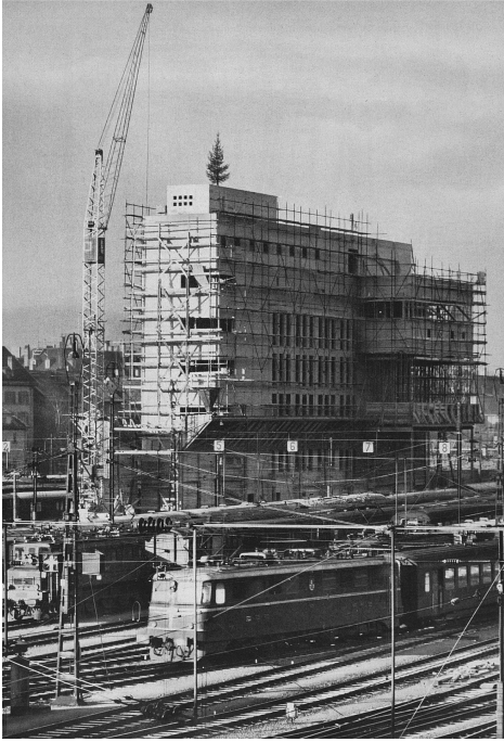
Stellwerke, Zentralstellwerk (261AU00932) im Bau, aus: Schweizerische Bundesbahnen SBB, Geschäftsbericht, 1961, S. 2., Archiv SBB AG, 01.01.1961 (Bild Nr. D101139_41).
