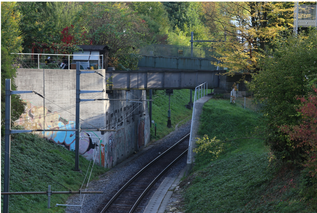
Überführung Nebelbach, Ansicht von N, 18.10.2018 (Bild Nr. D101139_25).
