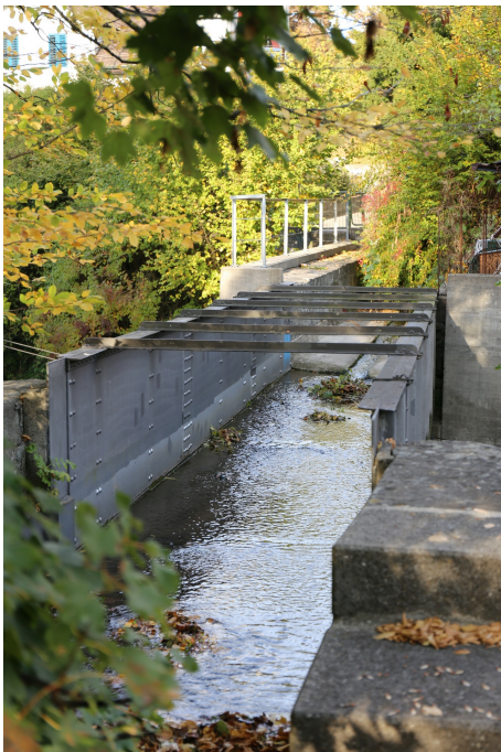
Überführung Nebelbach, Ansicht von SW, 18.10.2018 (Bild Nr. D101139_24).
