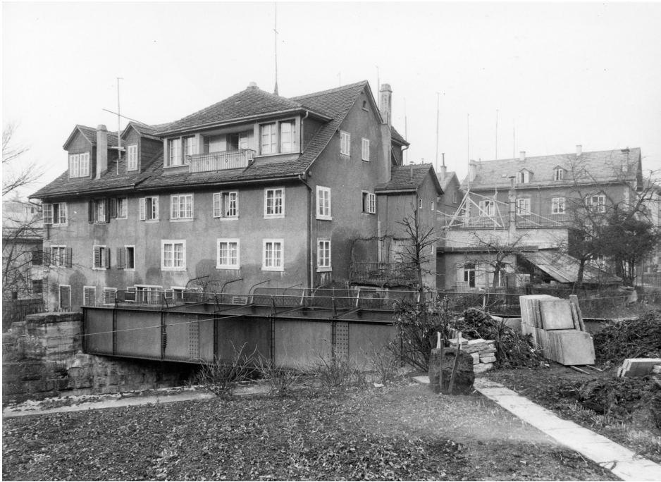
Überführung Nebelbach, zwischen 1950 und 1959, Ansicht von SO, Bild: Baugeschichtliches Archiv der Stadt Zürich, Bild Nr. DMP_038870, 01.01.1950 (Bild Nr. D101139_22).
