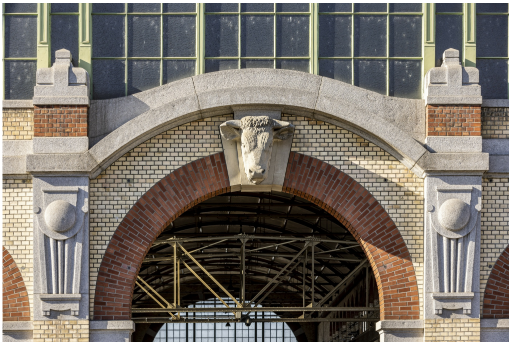
Schlachthofareal, ehem. Schlachthallen mit Kühl- und Kesselhaus (261AU03079), Südostfassade, Haupteingang mit Stierkopf und Blick in die Verbindungshalle, 11.02.2022 (Bild Nr. D102182_16).
