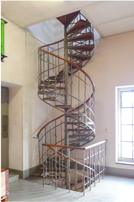
Schlachthofareal, Transformatorenhaus (261AU03108), Turm, 1. OG, bauzeitliche Wendeltreppe, 06.03.2018 (Bild Nr. D104020_20).
