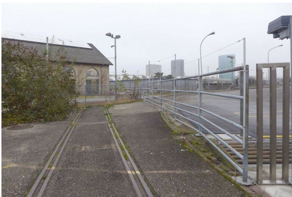
Schlachthofareal, Reste der Gleisanlagen (261AUGLEIS03230), Abzweiggleis nach SW zum Kesselhaus (261AU03079), Blick nach NO, im Hintergrund die Montagehalle VIII der Hauptwerkstätten der SBB (261AU03200), 06.03.2018 (Bild Nr. D104020_36).
