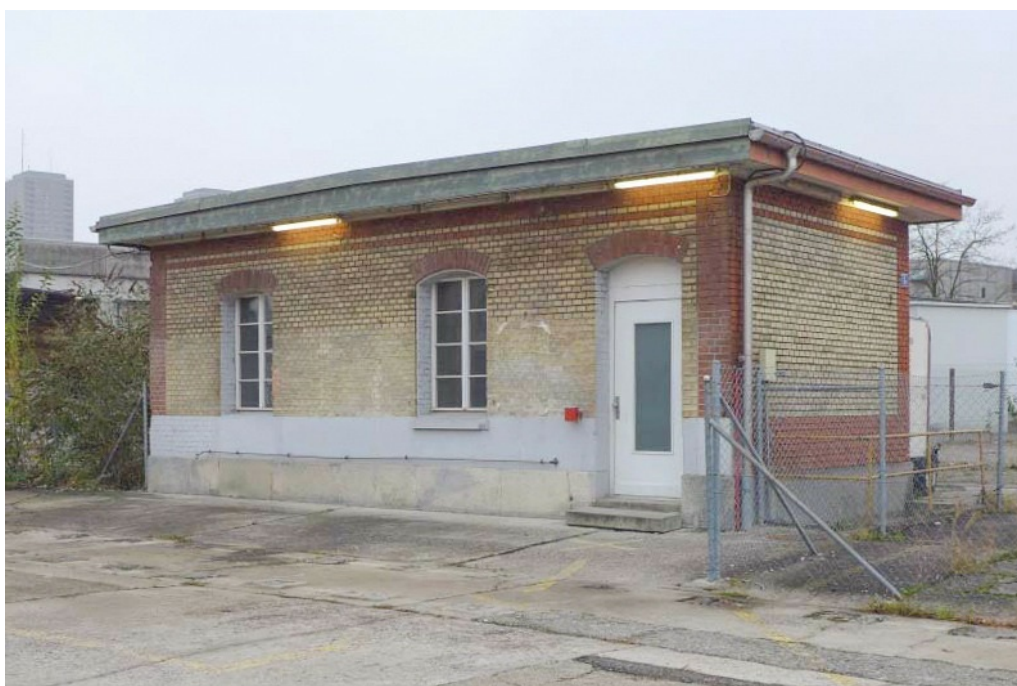
Schlachthofareal, ehem. Desinfektionshaus (261AU03230), Ansicht von N, 06.03.2018 (Bild Nr. D104020_14).
