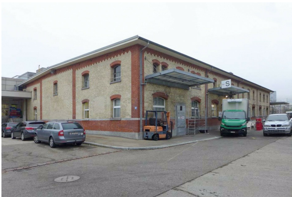
Schlachthofareal, ehem. Stallungen für Grossvieh (261AUGROSS03185), Ansicht von S, 06.03.2018 (Bild Nr. D104020_10).
