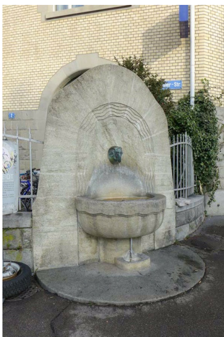
Schlachthofareal, Brunnen mit Widderkopf (261AUBRUNN03118), Ansicht von S, 06.03.2018 (Bild Nr. D104020_32).
