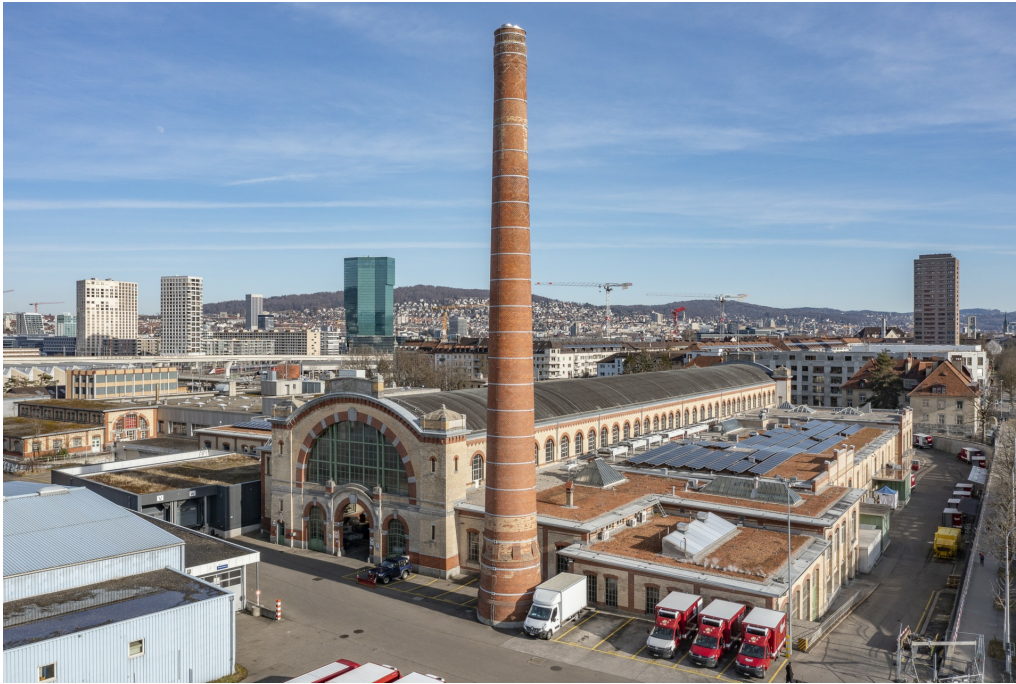
Schlachthofareal, Luftaufnahme von W, 11.02.2022 (Bild Nr. D102182_32).
