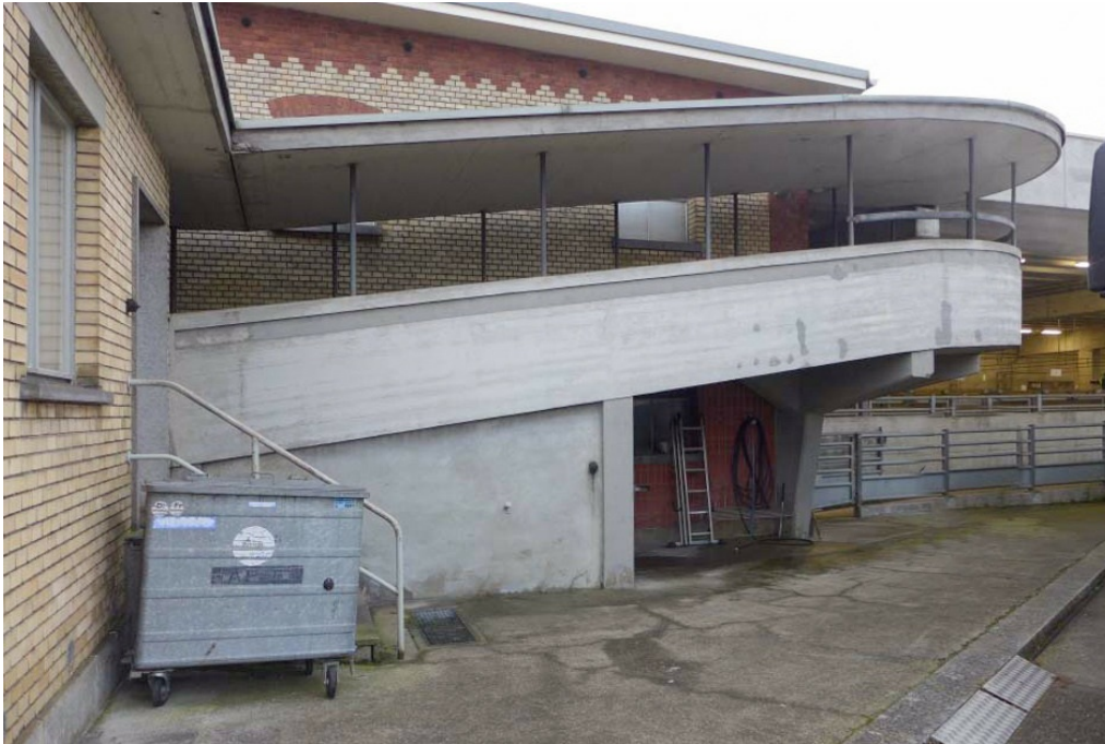
Schlachthofareal, ehem. Stallungen für Grossvieh (261AUGROSS03185), Rampe, Ansicht von NO, 06.03.2018 (Bild Nr. D104020_11).
