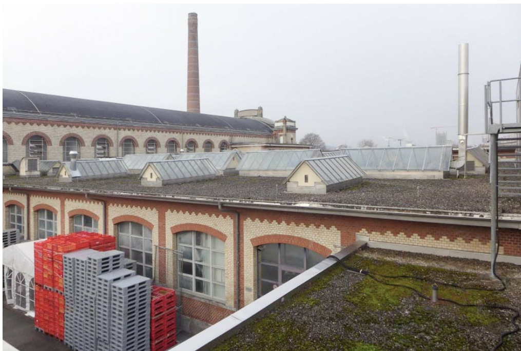
Schlachthofareal, ehem. Schlachthallen mit Kühl- und Kesselhaus (261AU03079), Schlachthalle für Schweine, Ansicht von O, 06.03.2018 (Bild Nr. D104020_07).
