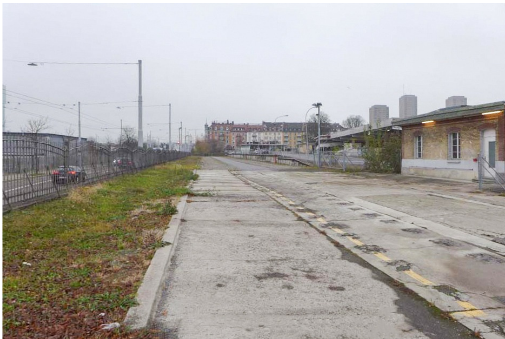
Schlachthofareal, Reste der Gleisanlagen (261AUGLEIS03230), Trasse der ehem. Zubringergleise, links die Einfriedung (261AUEINFR03229), rechts das ehem. Desinfektionshaus (261AU03230), Blick nach SO, 06.03.2018 (Bild Nr. D104020_35).
