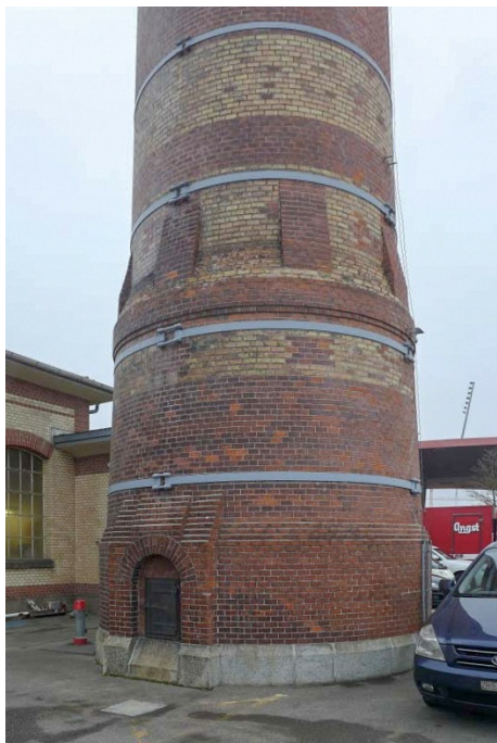
Schlachthofareal, Hochkamin (261AUKAMIN03079), Sockelgeschoss und unterster Bereich des Kaminschafts, Ansicht von N, 06.03.2018 (Bild Nr. D104020_43).
