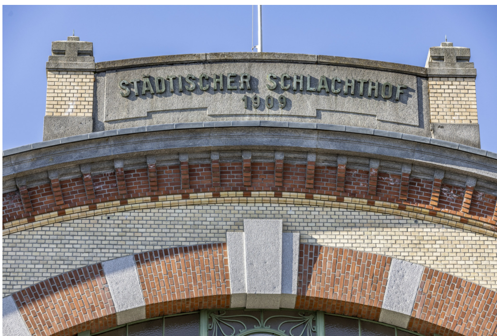
Schlachthofareal, ehem. Schlachthallen mit Kühl- und Kesselhaus (261AU03079), Südostfassade, oberer Abschluss über dem Haupteingang, darüber Inschrift «STÄDTISCHER SCHLACHTHOF 1909», 11.02.2022 (Bild Nr. D102182_20).
