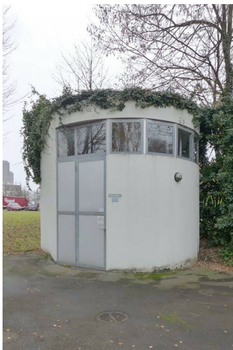
Schlachthofareal, Pumpenhaus (261AU04816), Ansicht von N, 06.03.2018 (Bild Nr. D104020_41).
