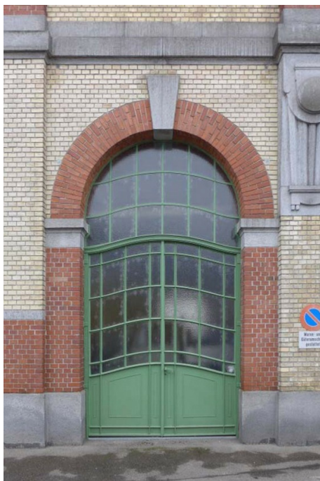
Schlachthofareal, ehem. Schlachthallen mit Kühl- und Kesselhaus (261AU03079), Verbindungshalle, Nordwestfassade, bauzeitlich erhaltenes Tor, 06.03.2018 (Bild Nr. D104020_03).
