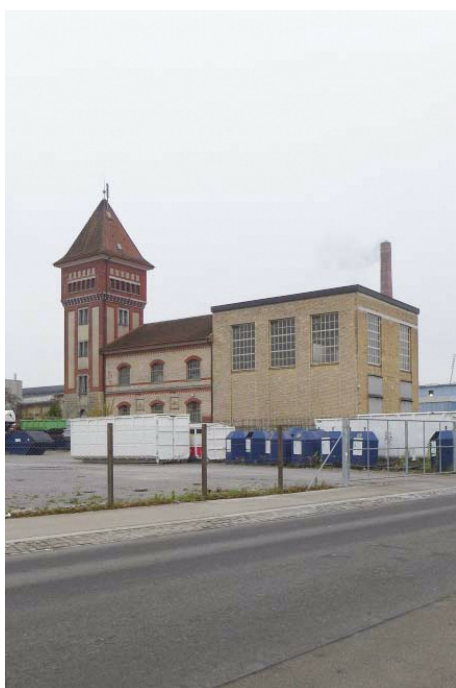
Schlachthofareal, Transformatorenhaus (261AU03108), Ansicht von N, 06.03.2018 (Bild Nr. D104020_18).
