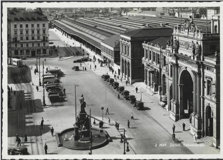
Hauptbahnhof, Bahnhofplatz mit Alfred-Escher-Brunnen (261AABRUNNEN00001) und Bahnhofgebäude (261AA01592) sowie Querhalle und Perrondächer (261AAPERRON00001) hinten, zwischen 1933 und 1940, Ansicht von SO, Bild: ETH-Bildarchiv, Sign. PK_009852, 01.01.1933 (Bild Nr. D101382_77).
