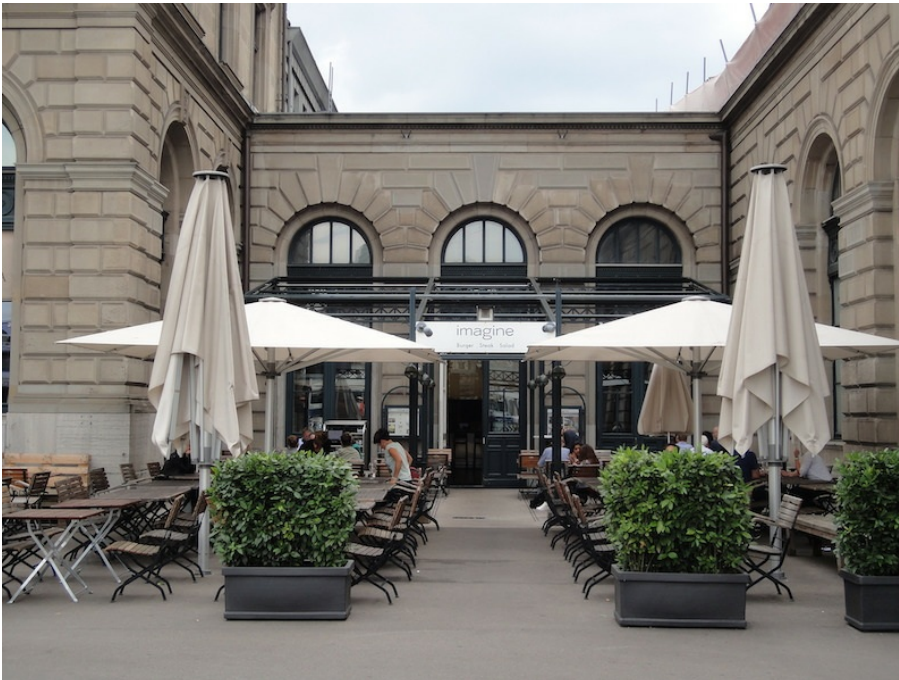
Hauptbahnhof, Bahnhofgebäude, Bahnhofhalle und Erweiterungsbau (261AA01592), eingeschossiger Zwischentrakt zwischen dem Bahnhofgebäude (links) und der Bahnhofhalle (rechts), Ansicht von SO, 12.07.2019 (Bild Nr. D101382_76).
