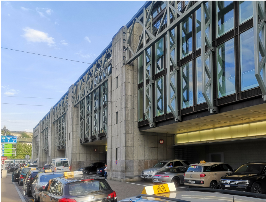
Hauptbahnhof, Bahnhofgebäude, Bahnhofhalle und Erweiterungsbau (261AA01592), Nordosttrakt, Nordostfassade, Ansicht von NW, 12.07.2019 (Bild Nr. D101382_91).
