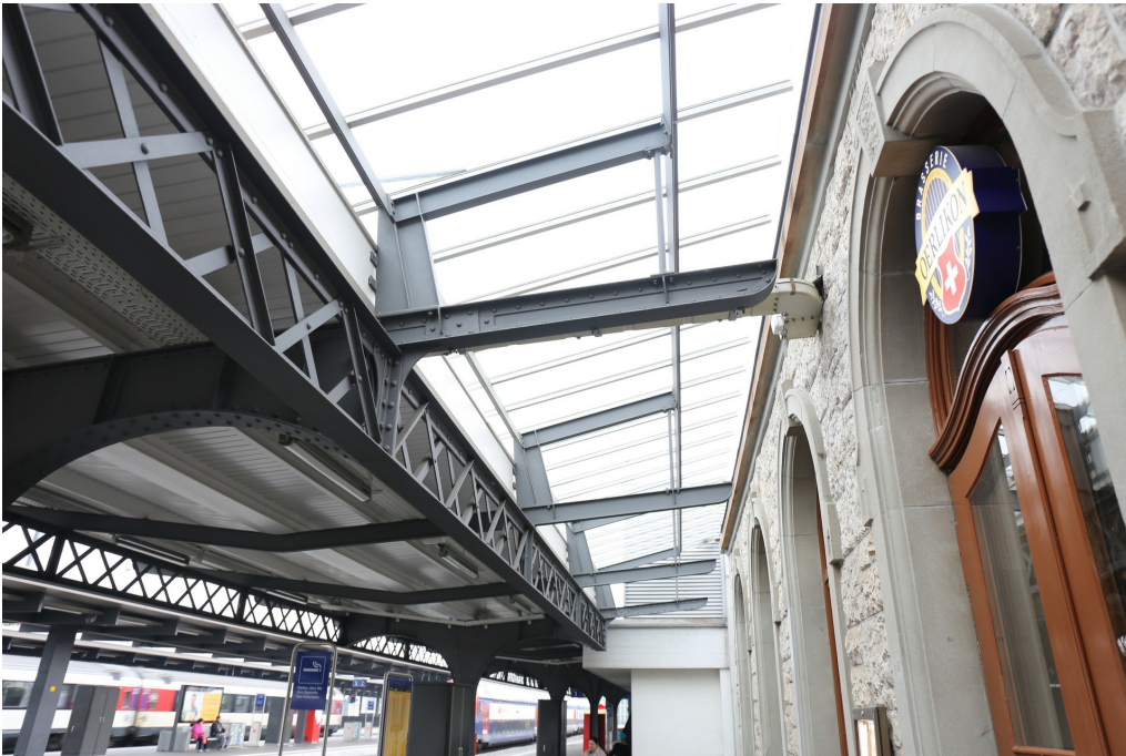
Bahnhof Zürich Oerlikon, Perrondach (261OEPERRON00068), Untersicht mit nachträglich erhöhtem Glasband und Teil der Nordwestfassade des Aufnahmegebäudes (261OE00068), 26.10.2018 (Bild Nr. D101353_45).
