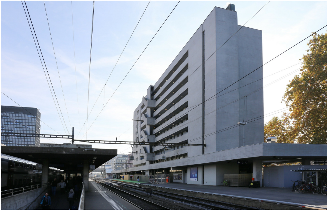
Bahnhof Zürich Altstetten, Bahnhofgebäude (261AL00700), Ansicht von NW mit Lift- und Treppenturm, Laubengängen und Feuertreppe, 27.10.2018 (Bild Nr. D101139_81).
