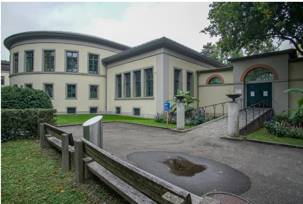
«Alte Anatomie», Hauptbau und Verbindungsgang, Ansicht von N, 08.10.2021 (Bild Nr. D101393_44).
