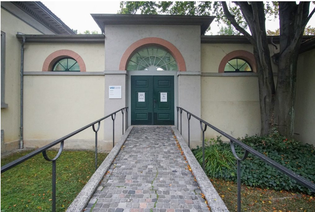
«Alte Anatomie», Verbindungsgang mit Eingang, Ansicht von NO, 08.10.2021 (Bild Nr. D101393_50).
