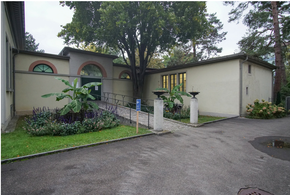
«Alte Anatomie», Verbindungsgang und Flügelbau, Ansicht von NO, 08.10.2021 (Bild Nr. D101393_43).
