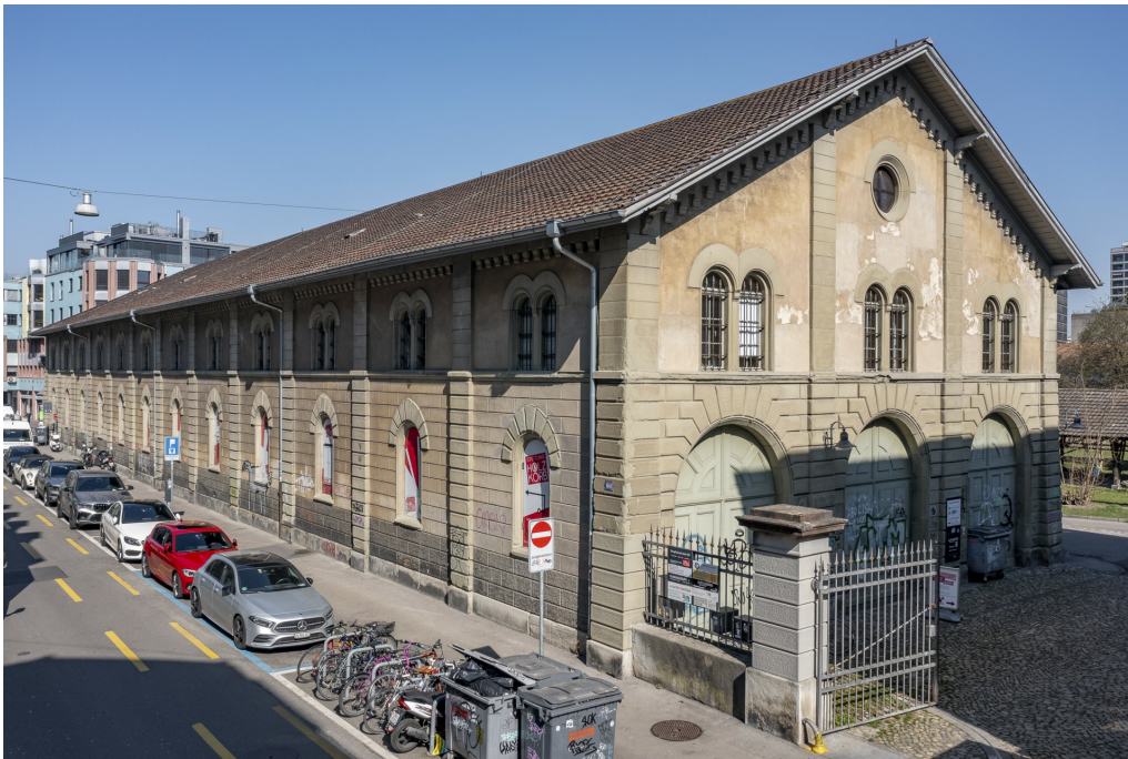
Kasernenareal, ehem. Zeughaus 5 (261AU00569), Ansicht von S, 23.03.2022 (Bild Nr. D102191_12).
