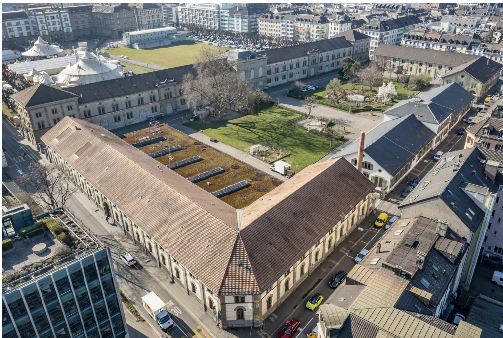
Kasernenareal, ehem. Zeughäuser und Zeughaushof, Luftaufnahme von N, 23.03.2022 (Bild Nr. D102191_15).
