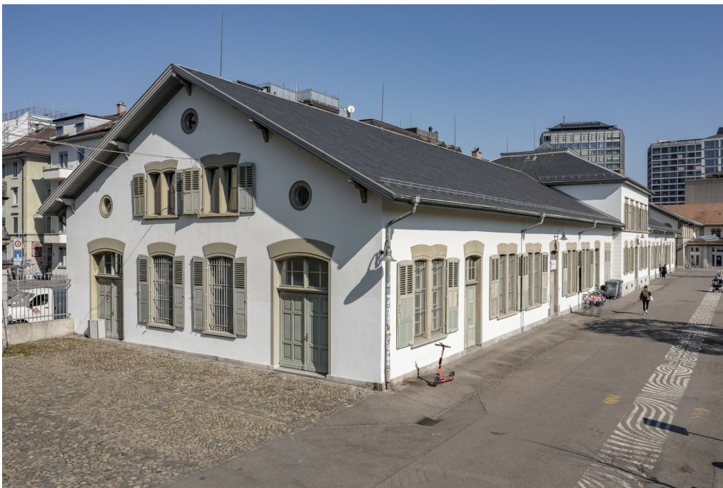
Kasernenareal, Zeughäuser 1, 2 und 5, ehem. Zeughaus 1 (261AU00567), Ansicht von S, 23.03.2022 (Bild Nr. D102190_73).
