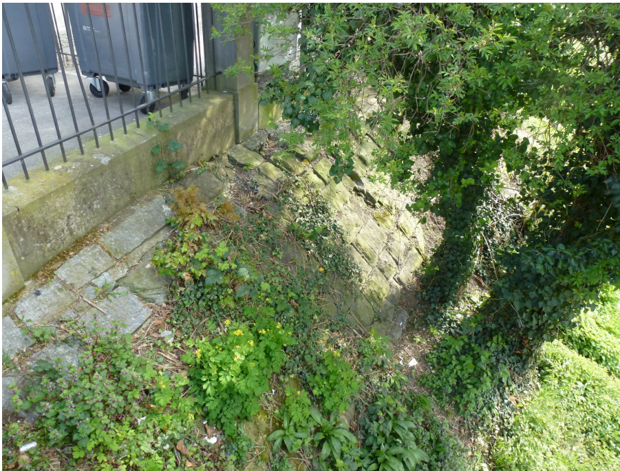
Kasernenareal, Umgebung (261AAUMGEBU01613), bauzeitliche Pflasterung der Sihlböschung, Bild: Peter Stöckli, SKK Landschaftsarchitekten, 02.06.2021 (Bild Nr. D100913_92).
