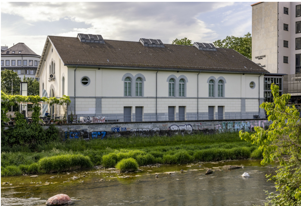
Kasernenareal, ehem. kleine Reithalle (261AA01652), Ansicht von NW, 11.05.2022 (Bild Nr. D102194_28).
