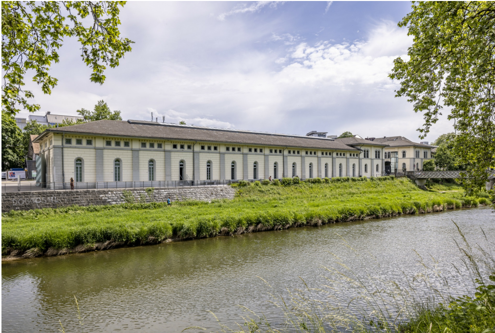
Kasernenareal, ehem. Zeughaus (261AA01654), rechts die Militärbrücke (261AUBRUECK00730), Ansicht von N, 11.05.2022 (Bild Nr. D102194_43).
