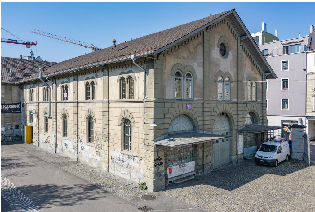
Kasernenareal, ehem. Zeughaus 5 (261AU00569), Ansicht von O, 23.03.2022 (Bild Nr. D102190_20).
