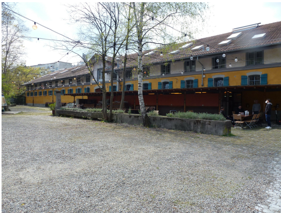
Kasernenareal, ehem. grosse Reithalle mit Stallungen (261AA01613), Ansicht von O, davor der südwestliche Hinterhof mit Tränkebrunnen und Teilen der bauzeitlichen Pflästerung (261AAUMGEBU01613), Bild: Peter Stöckli, SKK Landschaftsarchitekten, 02.06.2021 (Bild Nr. D100913_91).
