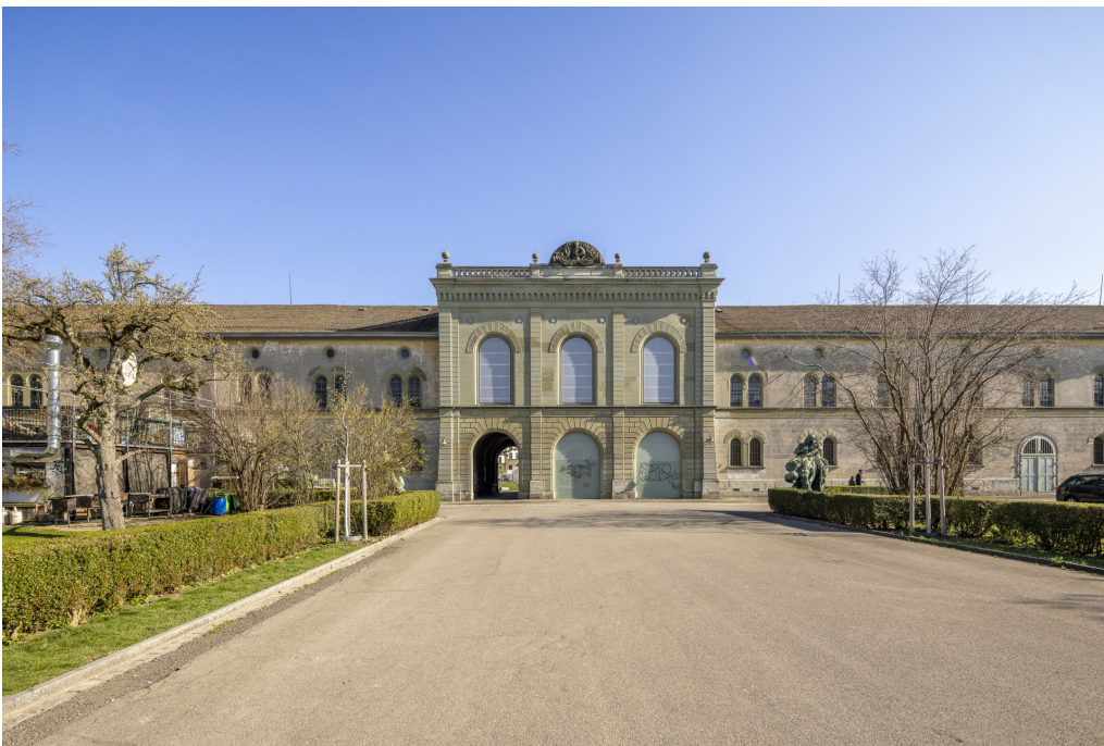
Kasernenareal, ehem. Zeughäuser 3 und 4 mit Waffensaal (261AU00577), Mitteltrakt mit Waffensaal, Ansicht von NW, 23.03.2022 (Bild Nr. D102190_49).
