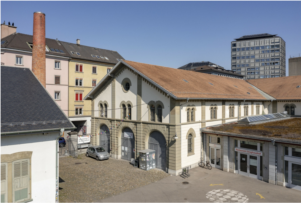
Kasernenareal, ehem. Zeughaus 2 (261AU00568), Ansicht von S, 23.03.2022 (Bild Nr. D102190_77).
