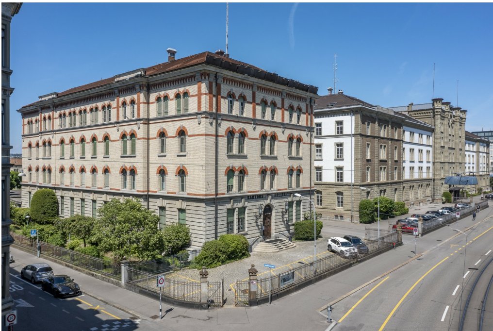
Kasernenareal, links die «Polizeikasernen» (261AU02923), rechts die «Militärkasernen» (261AU00730), Ansicht von S, 11.05.2022 (Bild Nr. D102194_64).
