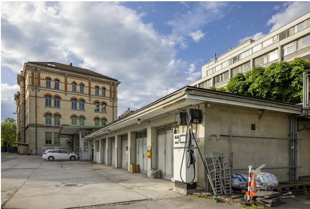
Kasernenareal, Garagengebäude (261AU04321), Ansicht von N, 11.05.2022 (Bild Nr. D102193_28).
