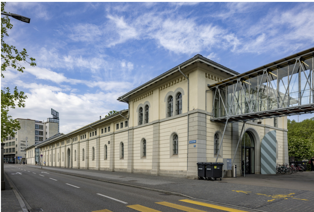
Kasernenareal, Ehem. Stallungen (261AA01653), Ansicht von NO, 11.05.2022 (Bild Nr. D102194_35).
