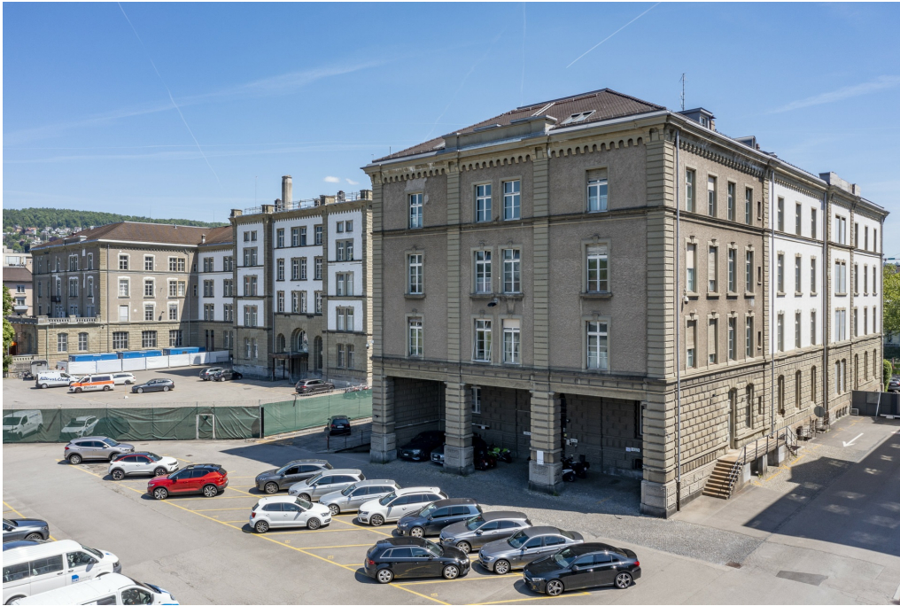
Kasernenareal, «Militärkasernen» (261AU00730) und ehem. Kasernenhof (261AUUMGEBU00567), im Vordergrund der verlängerte Südwestflügel, Ansicht von NW, 11.05.2022 (Bild Nr. D102195_05).
