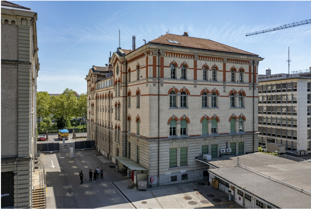
Kasernenareal, «Polizeikaserne» (261AU02923), Ansicht von N, 11.05.2022 (Bild Nr. D102194_65).
