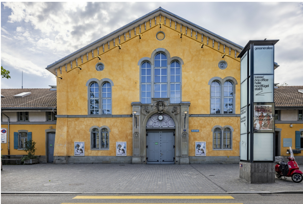
Kasernenareal, ehem. grosse Reithalle mit Stallungen (261AA01613), Mitteltrakt (ehem. grosse Reithalle) als Quergiebel, Ansicht von NW, 11.05.2022 (Bild Nr. D102194_09).
