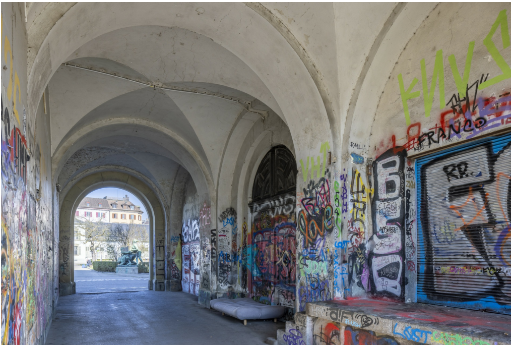
Kasernenareal, ehem. Zeughäuser 3 und 4 mit Waffensaal (261AU00577), gewölbter Durchgang im EG des Mitteltrakts von der ehem. Exerzierwiese in den Zeughaushof, Ansicht von SO, 23.03.2022 (Bild Nr. D102190_05).
