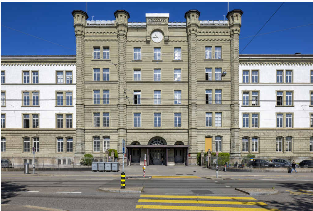
Kasernenareal, «Militärkaserne» (261AU00730), Hauptflügel, Mittelrisalit, Ansicht von SO, 11.05.2022 (Bild Nr. D102194_66).
