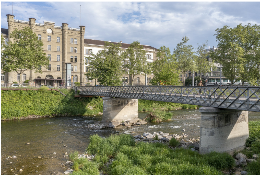
Kasernenareal, Militärbrücke (261AUBRUECK00730), Ansicht von SO, im Hintergrund die «Militärkaserne» (261AU00730), 11.05.2022 (Bild Nr. D102195_17).
