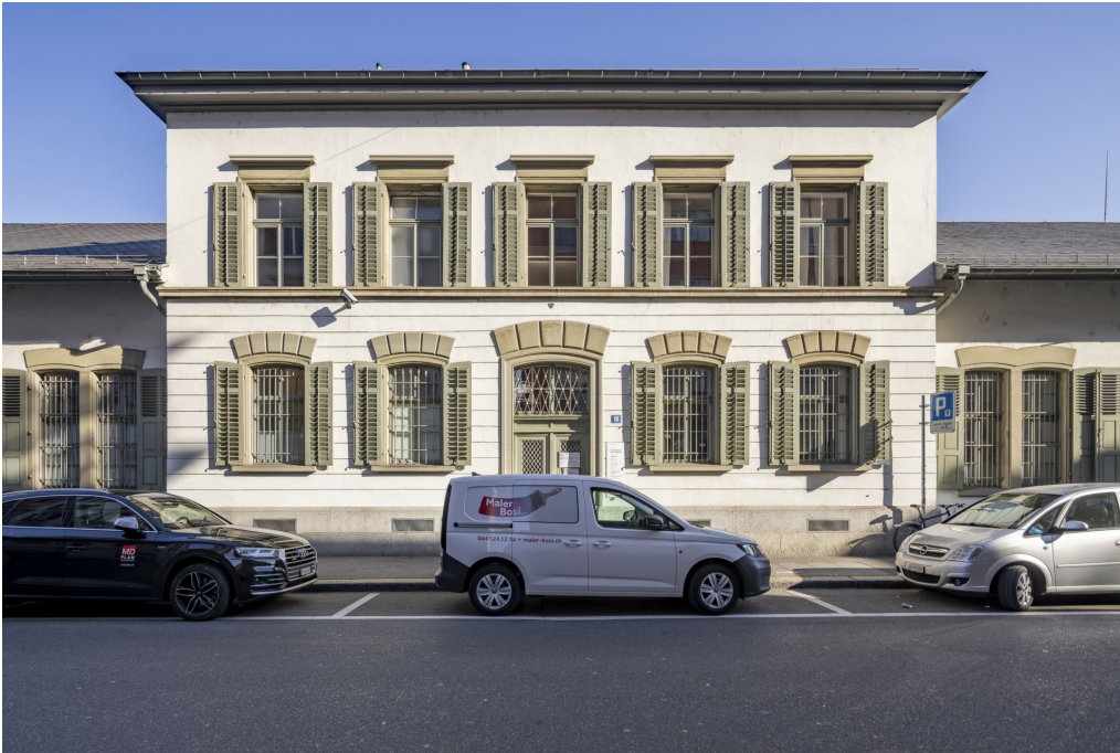
Kasernenareal, ehem. Zeughaus 1 (261AU00567), Mitteltrakt, Ansicht von NW, 23.03.2022 (Bild Nr. D102190_25).
