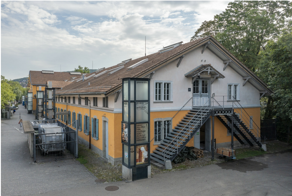
Kasernenareal, ehem. grosse Reithalle mit Stallungen (261AA01613), Ansicht von SW, 11.05.2022 (Bild Nr. D102194_22).
