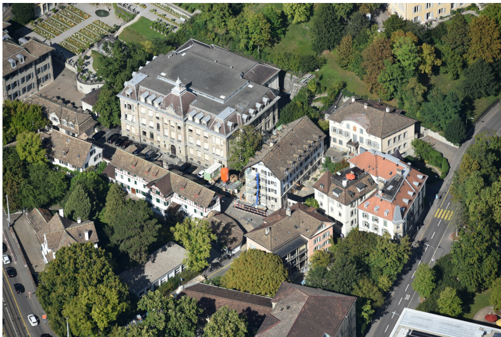
«Unterer Schönenberg», «Oberes Haus» (261AA00681) mit Umgebung (261AAUMGEBU00681) in der rechten Bildhälfte, links davon das «Untere Haus» (Florhofgasse 4; 261AA00671) und das Konservatorium (Florhofgasse 6; 261AA01073) Flugaufnahme von S, 26.09.2023 (Bild Nr. D101363_88).
