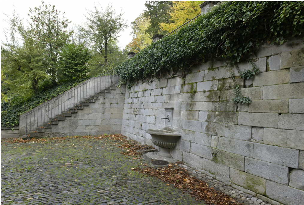
«Unterer Schönenberg», Stützmauer mit Wandbrunnen und Treppe (261AAUMGEBU00681), Ansicht von SO, 01.11.2022 (Bild Nr. D102200_58).
