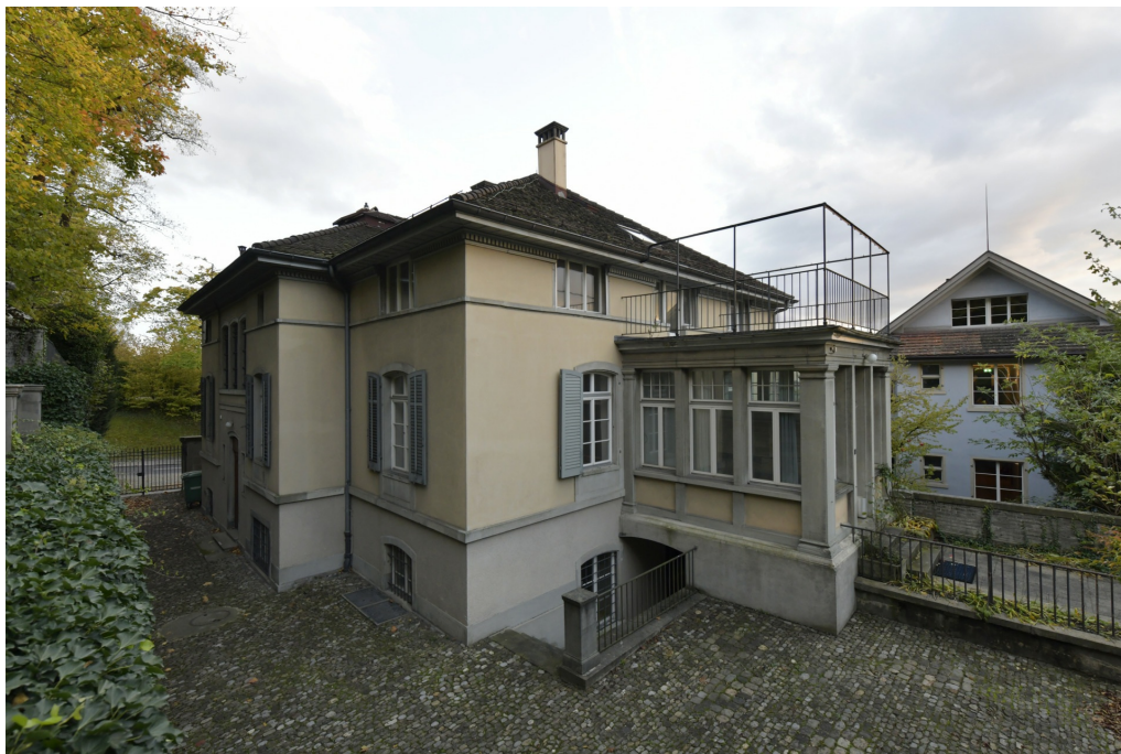
«Unterer Schönenberg», Verandaanbau des «Oberen Hauses» (261AA00681) und rückseitige Durchfahrt (261AAUMGEBU00681), Ansicht von N, 01.11.2022 (Bild Nr. D102200_28).
