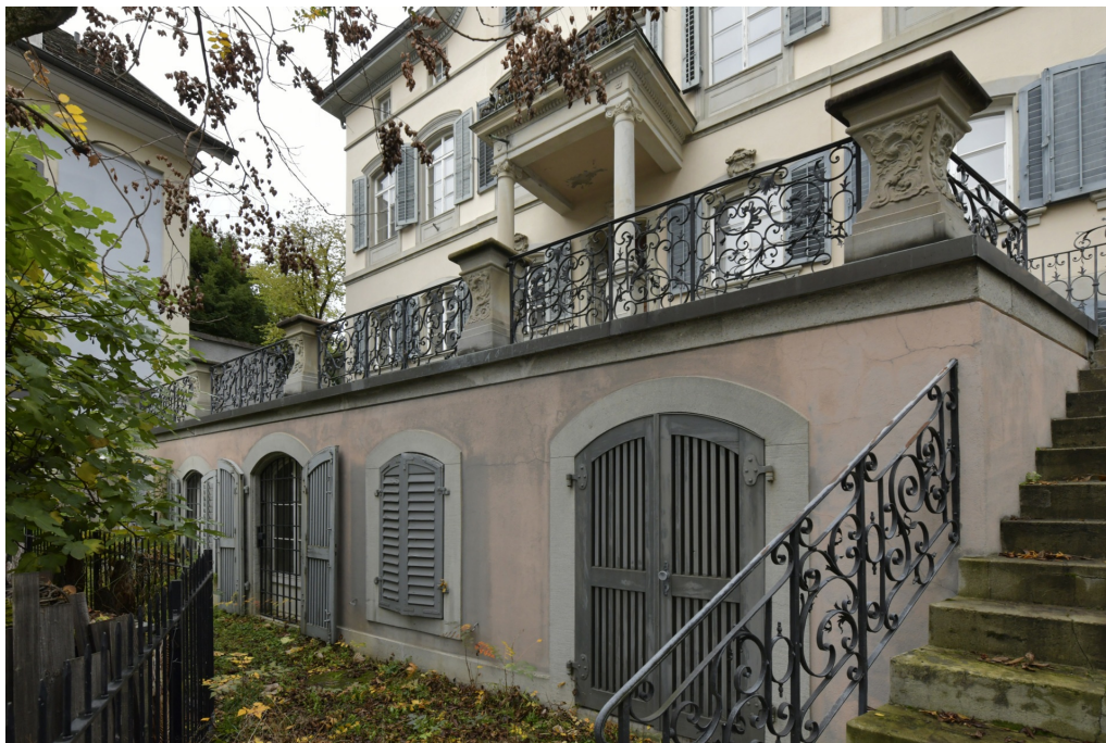
«Unterer Schönenberg», «Oberes Haus» (261AA00681) mit Treppe und Teil der Einfriedung (261AAUMGEBU00681), Ansicht von S, 01.11.2022 (Bild Nr. D102200_50).
