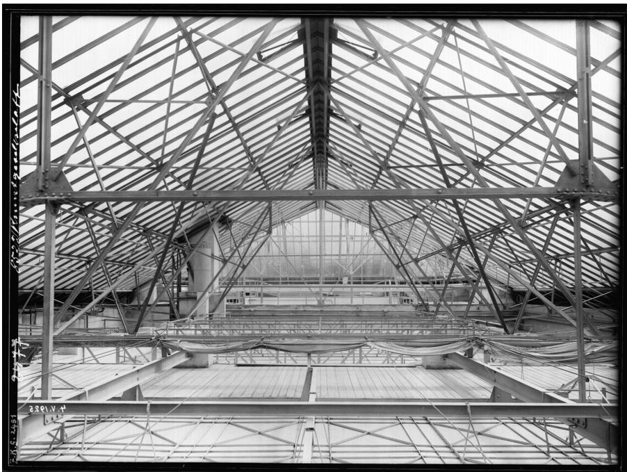
Kunsthhaus Zürich, «Moser-Bau», Eisenfachwerkkonstruktion des Glaswalmdachs, 14.01.1925 (Bild Nr. D104054\_14).
