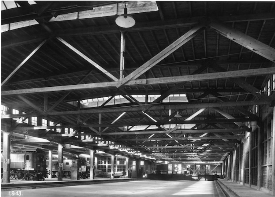
«Lokomotivremise G», Schiebebühnenhalle West (261AUSCHIEB04007-1), hölzernes Tragwerk in einer der Schiebebühnenhallen vor der Verstärkung, Bild: Baugeschichtliches Archiv Zürich, Sign. 18395, 01.01.1943 (Bild Nr. D101395_04).
