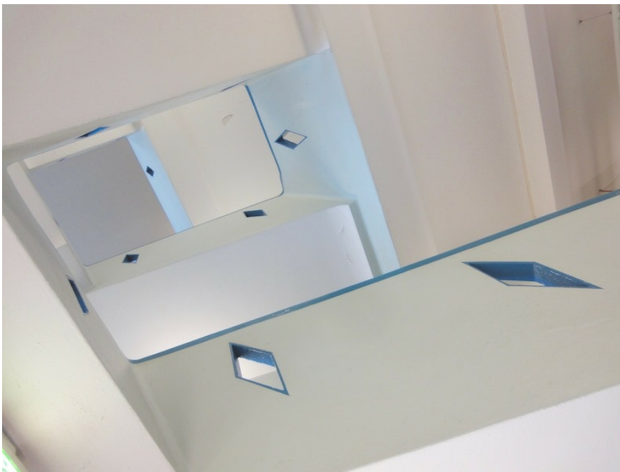
«Lokomotivremise G», Dienstgebäude (261AUDIENST04007), Treppenhaus, 21.12.2016 (Bild Nr. D101395_11).
