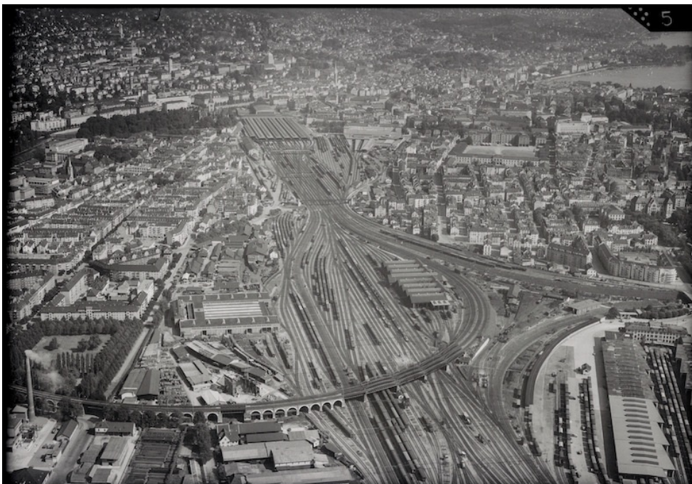
«Lokomotivremise G», Luftaufnahme des Gleisfelds, in der Mitte die «Lokomotivremise G», Ansicht von O, Bild: ETH-Bildarchiv, Sign. LBS_H1-009977, 13.08.1947 (Bild Nr. D101395_01).
