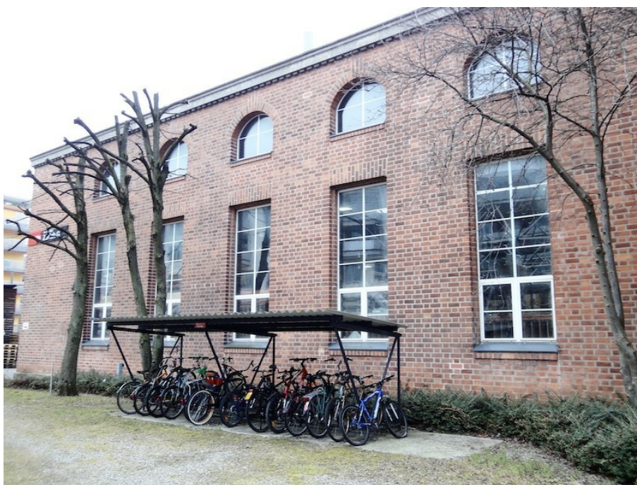
«Lokomotivremise G», Schiebebühnenhalle West (261AUSCHIEB04007-1), Ansicht von NW, 21.12.2016 (Bild Nr. D101395_07).
