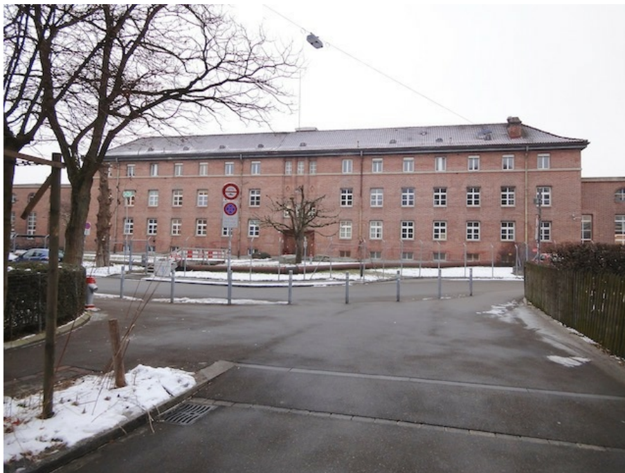
«Lokomotivremise G», Dienstgebäude (261AUDIENST04007), Ansicht von NO, 21.12.2016 (Bild Nr. D101395_06).
