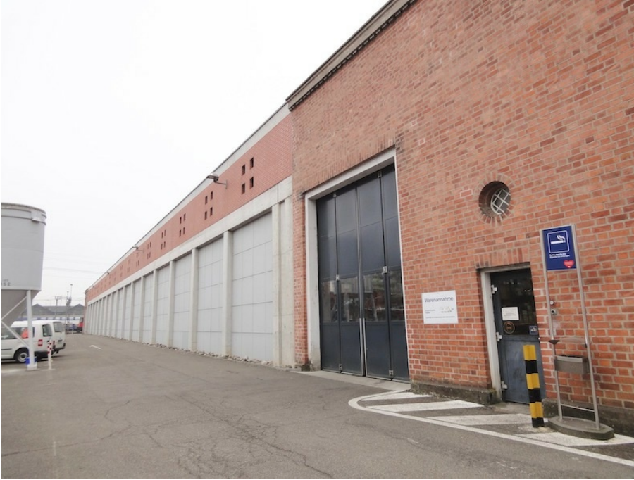
«Lokomotivremise G», Schiebebühnenhalle Ost (261AUSCHIEB04007-2), Südostfassade mit nach Brand ergänztem Mittelteil, 21.12.2016 (Bild Nr. D101395_08).
