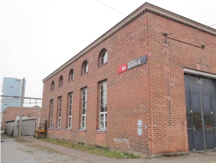
«Lokomotivremise G», Schiebebühnenhalle Ost (261AUSCHIEB04007-2), Ansicht von S, 21.12.2016 (Bild Nr. D101395_09).
