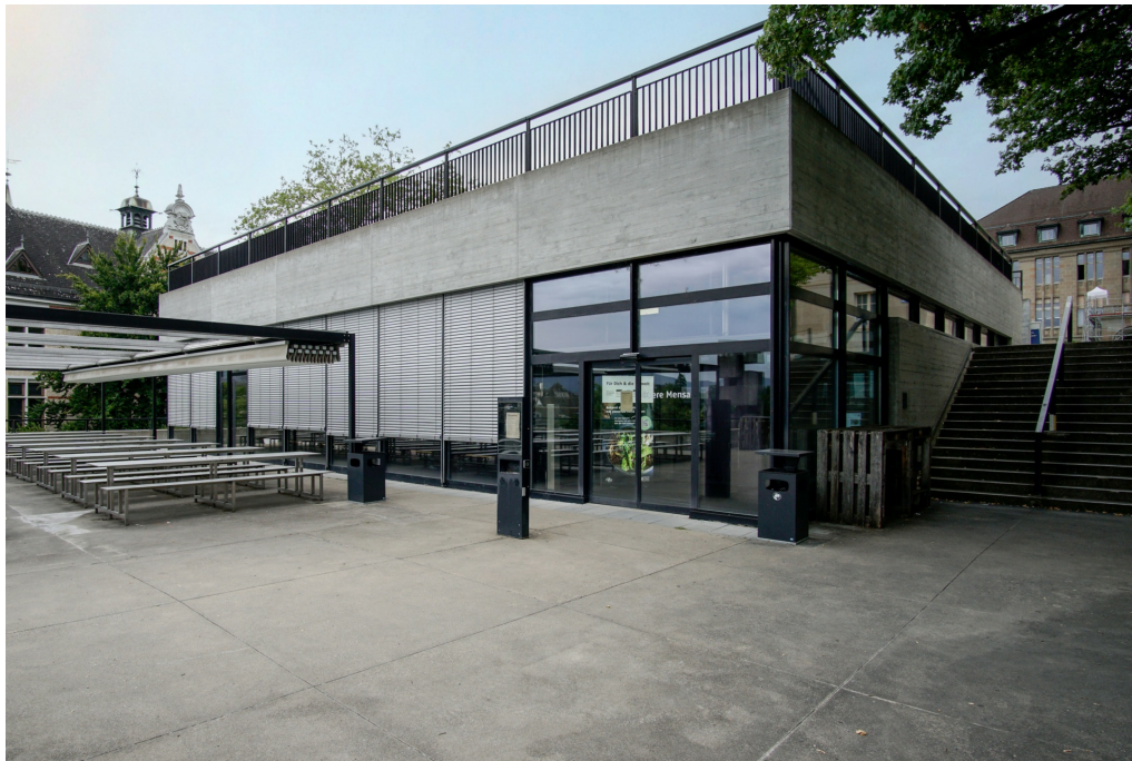
Universität Zürich, Mensa (261AAMENSA01102), OG, Ansicht von SO, 16.08.2023 (Bild Nr. D102621_08).
