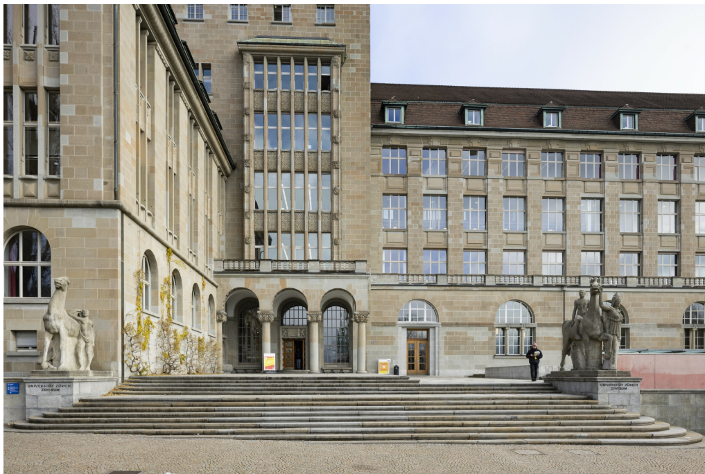
Universität Zürich, Hauptgebäude (261AA01102) und Umgebung (261UMGEBU01102) mit Treppenaufgang beim Turmeingang in W des Hauptgebäudes (261AA01102), Ansicht von N, 20.12.2021 (Bild Nr. D102285_26).
