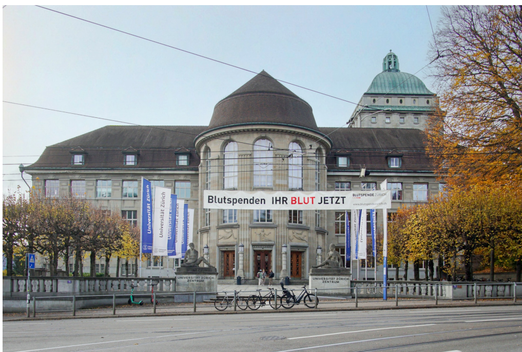
Universität Zürich, Hauptgebäude (261AA01102), Kollegiengebäude I mit Umgebung (261AAUMGEBU01102), Ansicht von O, 20.11.2023 (Bild Nr. D102621_97).
