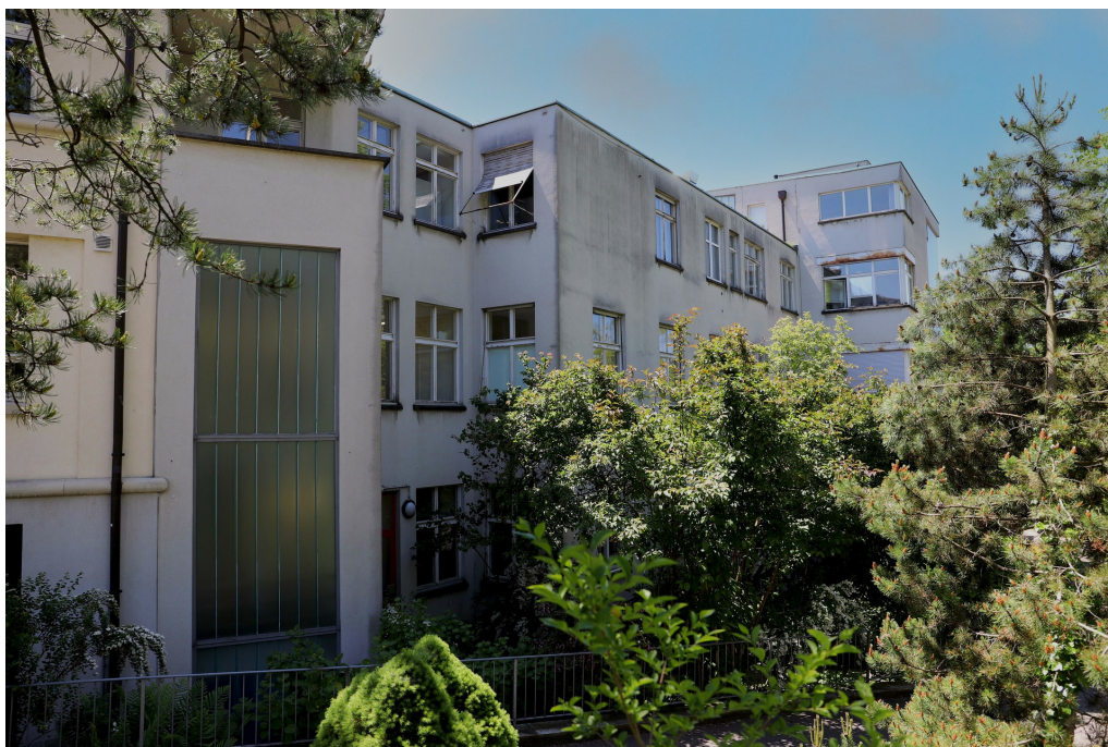
Kinderspital, ehem. Infektionshaus (261HO01462, Westflügel), Ansicht von NO, 29.05.2021 (Bild Nr. D101361_13).
