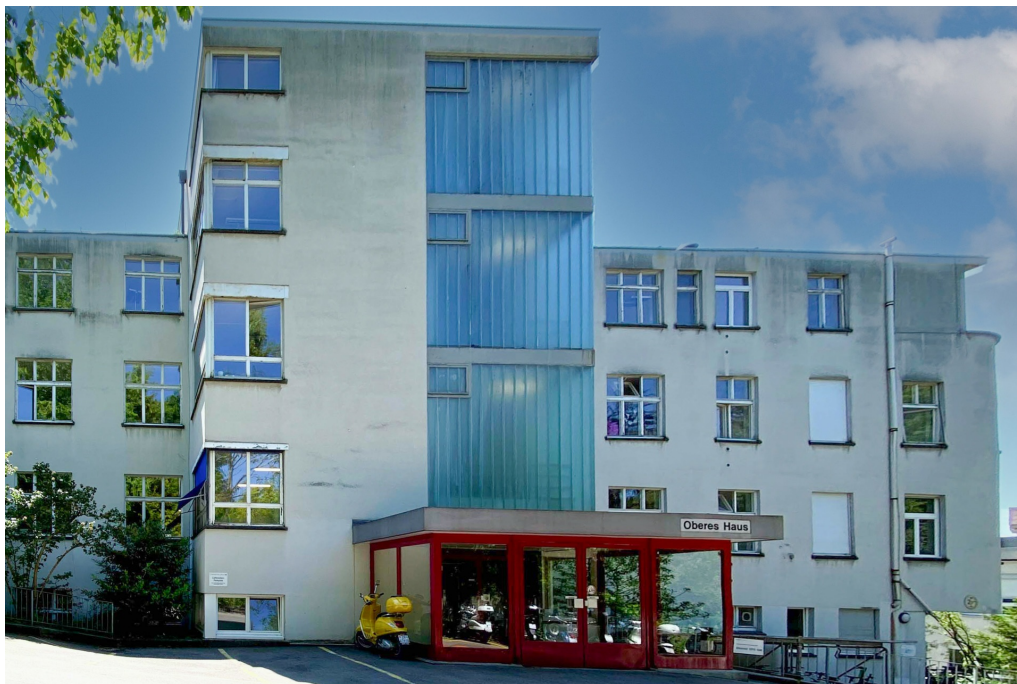
Kinderspital, ehem. Infektionshaus (261HO01462), Ansicht von N, 29.05.2021 (Bild Nr. D101361_12).
