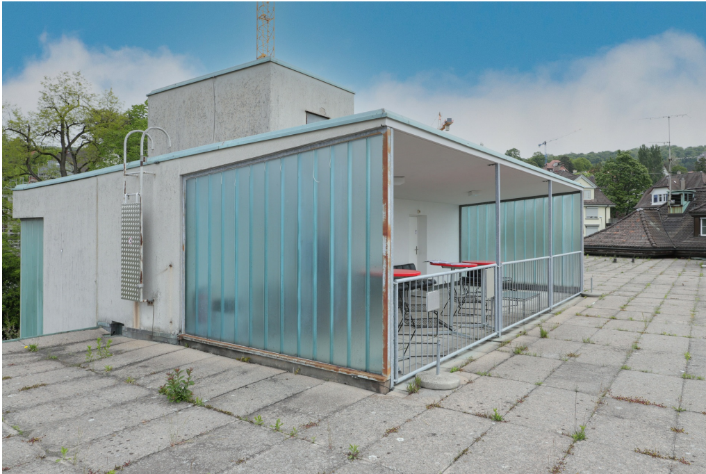
Kinderspital, ehem. Infektionshaus (261HO01462, Westflügel), oberstes Geschoss des Treppenhausturms mit Ausgang zur Dachterrasse, Ansicht von SW, 29.05.2021 (Bild Nr. D101361_17).
