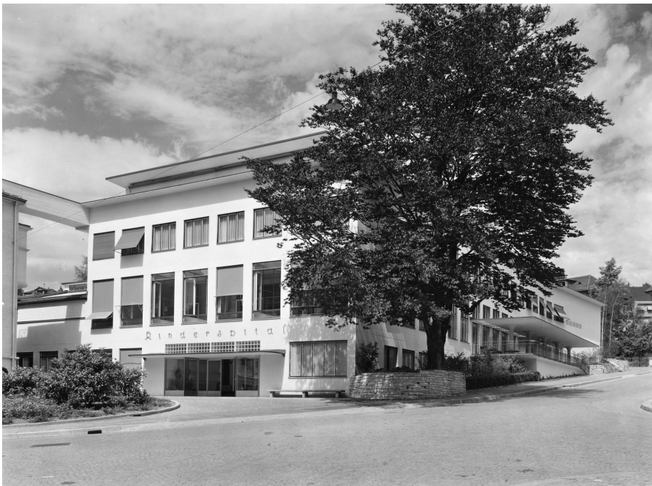
Kinderspital, Poliklinik (261HO01797), Ansicht von S, Bild: Baugeschichtliches Archiv, BAZ_118522, 01.01.1939 (Bild Nr. D101361_18).
