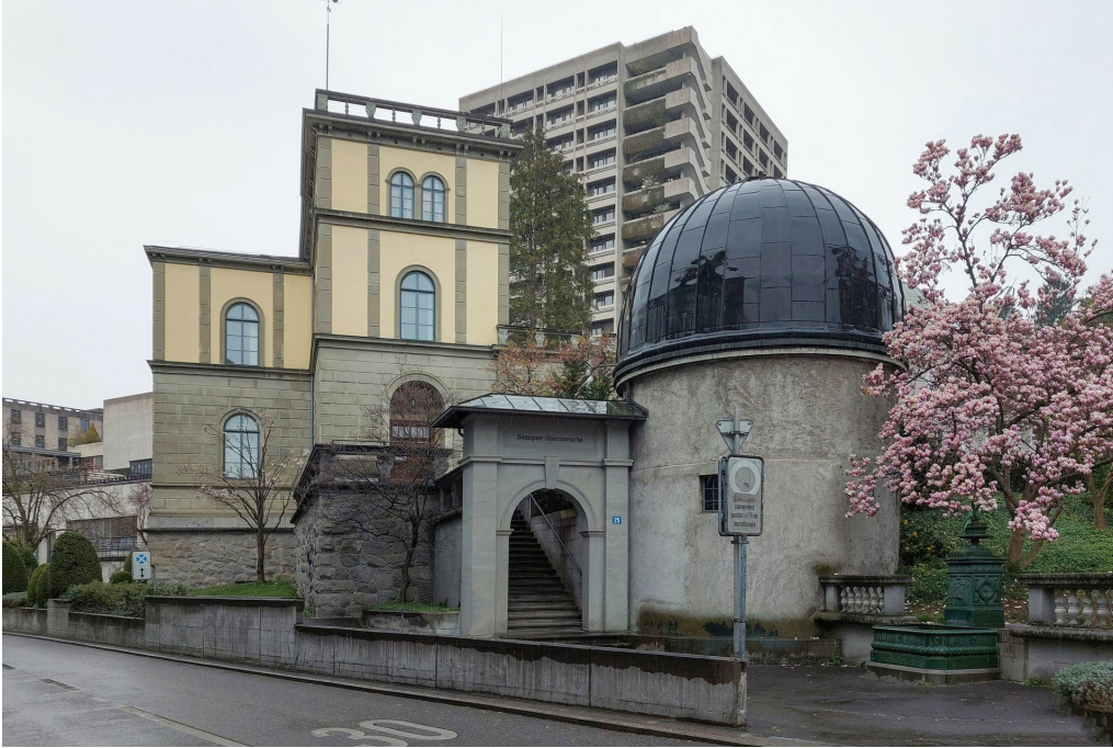
Ehem. eidgenössische Sternwarte, Ansicht von S, 30.03.2022 (Bild Nr. D104014_02).
