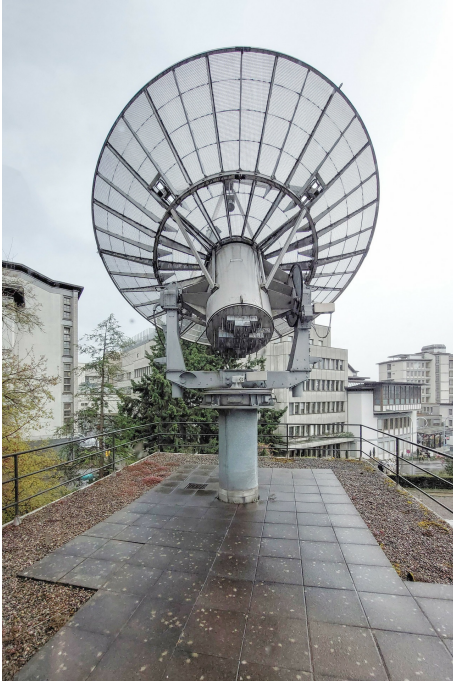
Ehem. eidgenössische Sternwarte, Sonnenbeobachtungsturm (261OBTURM00001), Dachterrasse des Südflügels mit Parabolantenne, 30.03.2022 (Bild Nr. D104014_72).
