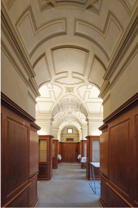
Ehem. eidgenössische Sternwarte, ehem. Sternwarte (261OBSTERNW00001), Nordwestflügel, Mittellängsgang, Ansicht von S, 30.03.2022 (Bild Nr. D104014_23).
