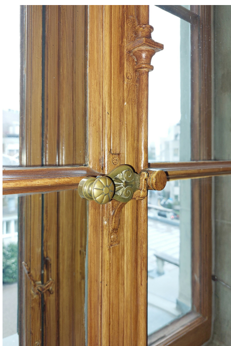
Ehem. eidgenössische Sternwarte, ehem. Sternwarte (261OBSTERNW00001), Nordwestflügel, Detailaufnahme eines bauzeitlichen Fensters, 30.03.2022 (Bild Nr. D104014_41).
