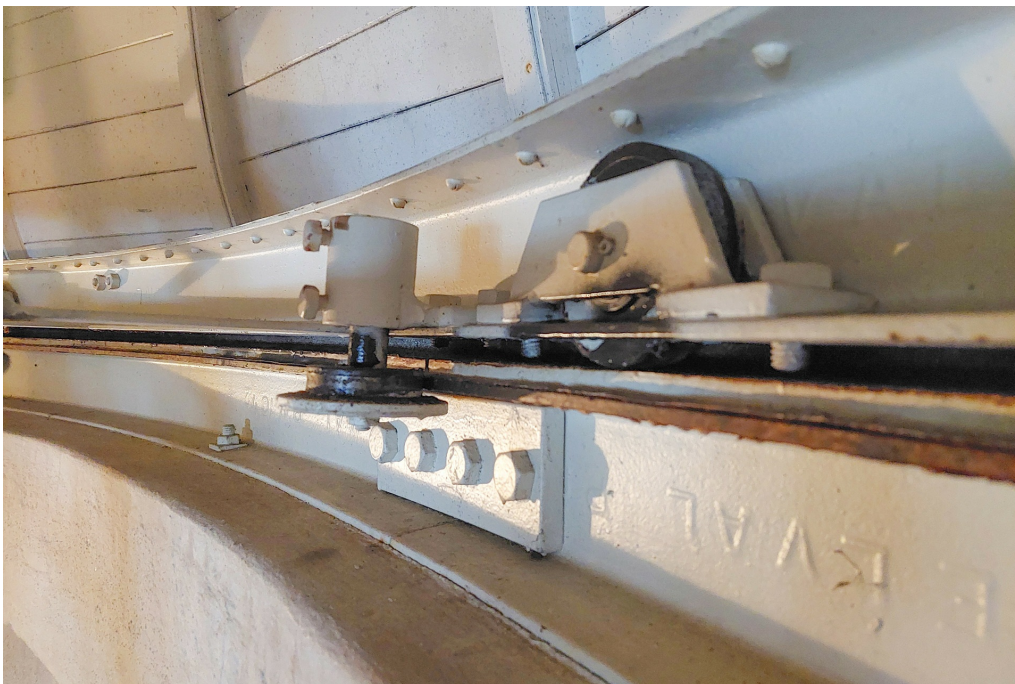
Ehem. eidgenössische Sternwarte, Sonnenbeobachtungsturm (261OBTURM00001), Turm, EG, Kuppel mit Schiene und Laufrad, 30.03.2022 (Bild Nr. D104014_75).
