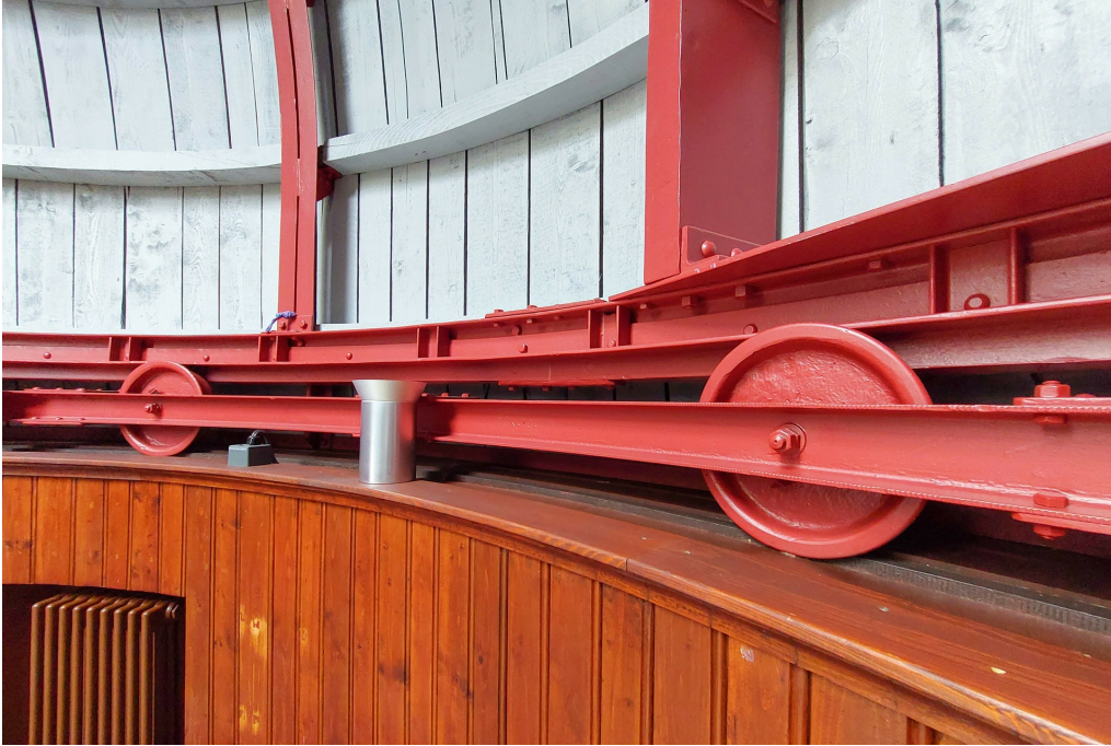
Ehem. eidgenössische Sternwarte, kleines Observatorium (261OBOBSERV00001), Kuppelraum, Schiene und Laufräder der Kuppel, 30.03.2022 (Bild Nr. D104014_84).
