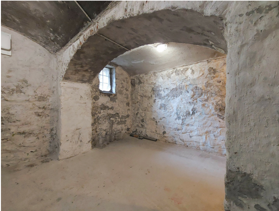
Ehem. eidgenössische Sternwarte, ehem. Sternwarte (261OBSTERNW00001), UG, gewölbte Kellerräume zwischen den Fundamentmauern, 30.03.2022 (Bild Nr. D104014_57).
