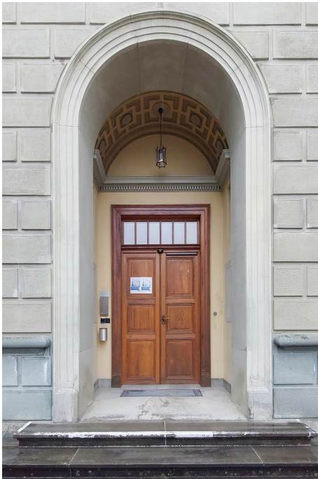
Ehem. eidgenössische Sternwarte, ehem. Sternwarte (261OBSTERNW00001), Haupteingang zum Nordwestflügel, Ansicht von S, 30.03.2022 (Bild Nr. D104014_06).
