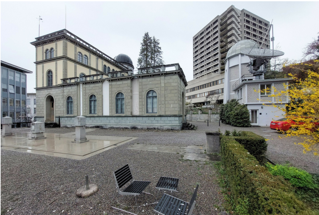
Ehem. eidgenössische Sternwarte, links die ehem. Sternwarte (261OBSTERNW00001), rechts der Sonnenbeobachtungsturm (261OBTURM00001), Ansicht von S, 30.03.2022 (Bild Nr. D104014_04).
