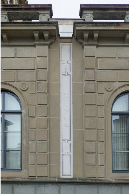
Ehem. eidgenössische Sternwarte, ehem. Sternwarte (261OBSTERNW00001), Südostflügel, Wandfeld mit astronomischem Instrument, Ansicht von S, 30.03.2022 (Bild Nr. D104014_17).
