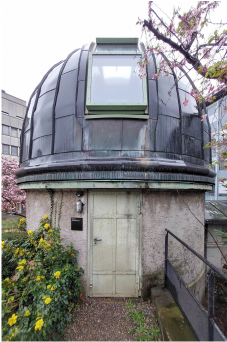
Ehem. eidgenössische Sternwarte, kleines Observatorium (261OBSERV00001), Ansicht von N, 30.03.2022 (Bild Nr. D104014_79).
