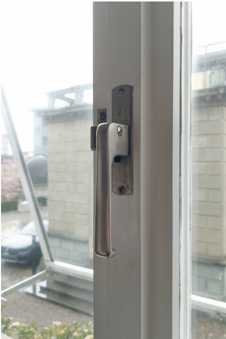
Ehem. eidgenössische Sternwarte, Sonnenbeobachtungsturm (261OBTURM00001), Südflügel, Büro im OG, Detailaufnahme eines bauzeitlichen Fensters, 30.03.2022 (Bild Nr. D104014_78).
