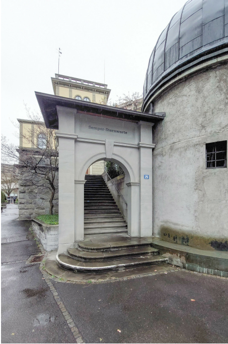
Ehem. eidgenössische Sternwarte, Umgebung (261OBUMGEBU00001), Treppenaufgang zur Beobachtungsterrasse mit Torbogen, Ansicht von SW, 30.03.2022 (Bild Nr. D104014_07).
