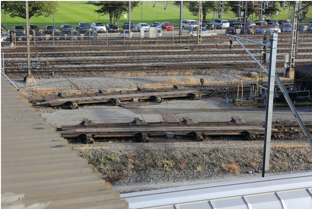
«Schnellgut-Stammbahnhof» Zürich Altstetten, die beiden Gleisbremsen am Ablaufberg westlich am Rangier- und Gleisbremsengebäude (261AL00081), Ansicht von SW, 25.10.2018 (Bild Nr. D101353_22).
