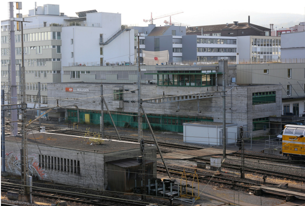
«Schnellgut-Stammbahnhof» Zürich Altstetten, Stellwerk (261AL00080), im Vordergrund das Rangier- und Gleisbremsengebäude (261AL00081), Ansicht von NW, 25.10.2018 (Bild Nr. D101353_20).
