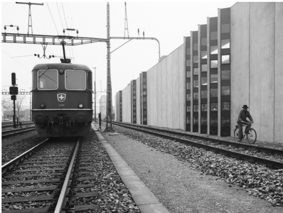
«Schnellgut-Stammbahnhof» Zürich Altstetten, rechts die «Schnellguthalle» (261AL00125) kurz nach der Fertigstellung, Ansicht von NW, Bild: SBB-Archiv, 01.01.1976 (Bild Nr. D101353_03).
