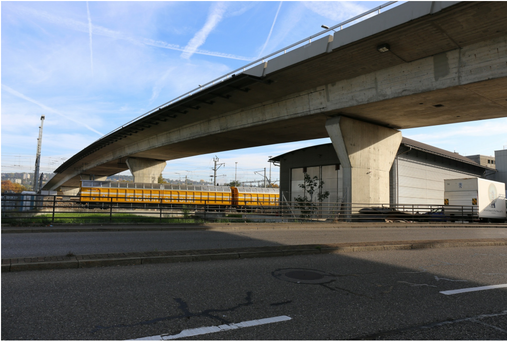
«Schnellgut-Stammbahnhof» Zürich Altstetten, Hermetschloobücke (261ALBRUECKE00001) mit oktogonalen Hammerkopfpfeilern und gekerbter Brüstung, Ansicht von SW, 25.10.2018 (Bild Nr. D101353_25).
