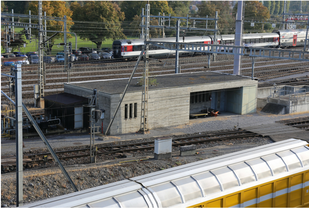
«Schnellgut-Stammbahnhof» Zürich Altstetten, Rangier- und Gleisbremsengebäude (261AL00081) mit der Rangierfunkantenne (rechts), Ansicht von SW, 25.10.2018 (Bild Nr. D101353_21).
