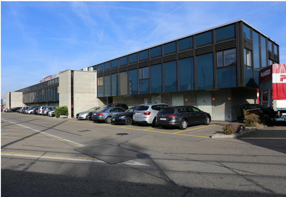
«Schnellgut-Stammbahnhof» Zürich Altstetten, Bürogebäude (261AL00002), Ansicht von SO, 25.10.2018 (Bild Nr. D101353_11).
