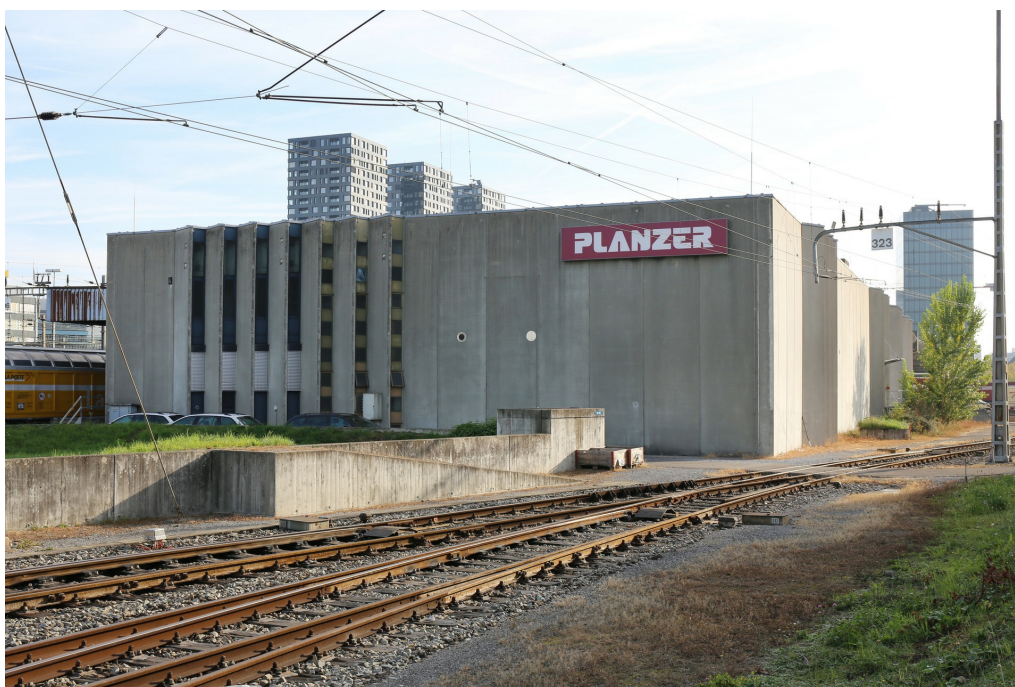
«Schnellgut-Stammbahnhof» Zürich Altstetten, «Schnellguthalle» (261AL00125), Ansicht von W, 25.10.2018 (Bild Nr. D101353_04).
