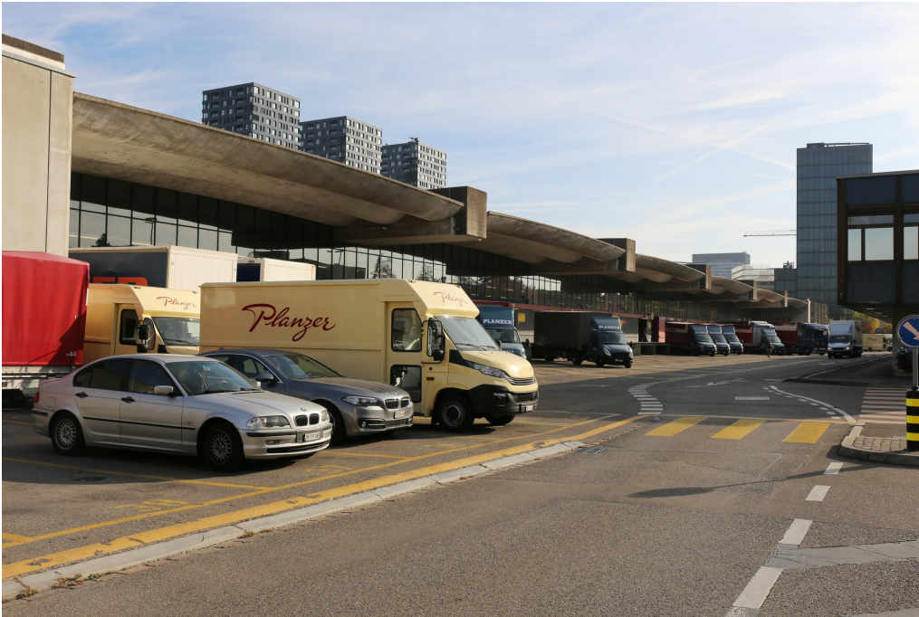
«Schnellgut-Stammbahnhof» Zürich Altstetten, «Schnellguthalle» (261AL00125), Lastwagenladerampe, Ansicht von SW, 25.10.2018 (Bild Nr. D101353_05).
