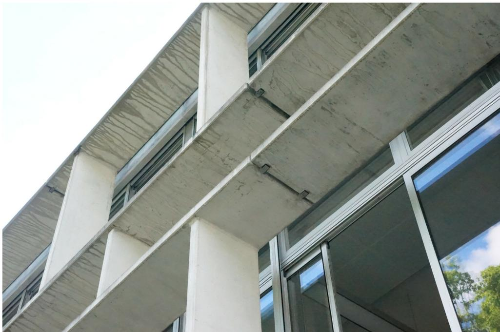
Erweiterungsbauten der Kantonsschule Rychenberg und Umgebung, Erweiterungsbau I (230ST06120), Ostfassade mit vorgehängten Betonelementen, sog. «Brisés-Soleil», 19.05.2014 (Bild Nr. D100616\_35).
