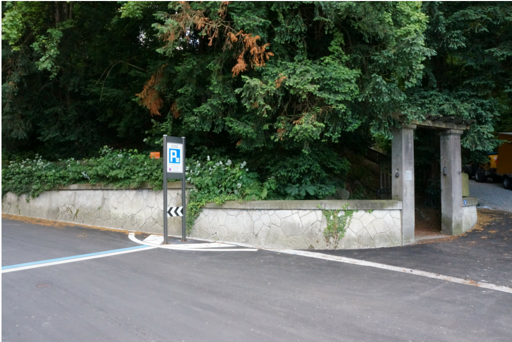
Ensemble Villa «Büel», Gartenanlage (230STGARTEN00228), Portal im NW der Anlage an der Ecke Büelrainstrasse/Turmhaldenstrasse, 23.06.2015 (Bild Nr. D100914_07).
