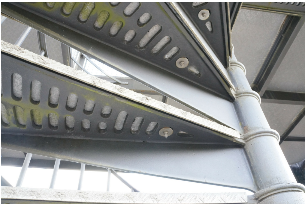
Aussichtsturm Eschenberg und Turmfussweg, Aussichtsturm Eschenberg (230MATURM01765), Treppenstufen, Ansicht von unten, 15.04.2014 (Bild Nr. D100624_04).
