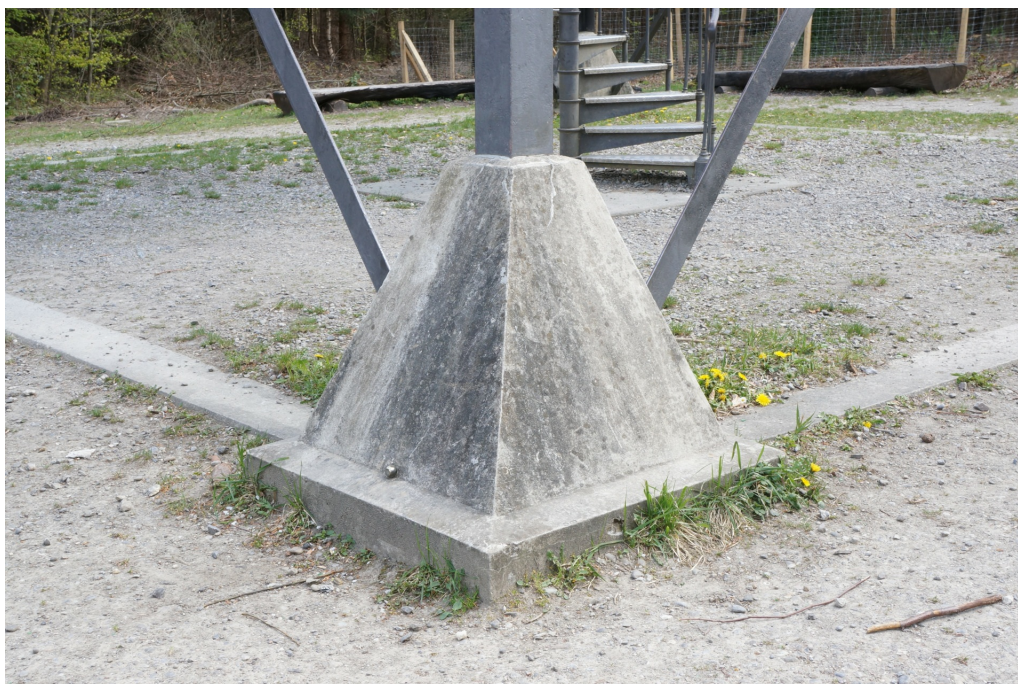
Aussichtsturm Eschenberg und Turmfussweg, Aussichtsturm Eschenberg (230MATURM01765), oberirdischer Teil des Betonfundaments, 15.04.2014 (Bild Nr. D100624_25).
