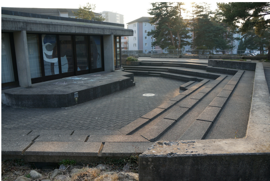
Schul- und Kindergartenanlage Gutschick, Singsaal (230MA07256) und Umgebung (230MAUMGEBU07255), vorgelagertes polygonales Amphitheater mit Aussenbühne, Ansicht von NO, 13.03.2014 (Bild Nr. D100618_34).
