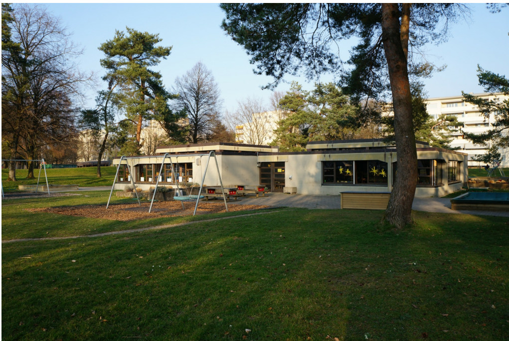
Schul- und Kindergartenanlage Gutschick, Kindergarten (230MA07258), Ansicht von SW, 13.03.2014 (Bild Nr. D100618_01).
