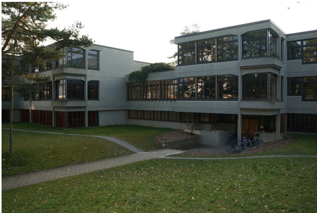
Schul- und Kindergartenanlage Gutschick, Schulhaus 1 (230MA07255), Ansicht von NO, 13.03.2014 (Bild Nr. D100618_16).
