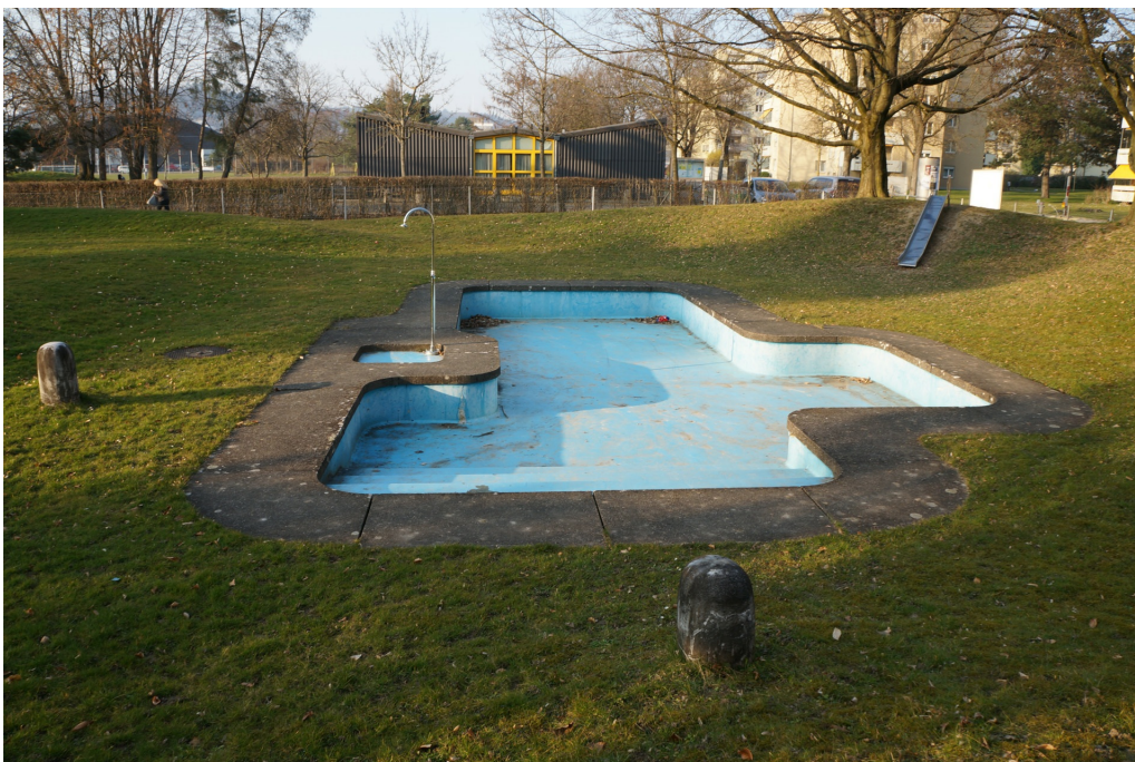
Schul- und Kindergartenanlage Gutschick, Umgebung (230MAUMGEBU07255), Wasserbecken, 13.03.2014 (Bild Nr. D100618_13).
