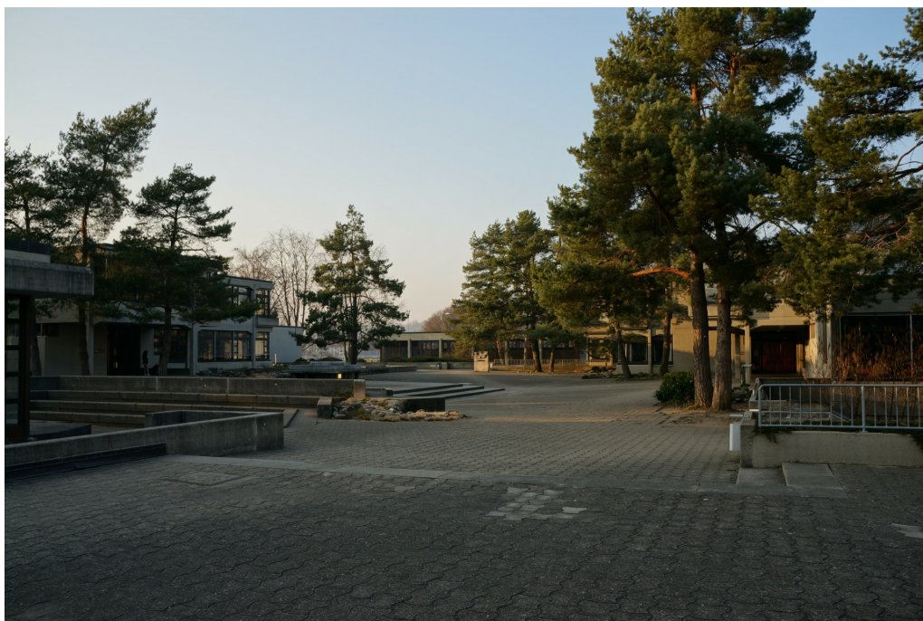
Schul- und Kindergartenanlage Gutschick, Umgebung (230MAUMGEBU07255), zentraler Platz, 13.03.2014 (Bild Nr. D100618_38).
