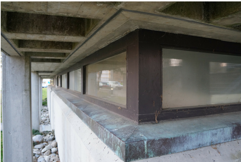
Schul- und Kindergartenanlage Gutschick, Tiefgarage neben dem Singsaal (230MA07256), bauzeitliche Gebäudeecke mit Holzrahmenbandfenster, 13.03.2014 (Bild Nr. D100618_39).
