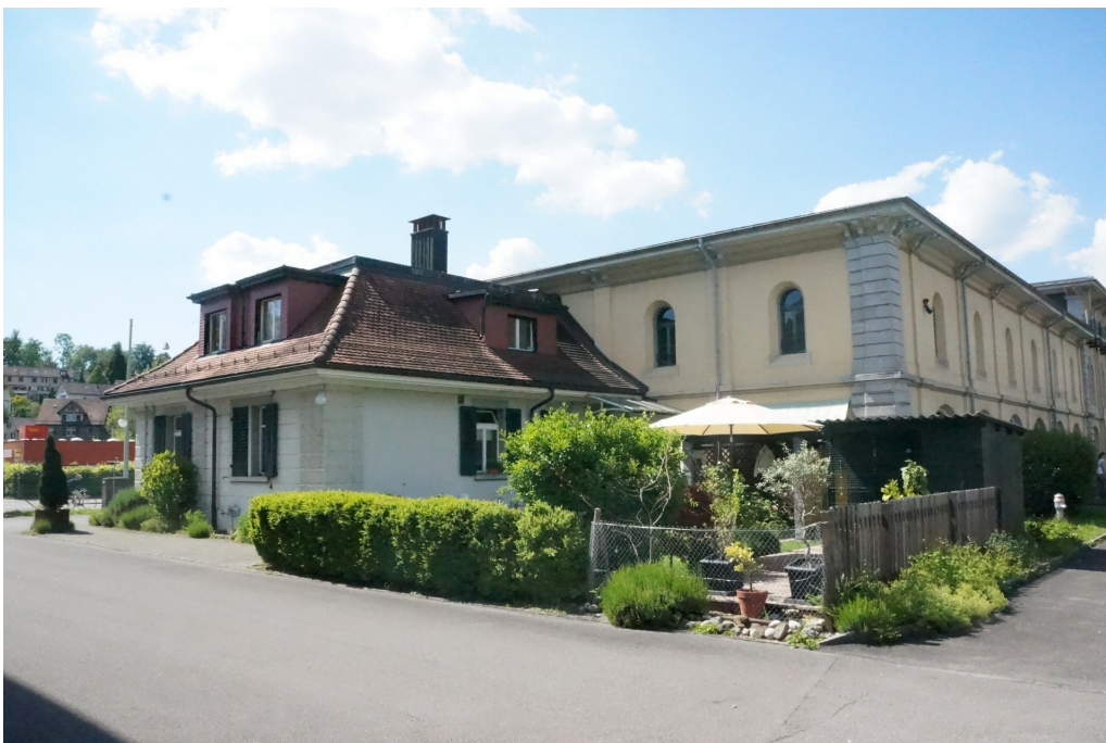
Zeughausareal Nord, Zeughaus West, ehem. Zeughaus 1 BA und Abwartswohnung (230MA01908), Abwartswohnung (I.), Ansicht von SO, 19.05.2014 (Bild Nr. D100632_01).
