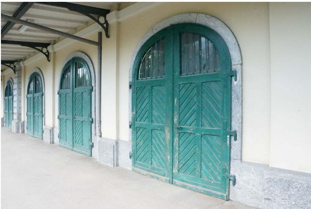
Zeughausareal Nord, Zeughaus West, ehem. Zeughaus 1 BA und Abwartswohnung (230MA01908), bauzeitliche Tore, 19.05.2014 (Bild Nr. D100632_18).
