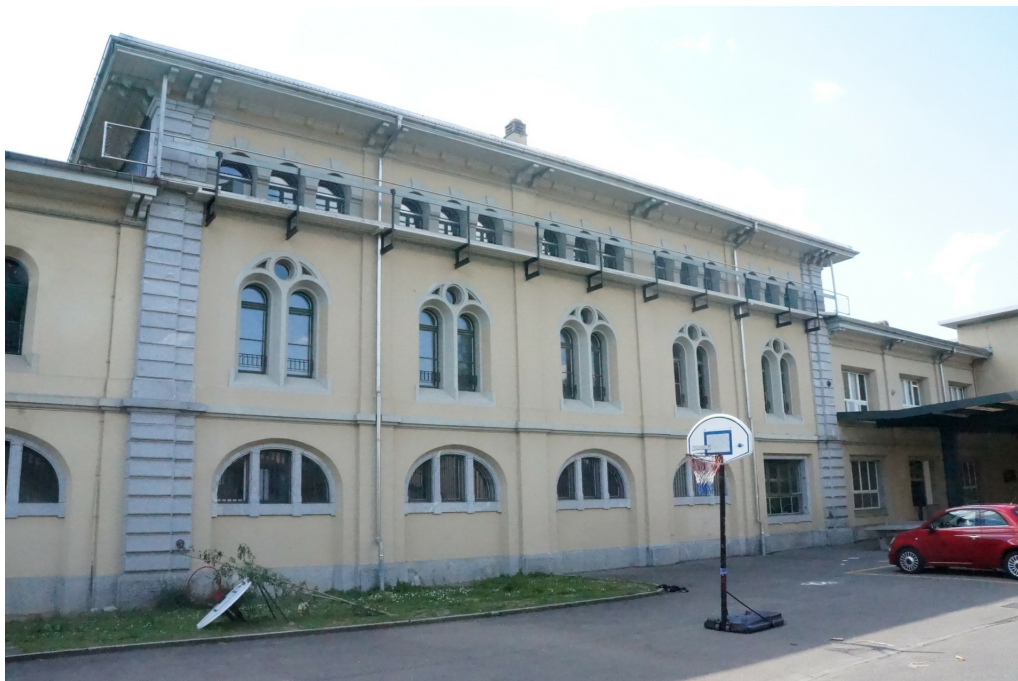
Zeughausareal Nord, Zeughaus West, ehem. Zeughaus 1 BA und Abwartswohnung (230MA01908), Mittelteil, Ansicht vom Innenhof, 19.05.2014 (Bild Nr. D100632_07).
