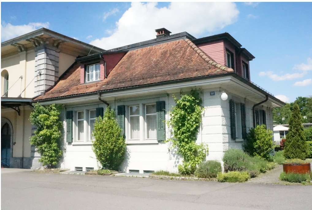
Zeughausareal Nord, Zeughaus West, ehem. Zeughaus 1 BA und Abwartswohnung (230MA01908), Abwartswohnung, Ansicht von SW, 19.05.2014 (Bild Nr. D100632_03).
