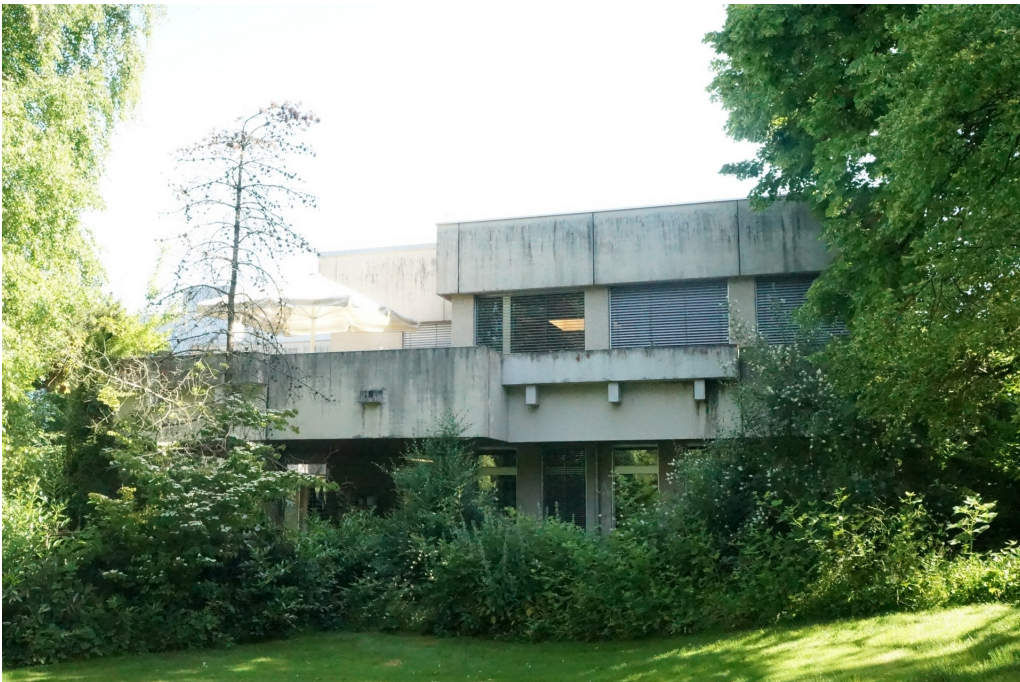
Klinik Schlosstal, ehem. Spinnerei Beugger, Erweiterungstrakt (230WUERWEIT00571), Ansicht von S und Gartenanlage (238GARTEN00571), 10.06.2014 (Bild Nr. D100648_16).
