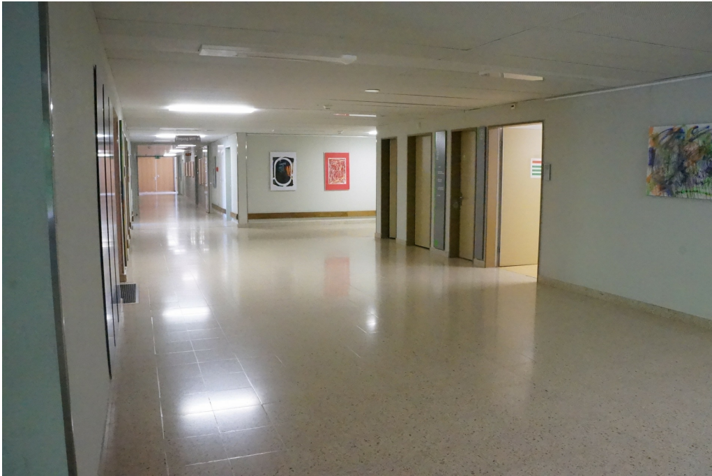
Klinik Schlosstal, ehem. Spinnerei Beugger, Erweiterungstrakt (230WUERWEIT00571), Verbindungsgang zur nordwestlichen Erweiterung im UG mit bauzeitlichem Belag aus Natursteinkonglomeratplatten, 10.06.2014 (Bild Nr. D100648_25).
