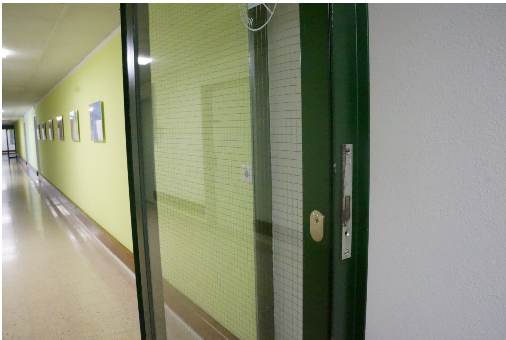
Klinik Schlosstal, ehem. Spinnerei Beugger, Erweiterungstrakt (230WUERWEIT00571), bauzeitliche Tür zum Verbindungsgang zur nordwestlichen Erweiterung im UG, 10.06.2014 (Bild Nr. D100648_27).
