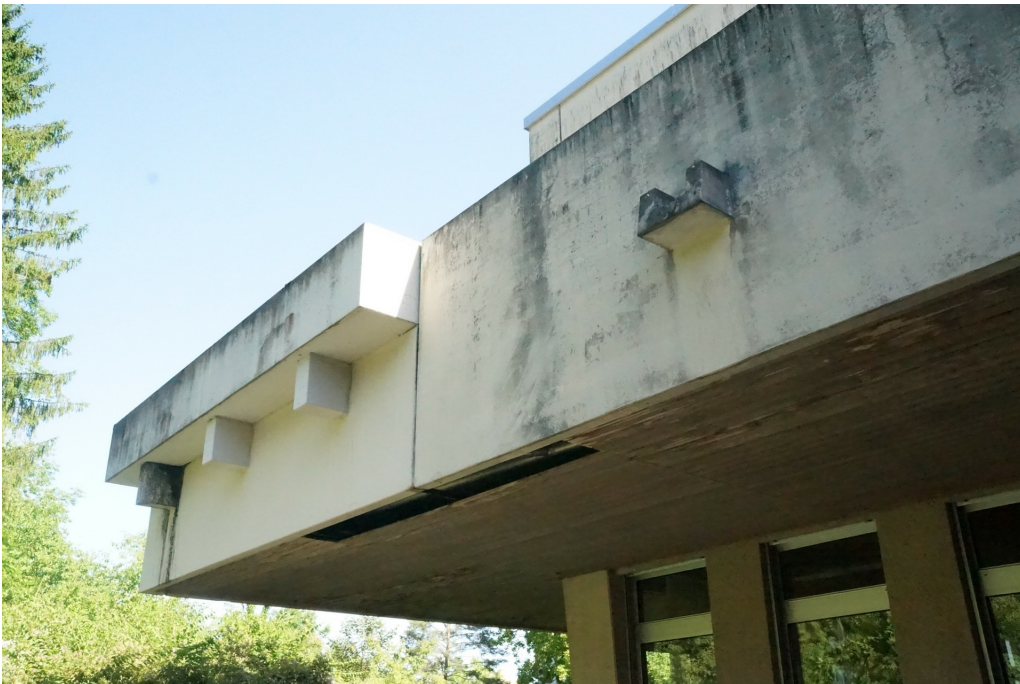
Klinik Schlosstal, ehem. Spinnerei Beugger, Erweiterungstrakt (230WUERWEIT00571), Terrasse mit bauzeitlichen Pflanztrögen, erneuerten Kragbalkenelementen und bauzeitlichem Wasserspeier, 10.06.2014 (Bild Nr. D100648_21).
