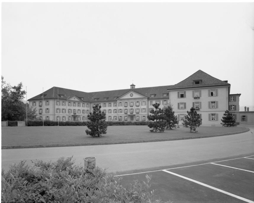
Klinik Schlosstal, ehem. Spinnerei Beugger, Hauptgebäude (230WU00571), Ansicht von SO, 01.01.1972 (Bild Nr. U34744).
