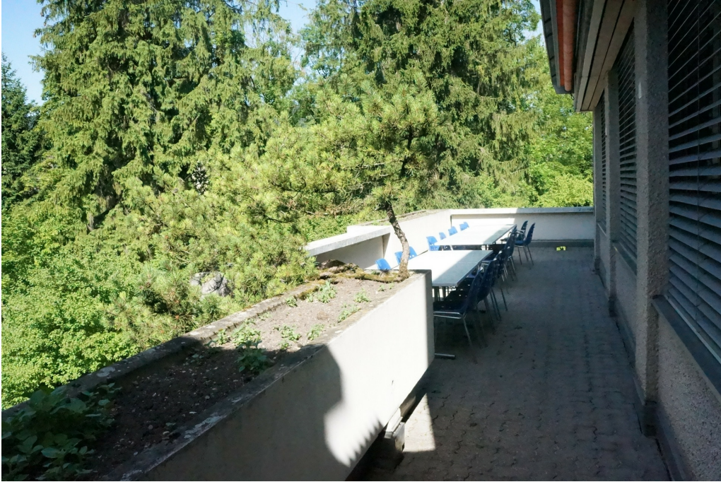
Klinik Schlosstal, ehem. Spinnerei Beugger, Erweiterungstrakt (230WUERWEIT00571), Cafeteria, Terrasse mit Pflanztrögen, bauzeitliche Lamellenstoren, 10.06.2014 (Bild Nr. D100648_11).
