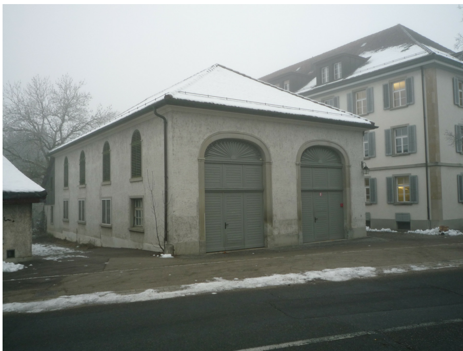
Klinik Schlosstal, ehem. Spinnerei Beugger, Ökonomiegebäude (230WU00575), Ansicht von SO, 28.11.2008 (Bild Nr. D101140_07).
