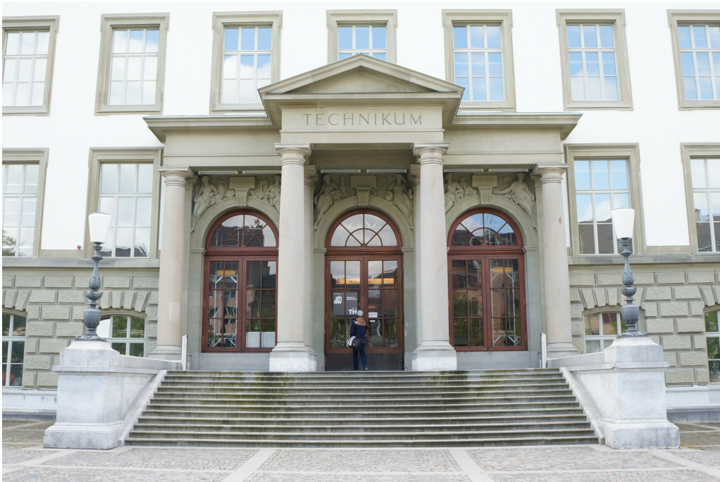
Bauten der Zürcher Hochschule für Angewandte Wissenschaften, ehem. Technikum, Hauptgebäude (230ST01194), Nordfassade, Portikus mit Haupteingang in der Mittelachse des EG, 15.04.2014 (Bild Nr. D100610_19).
