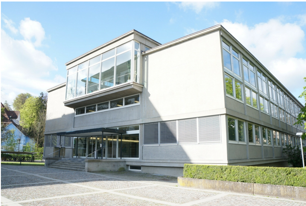
Bauten der Zürcher Hochschule für Angewandte Wissenschaften, ehem. Technikum, Physikgebäude (230ST00471), Ansicht von NO, 15.04.2014 (Bild Nr. D100610_02).
