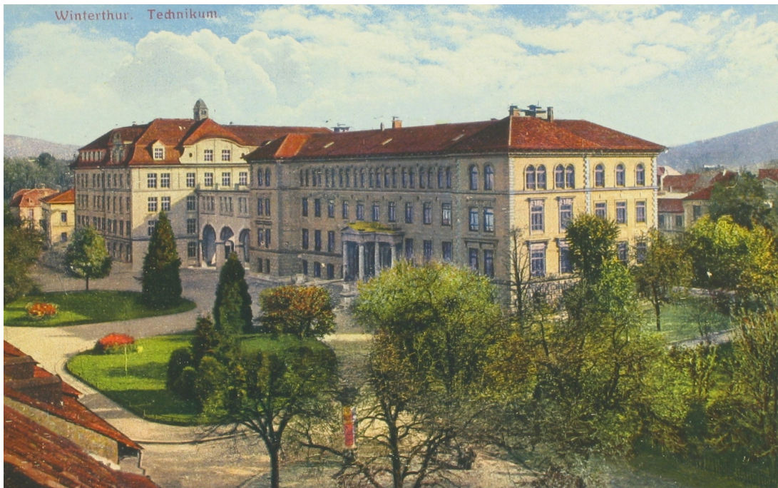
Bauten der Zürcher Hochschule für Angewandte Wissenschaften, ehem. Technikum, Hauptgebäude (230ST01194) und Ostgebäude mit Erweiterungsbau (230ST02740) mit Verbindungsgang (230ST07099), Ansicht von NW, Postkarte, Bild: ETH-Bibliothek, Sign. Fel_001511-RE, 21.10.1920 (Bild Nr. D100610_27).
