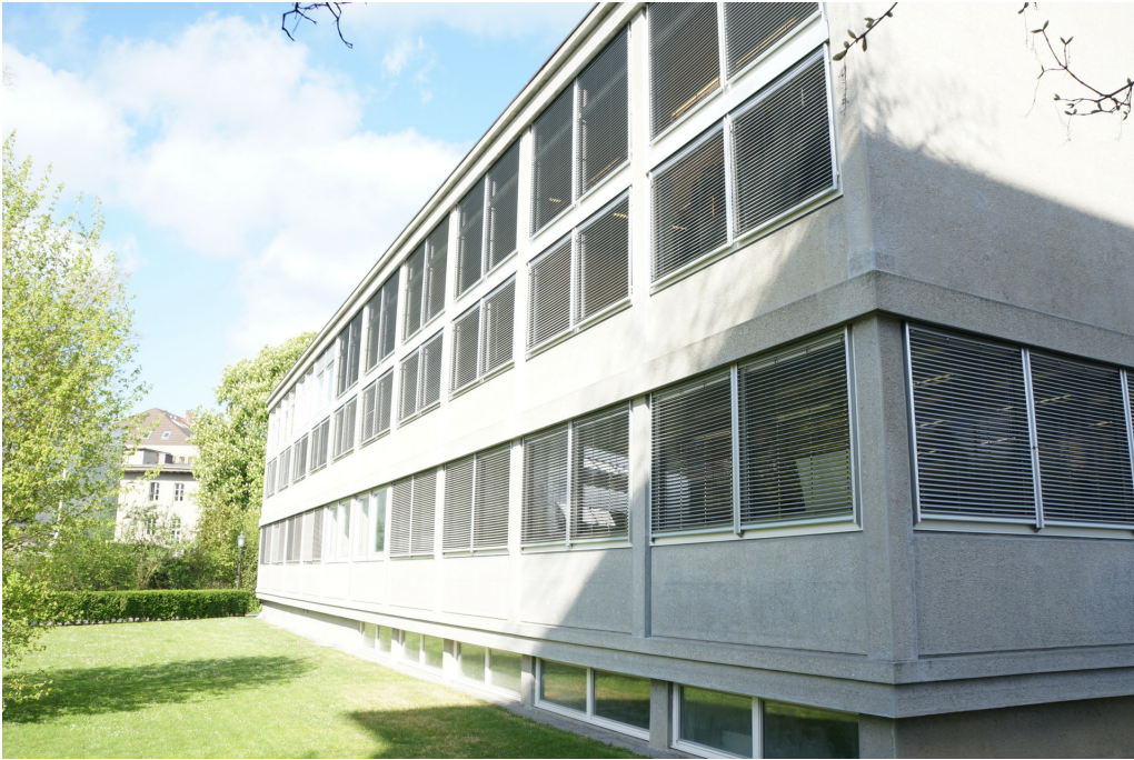
Bauten der Zürcher Hochschule für Angewandte Wissenschaften, ehem. Technikum, Physikgebäude (230ST00471), Ansicht von SO, 15.04.2014 (Bild Nr. D100610_06).
