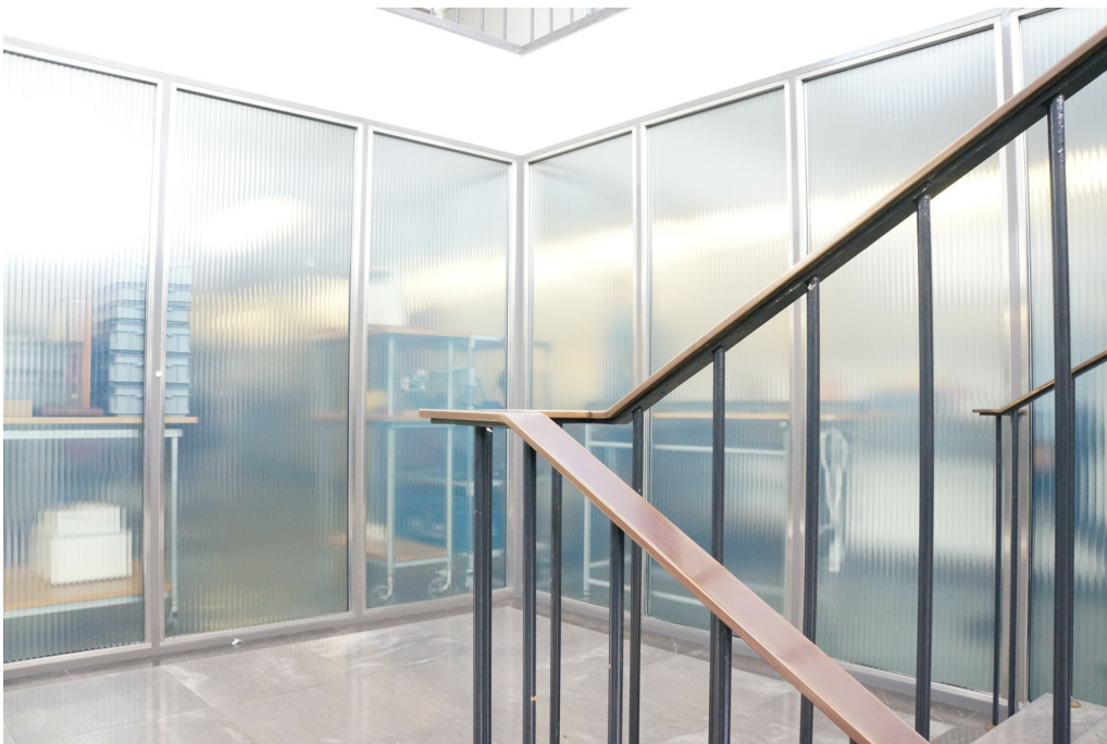
Bauten der Zürcher Hochschule für Angewandte Wissenschaften, ehem. Technikum, Physikgebäude (230ST00471), zentrale Treppenanlage, Zwischengeschoss mit bauzeitlichen Glaswänden, 15.04.2014 (Bild Nr. D100610_09).
