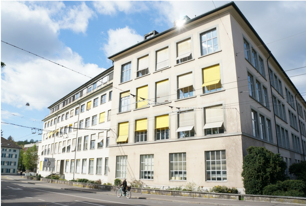
Bauten der Zürcher Hochschule für Angewandte Wissenschaften, ehem. Technikum, Ostgebäude mit Erweiterungsbau (230ST02740), Erweiterungsbau, links das angebaute Chemiegebäude (230ST02740, südöstlicher Teil), Ansicht von NO, 15.04.2014 (Bild Nr. D100610_22).
