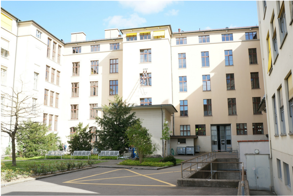
Bauten der Zürcher Hochschule für Angewandte Wissenschaften, ehem. Technikum, Ostgebäude mit Erweiterungsbau (230ST02740), Innenhof, Ansicht von S, 15.04.2014 (Bild Nr. D100610_01).
