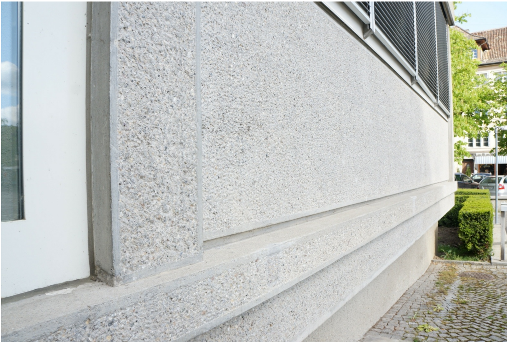
Bauten der Zürcher Hochschule für Angewandte Wissenschaften, ehem. Technikum, Physikgebäude (230ST00471), Rauputz imitierende Betonbearbeitung an der Ostfassade, 15.04.2014 (Bild Nr. D100610_17).
