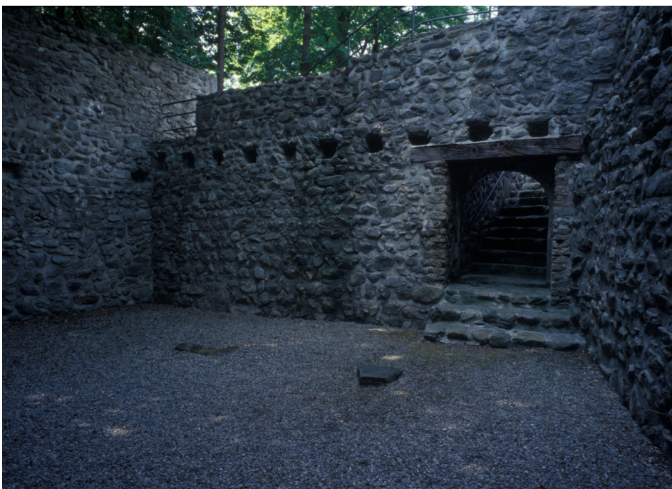
Mörsburg, Umgebung (230OBUMGEBU00327), Reste der Vorburg, ehem. Keller mit Treppenaufgang und Balkenlöchern für die ehem. Erdgeschossdecke, 29.06.2000 (Bild Nr. D100541_11).
