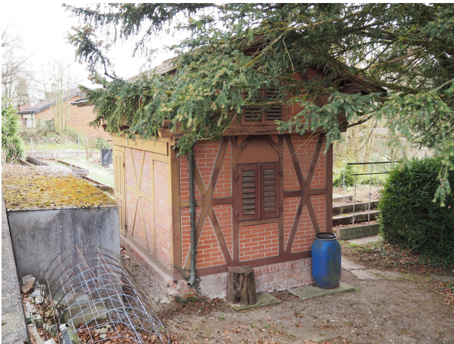
Ensemble Villa «Bühlhalde», Schopf (230ST00378), Ansicht von NW, 21.03.2017 (Bild Nr. D101130_43).
