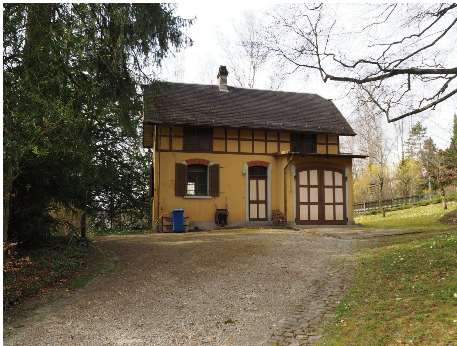
Ensemble Villa «Bühlhalde», Gerätehaus (230ST02419), Ansicht von SO, 21.03.2017 (Bild Nr. D101130_42).
