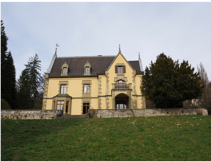
Ensemble Villa «Bühlhalde», Villa (230ST00878), Ansicht von SW, 21.03.2017 (Bild Nr. D101130_40).
