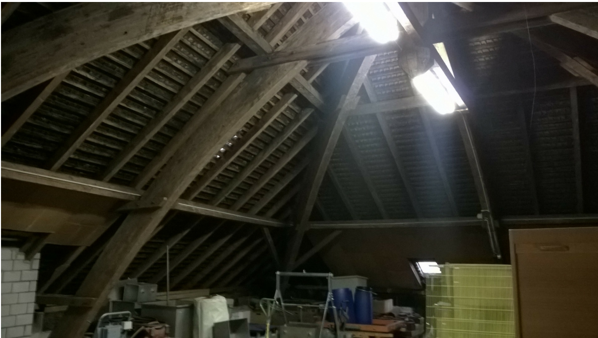
Weinkellerei, Lagergebäude, Dachstuhl, 18.08.2015 (Bild Nr. D101066_15).
