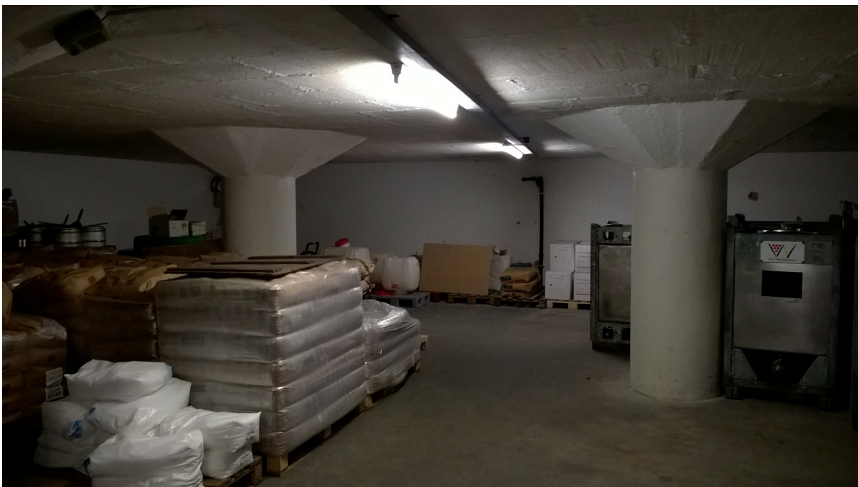
Weinkellerei, Lagergebäude, 4. OG, 18.08.2015 (Bild Nr. D101066_24).
