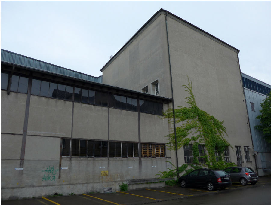
Weinkellerei, Magazingebäude (I.), Lagergebäude (M.) und Erweiterung, Ansicht von NW, 18.08.2015 (Bild Nr. D101066_09).
