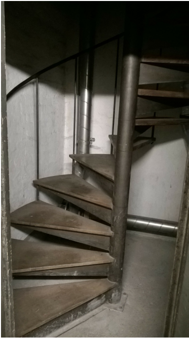
Weinkellerei, Lagergebäude, 4. OG, bauzeitliche Wendeltreppe zum Dachstuhl, 18.08.2015 (Bild Nr. D101066_19).
