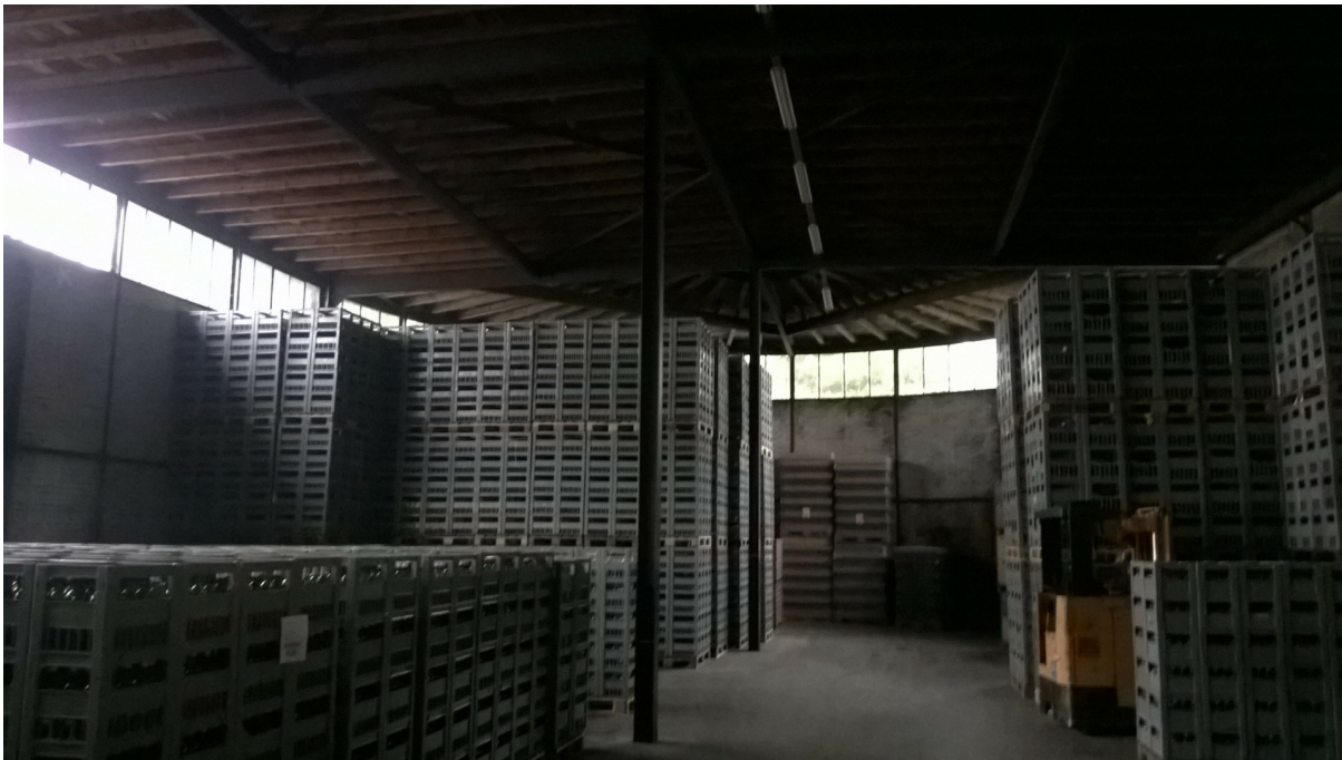
Weinkellerei, Magazingebäude, Ansicht gegen N, 18.08.2015 (Bild Nr. D101066_31).
