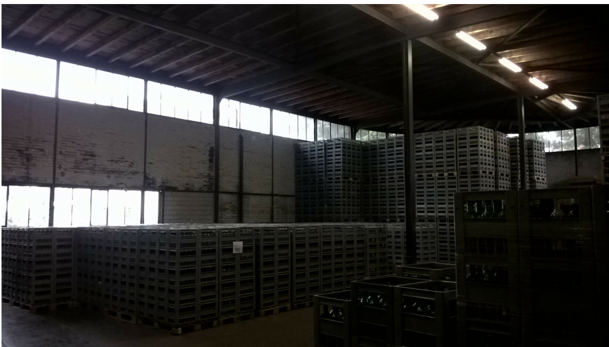
Weinkellerei, Magazingebäude, Ansicht gegen NW, 18.08.2015 (Bild Nr. D101066_33).
