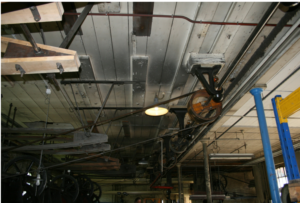
Maschinenpark der Schweizerischen Nagelfabrik, Transmissionssystem, 25.08.2016 (Bild Nr. D101112_08).
