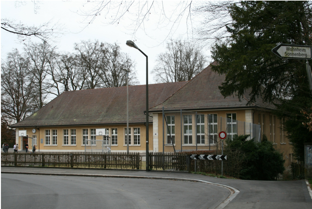
Schulanlage Heiligberg, Turnhalle (230ST02827), Ansicht von S, 21.03.2017 (Bild Nr. D101128_11).
