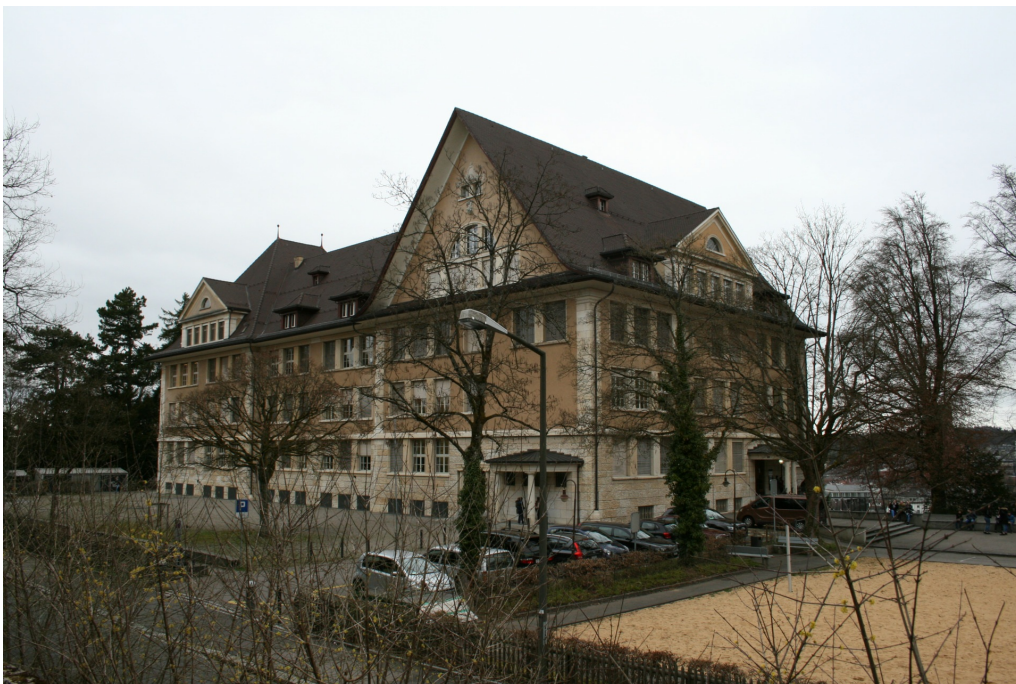
Schulanlage Heiligberg, Schulhaus (230ST02861), Ansicht von SO, 21.03.2017 (Bild Nr. D101128_12).
