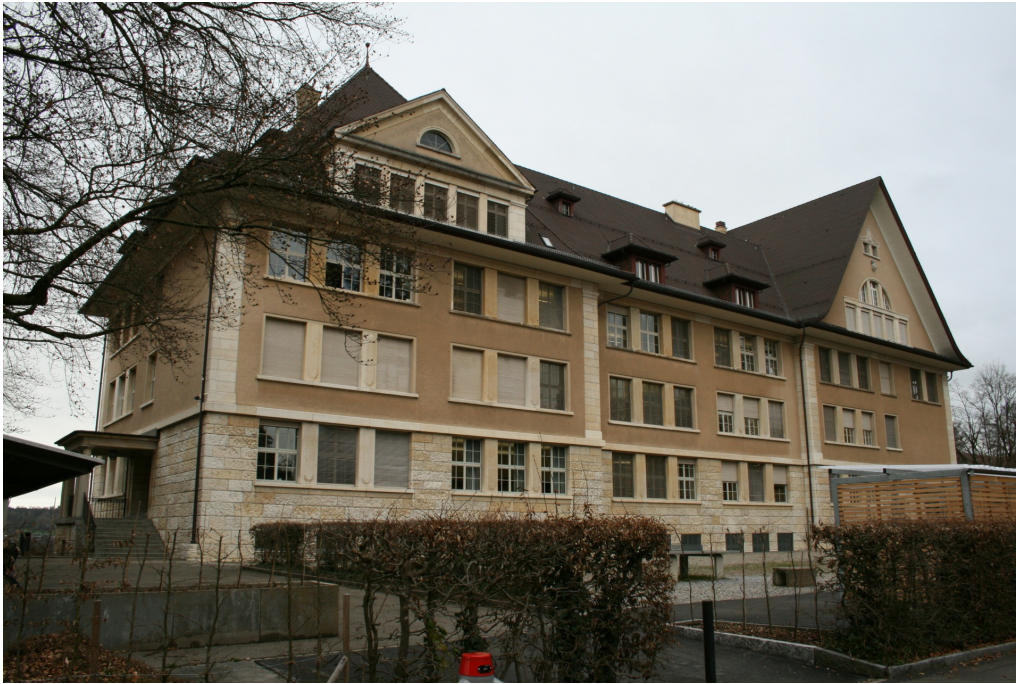
Schulanlage Heiligberg, Schulhaus (230ST02861), Ansicht von SW, 21.03.2017 (Bild Nr. D101128_13).
