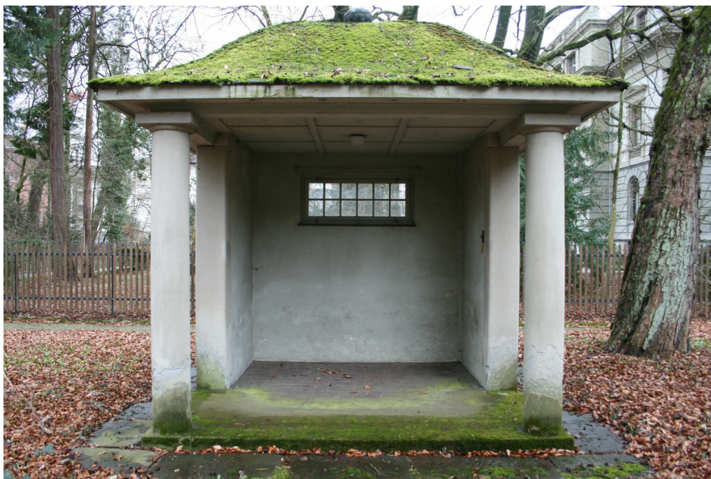
Ensemble «Lindgüetli», Gartenpavillon (230STPAVILL00916), Ansicht von O, 28.02.2017 (Bild Nr. D101135_44).
