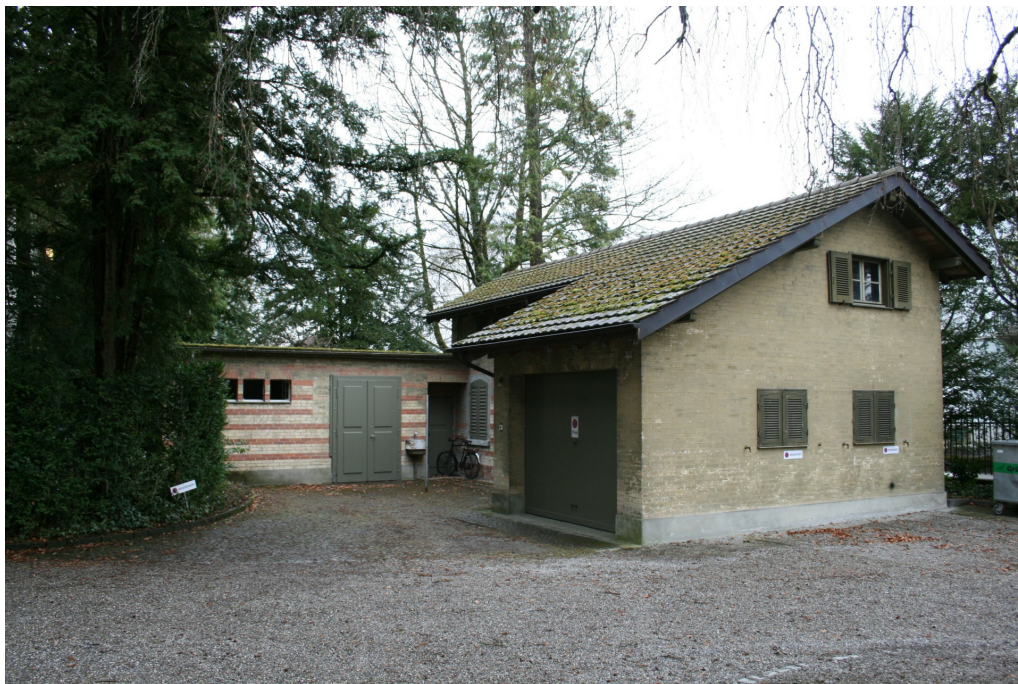
Ensemble «Lindgüetli», Waschhaus/Garage (230ST01286), Ansicht von SO, 28.02.2017 (Bild Nr. D101135_42).
