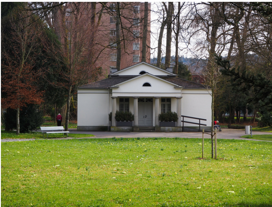
Ensemble «Adlergarten», Pavillon (230MA00091), Ansicht von N, 21.03.2017 (Bild Nr. D101128_60).
