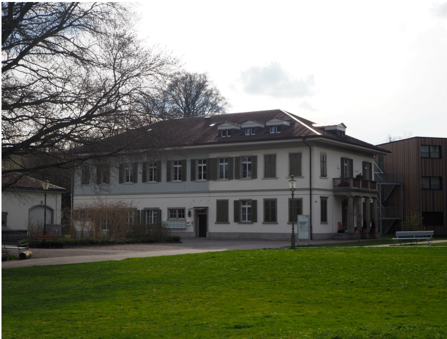
Ensemble «Adlergarten», ehem. Ökonomiegebäude (230MA00089), Ansicht von NO, 21.03.2017 (Bild Nr. D101128_63).
