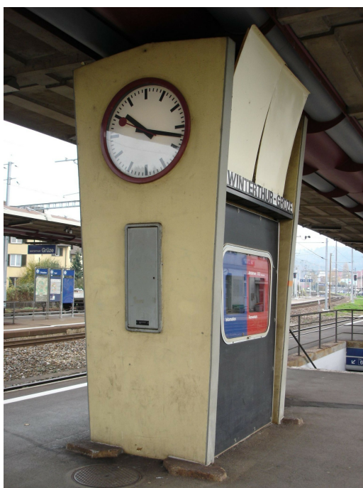
Bahnhof Winterthur Grüze, Perrondächer, Doppelwandträger des südwestlichen Perrondachs mit Ankunfts- und Abfahrtsanzeige, Abgang zur Unterführung, 10.11.2004 (Bild Nr. D100608_23).
