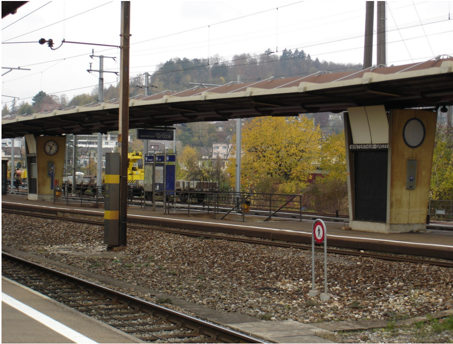
Bahnhof Winterthur Grütze, Perrondächer, nordöstliches Perrondach, Ansicht von SO, 10.11.2004 (Bild Nr. D100608_13).
