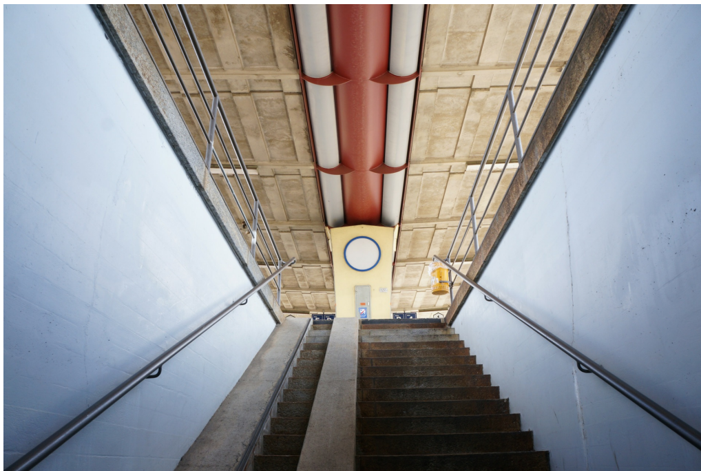
Bahnhof Winterthur Grüze, Perrondächer, Treppenaufgang zu Perron 2 und Dachuntersicht des südwestlichen Perrondachs mit Beton-Fertigelementen, 15.04.2014 (Bild Nr. D100608_43).
