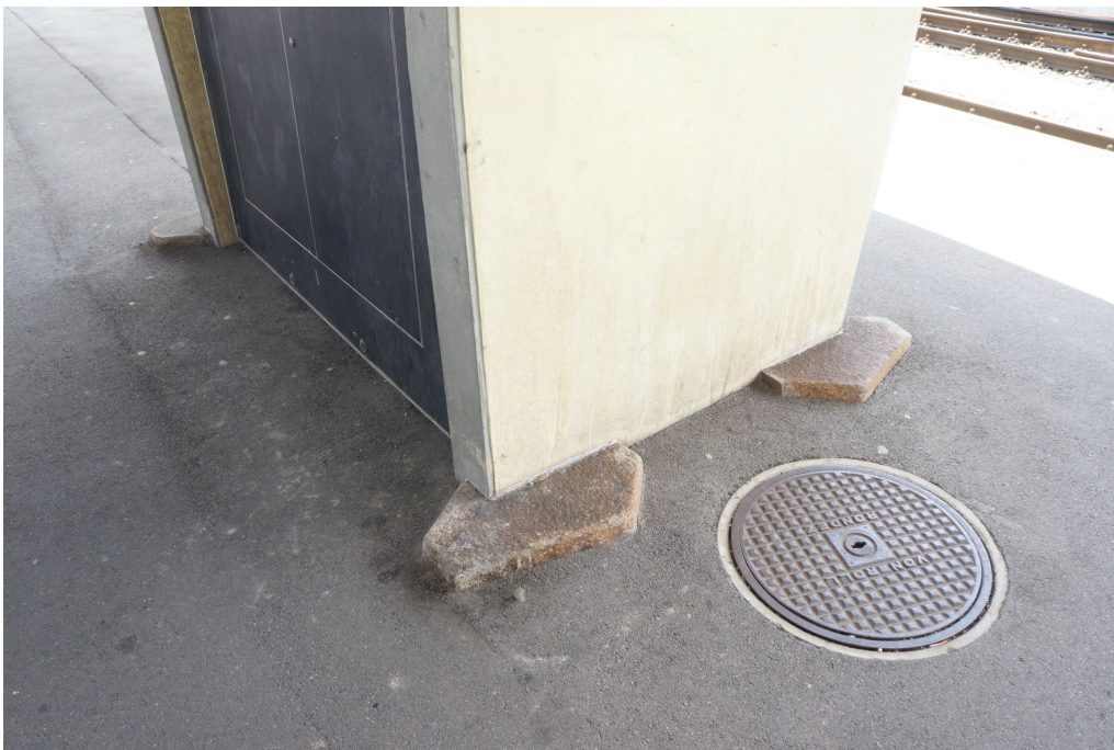
Bahnhof Winterthur Grütze, Perrondächer, südwestliches Perrondach, Doppelwandträger, Granitfundamente, 15.04.2014 (Bild Nr. D100608_47).
