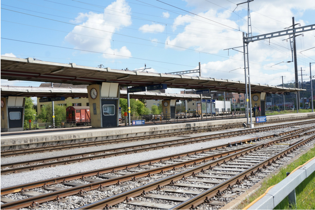
Bahnhof Winterthur Grüze, Perrondächer, Ansicht von S, 15.04.2014 (Bild Nr. D100608_37).
