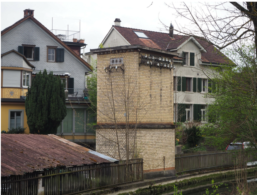
Transformatorstation «Gätzibrunnen», Ansicht von NW, 05.04.2017 (Bild Nr. D101120_96).
