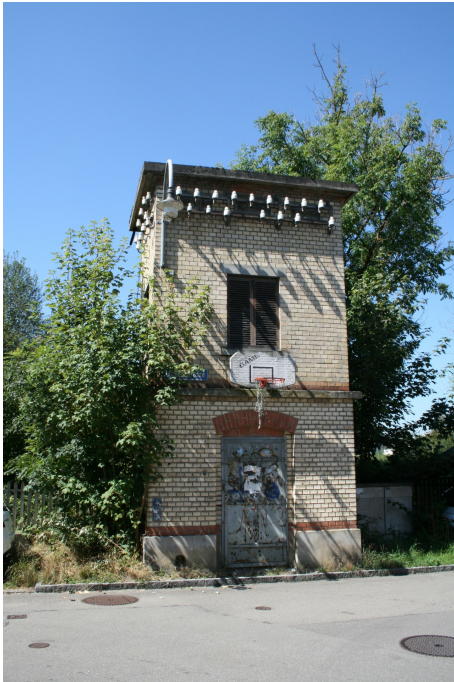
Transformatorstation «Gätzibrunnen», Ansicht von O, 25.08.2016 (Bild Nr. D101120_95).
