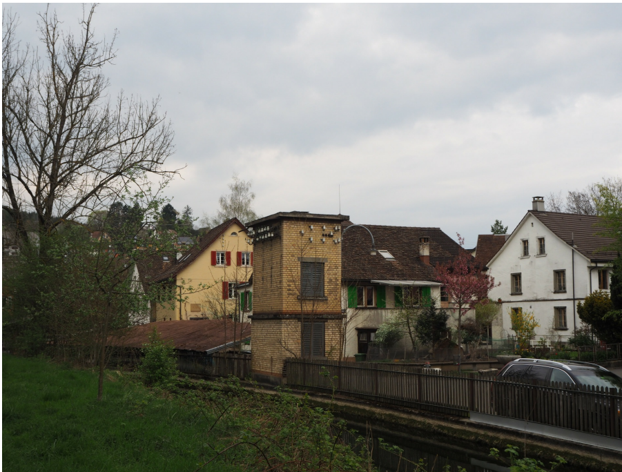
Transformatorstation «Gätzibrunnen», Ansicht von SW, 05.04.2017 (Bild Nr. D101120_97).
