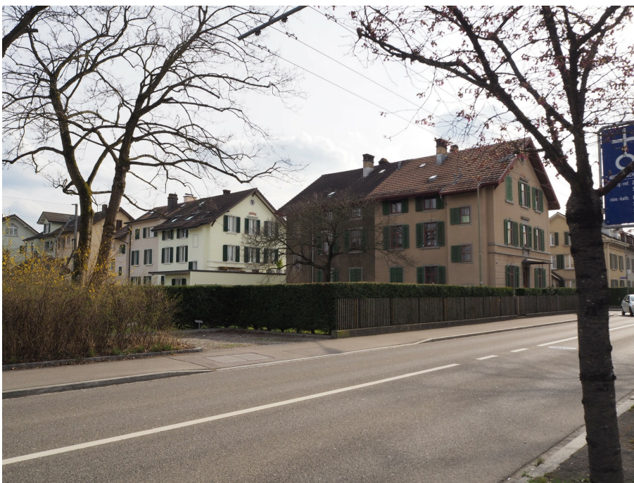
Arbeiterwohnhäuser, Ansicht von N, 01.03.2017 (Bild Nr. D101130_04).
