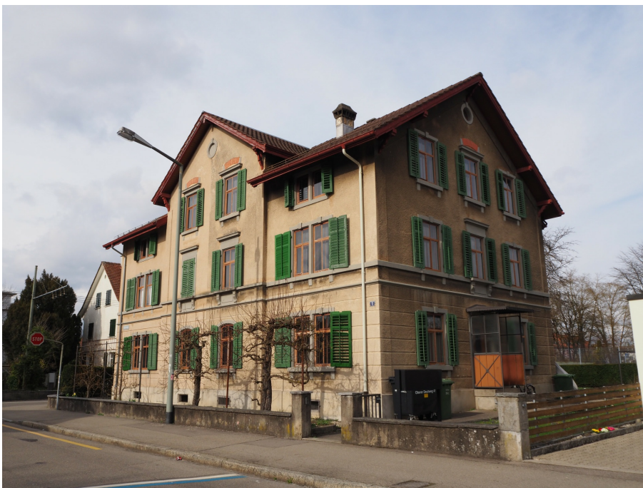
Arbeiterwohnhäuser, Ansicht von S, 01.03.2017 (Bild Nr. D101130_02).
