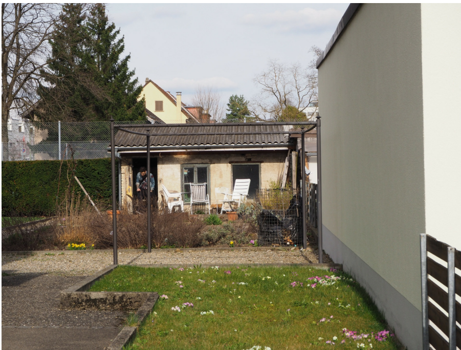
Arbeiterwohnhäuser, Schopf (230MA03869) mit bauzeitlichen Wäschestangen und Gartenbeeten, Ansicht von SW, 01.03.2017 (Bild Nr. D101130_03).
