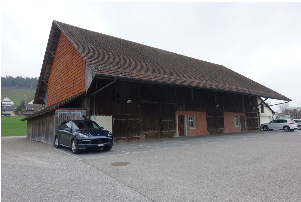
Ensemble Schloss Wülflingen, Scheune (230WU00387), Ansicht von W, 24.03.2017 (Bild Nr. D101663_02).
