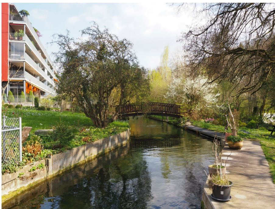
«Wespimühle», Oberwasserkanal (230WUWR00082-02), Ansicht von NW, 06.04.2017 (Bild Nr. D100650_18).
