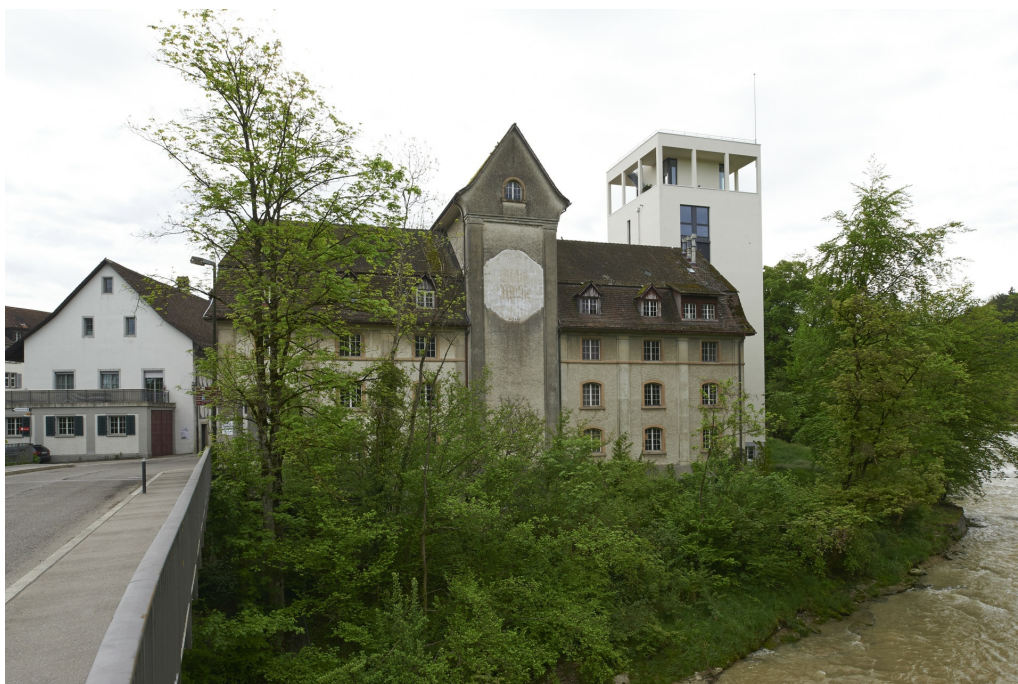
Wespimühle, Gesamtanlage, Ansicht von W, 06.04.2017 (Bild Nr. D101043_13).
