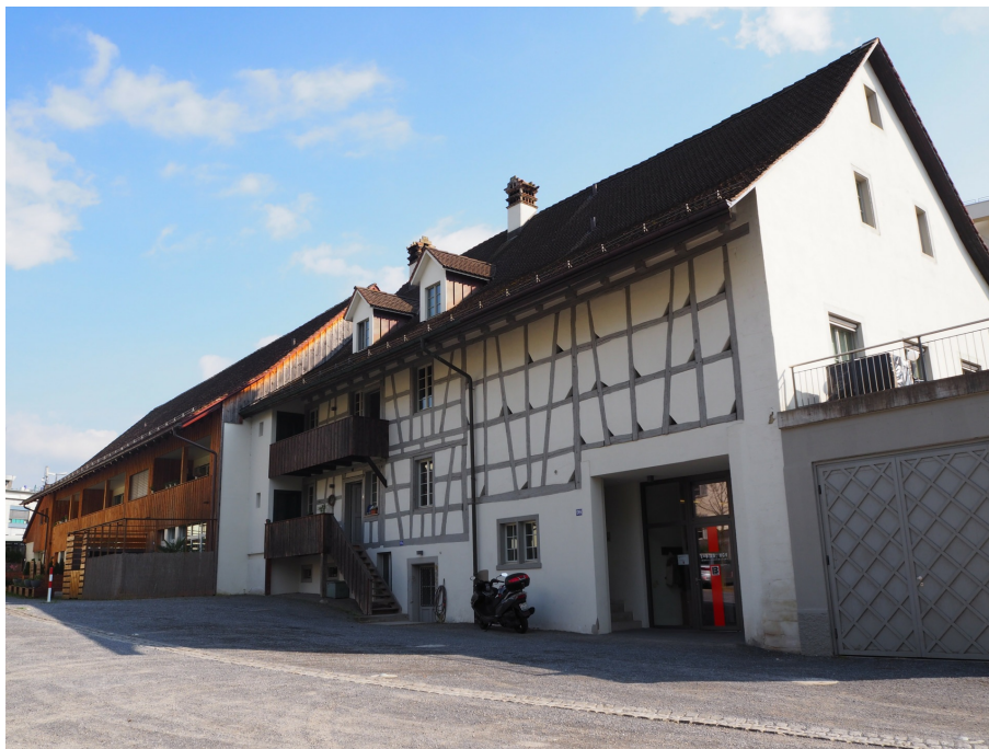
«Wespimühle», Wohn- und Ökonomiegebäude (230WU00578), Ansicht von NW, 06.04.2017 (Bild Nr. D100650_23).
