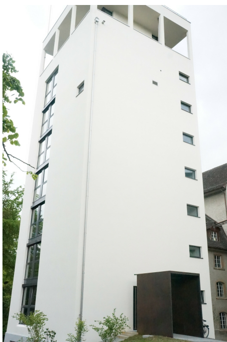
«Wespimühle», ehem. Siloturm (230WUSILO00581), Ansicht von SO, 15.04.2014 (Bild Nr. D100650_04).
