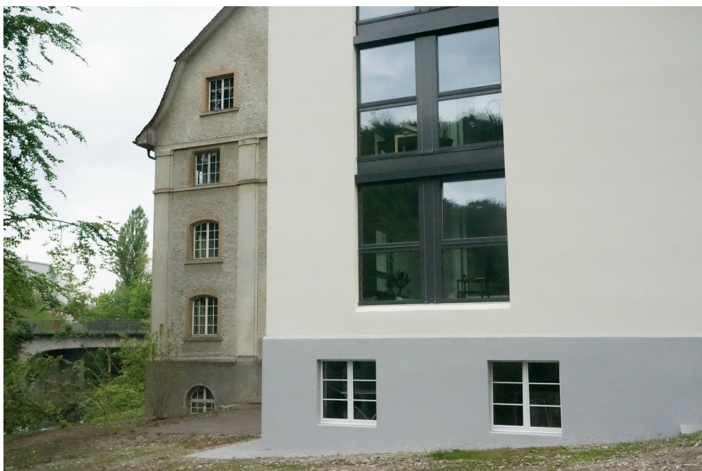
«Wespimühle», ehem. Siloturm (230WUSILO00581), Sockelgeschoss, EG und 1. OG, Ansicht von S, 15.04.2014 (Bild Nr. D100650_05).
