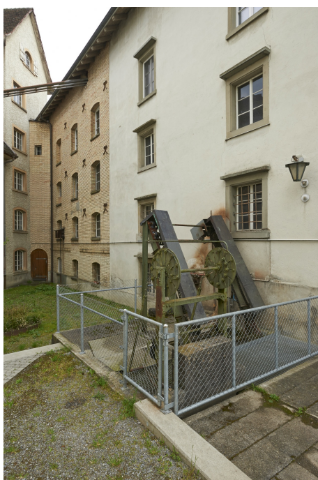
Wespimühle, Mühlegebäude mit Büro- und Gewerberäumen und Turbinenhaus (230WU00581) mit Rechenanlage (230WUWR00082-03), Ansicht von O, 06.04.2017 (Bild Nr. D101043_16).
