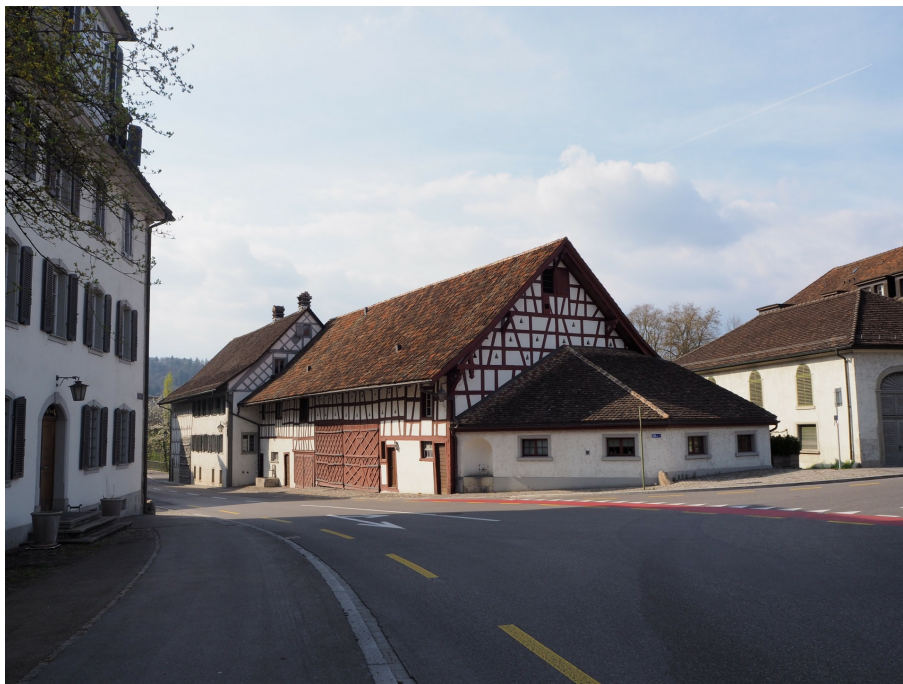
«Wespimühle», Wohn- und Ökonomiegebäude (230WU00578), Ansicht von SO; links das Wohnhaus der ehem. Spinnerei Beugger (230WU00584), rechts das Ökonomiegebäude (230WU00575), 06.04.2017 (Bild Nr. D100650_27).
