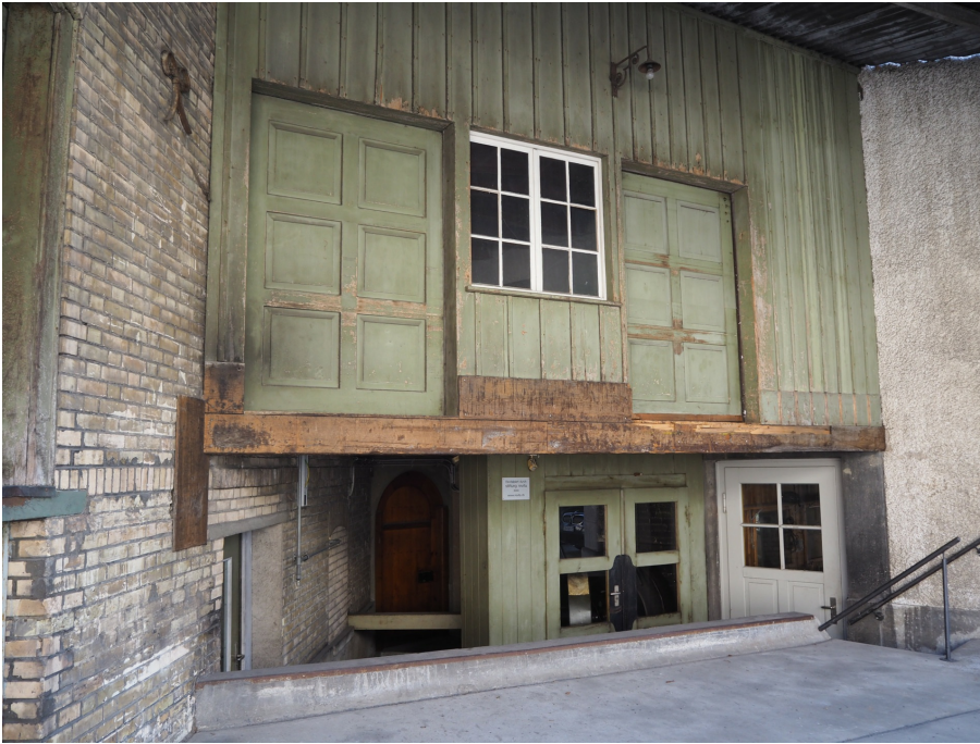
«Wespimühle», Mühlegebäude mit Büro- und Gewerberäumen und Turbinenhaus (230WU00581), Verbindungsgang, Detailansicht der Nordostfassade im EG, 06.04.2017 (Bild Nr. D100650_21).
