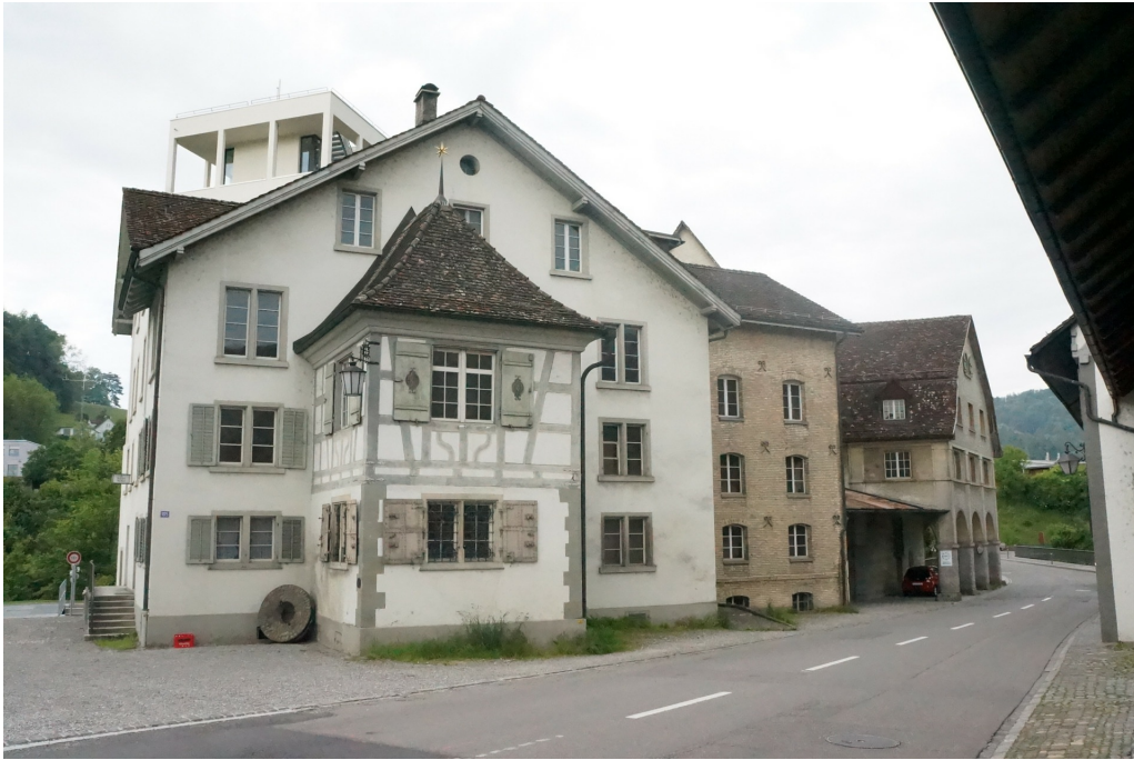
«Wespimühle», vorne die Mühlegebäude mit Büro- und Gewerberäumen und Turbinenhaus (230WU00581), dahinter der Siloturm (238SILO00581), 15.04.2014 (Bild Nr. D100650_01).
